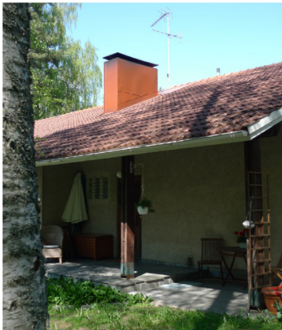
Tyylikäs alkuperäinen tiilikatto ja räystäsdetalji. Leveän räystään alla liuskekeivetty terassi.
