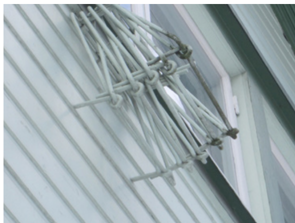
Alkuperäiset haitarimalliset hätäpoistumistikkaat voi säilyttää rakentamisajasta kertovana yksityiskohtana, vaikka niitä ei voisi enää käyttää alkuperäistarkoituksessaan.
