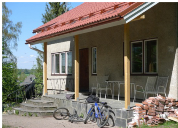
Terassin porras ja siro metallinen kaide. Askelmissa on päällysteenä liuskekivi. Tiilipilarin korvaaminen puupilarilla ei ole suositeltavaa.
