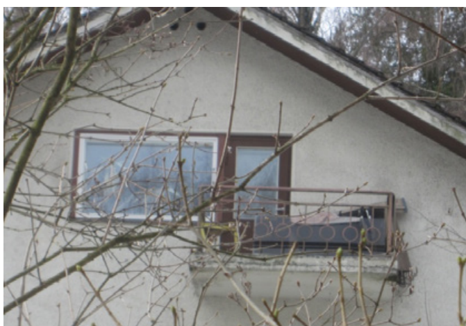
Jälleenrakennuskauden taloissa esiintyviä parvekemalleja. Yleisin kaiteen malli on siro metallikaide.
