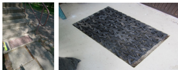
Mattosyvennyksen kumimatto tai upotettu metalliritilä on sisäänkäynnin huoliteltu yksityiskohta. Syvennyks on tehty laatan valutüiden yhteydessä.
