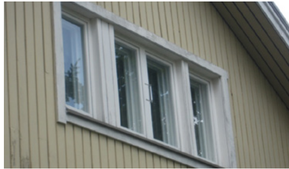
Ulkopuolelle lisätyn lämmöneristykseen seurauksena ikkunat ovat joutuneet upoksiin. Rakennus on menettänyt korjauksessa merkittävästi ominaispiirteitään. Julkisivulaudoituksen maalauskäsittely hilseilee jo.
