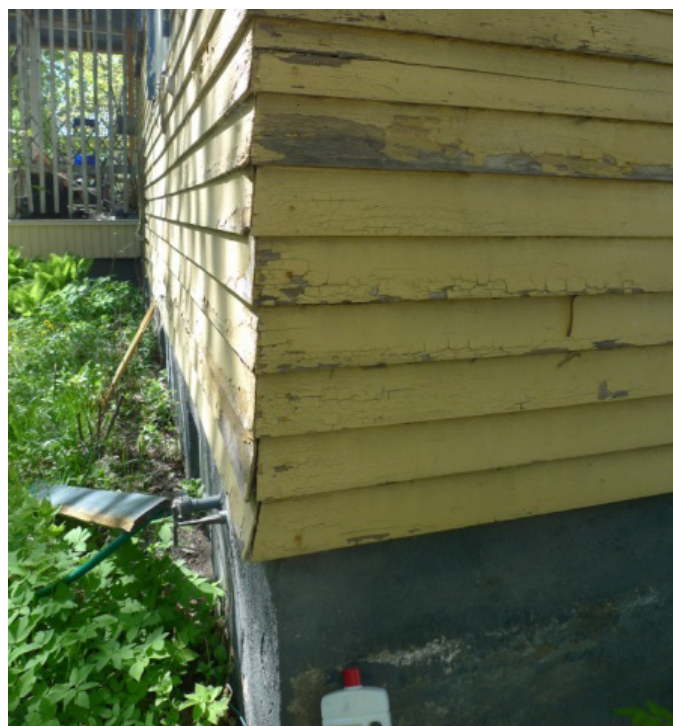
Jiiriin asetettu nurkka ilman nurkkalistoja on yksi jälleenrakennuskauden talon huoliteltuja yksityiskohtia, joka tulee korjauksessa säilyttää. Julkisivun pintaa on tärkeää hoitaa ja huoltaa säännöllisesti riippumatta ulkovuorauksen tyyppistä.
