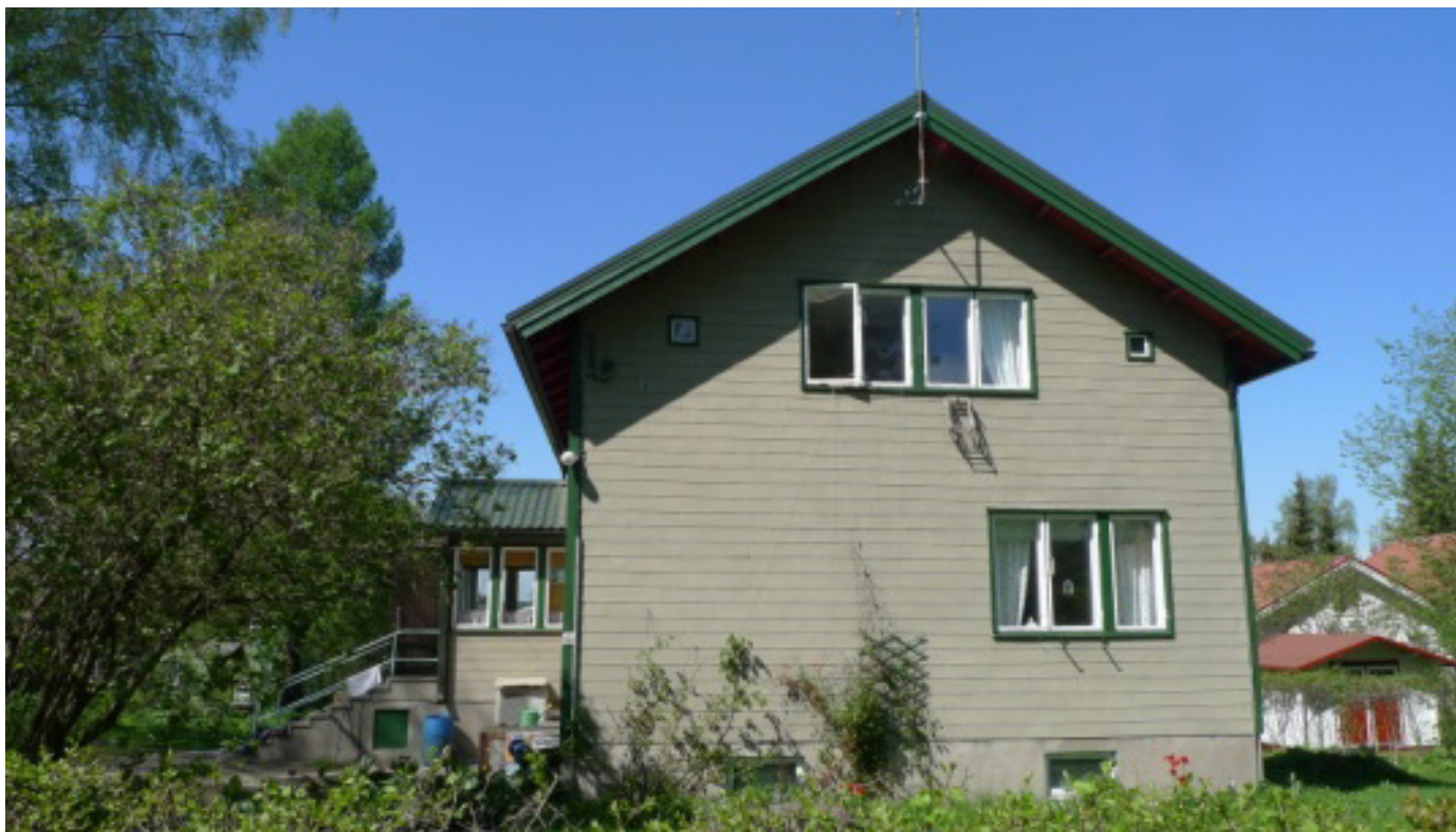
Alkuperäinen Minerit-verhous on hyvin säilynyt. Ikkunat ovat alkuperäiset 1950-luvun puuikkunat. Katon tiilikuvioitu peltikate tulee kuitenkin vaihtaa normaaliin peltikatteeseen seuraavan korjauksen yhteydessä.
