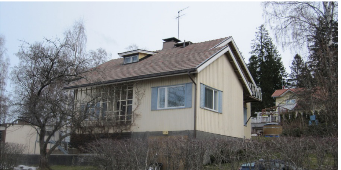
Alkuperäisen ikkunan suhteet ja malli on onnistuttu ikkunoita uusittaessakin säilyttämään. Kattolyhdyn ikkuna on alkuperäinen 1950-luvun ikkuna.
