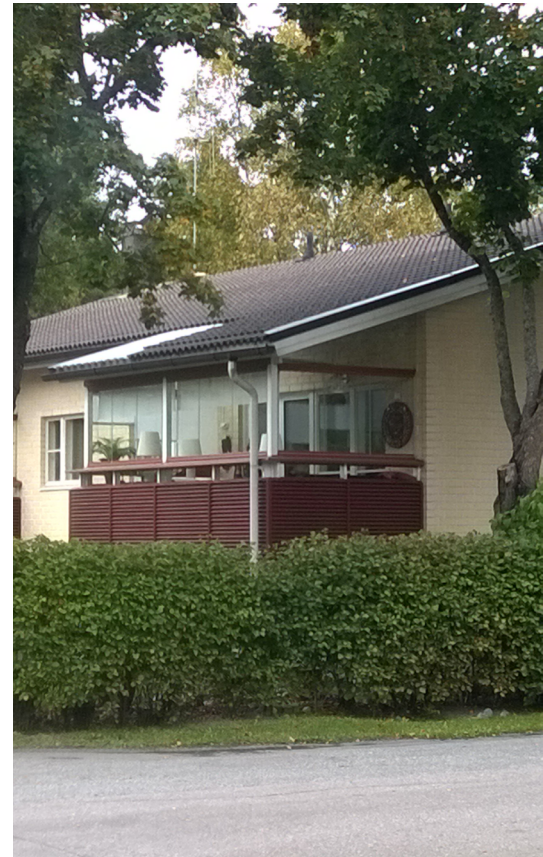
Omakoti- tai paritalossa lasitetun terassin rakentaminen vaatii toimenpide- tai rakennusluvan, jos terassi on yli 15 m 2 :n suuruinen.
