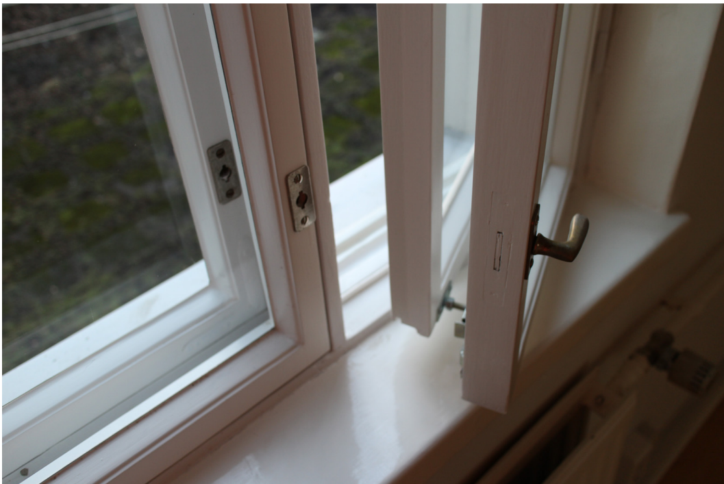
1950-luvun ikkunan tuuletusikkunan puitteet on kunnostamisen yhteydessä kytetty toisiinsa ja varustettu aukeamisrajoittimin.
