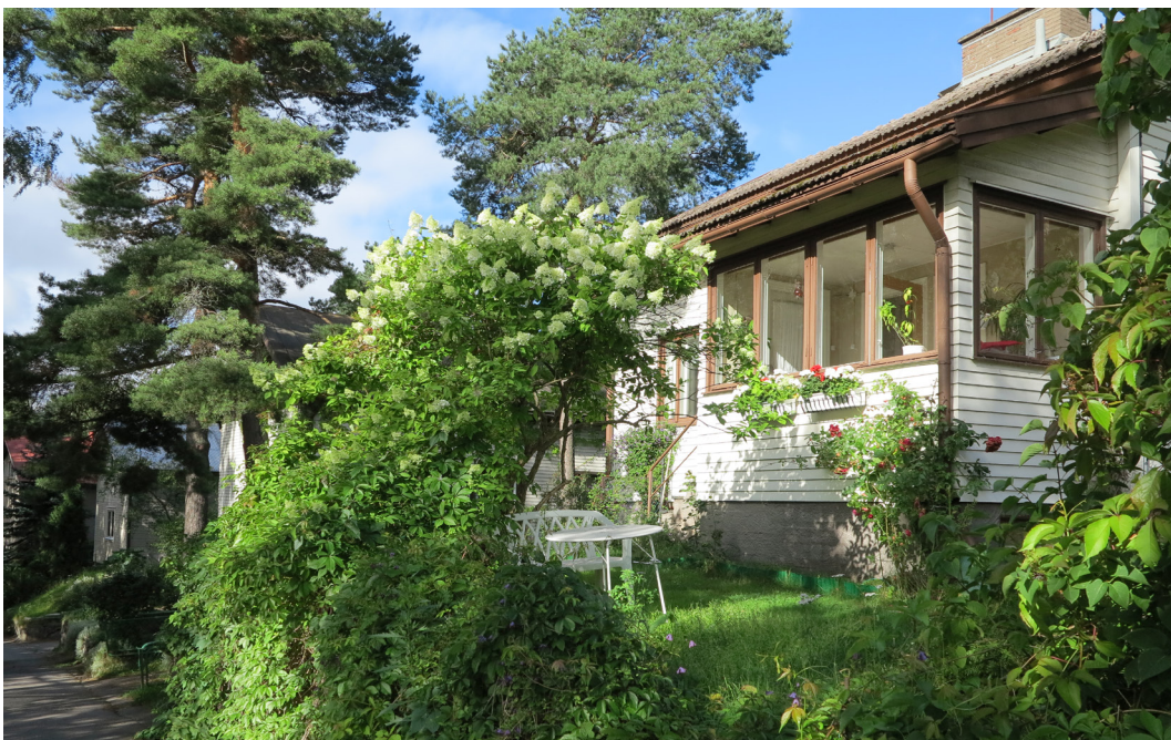
Uusitut ikkunat 1940-luvun jälleenrakennuskauden pientalossa.
