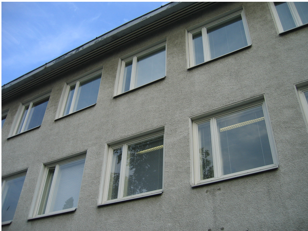
1950-luvun rakennuksen yksinkertaista ikkunajakoa ja sovitun rapattuun julkisivupintaan.
