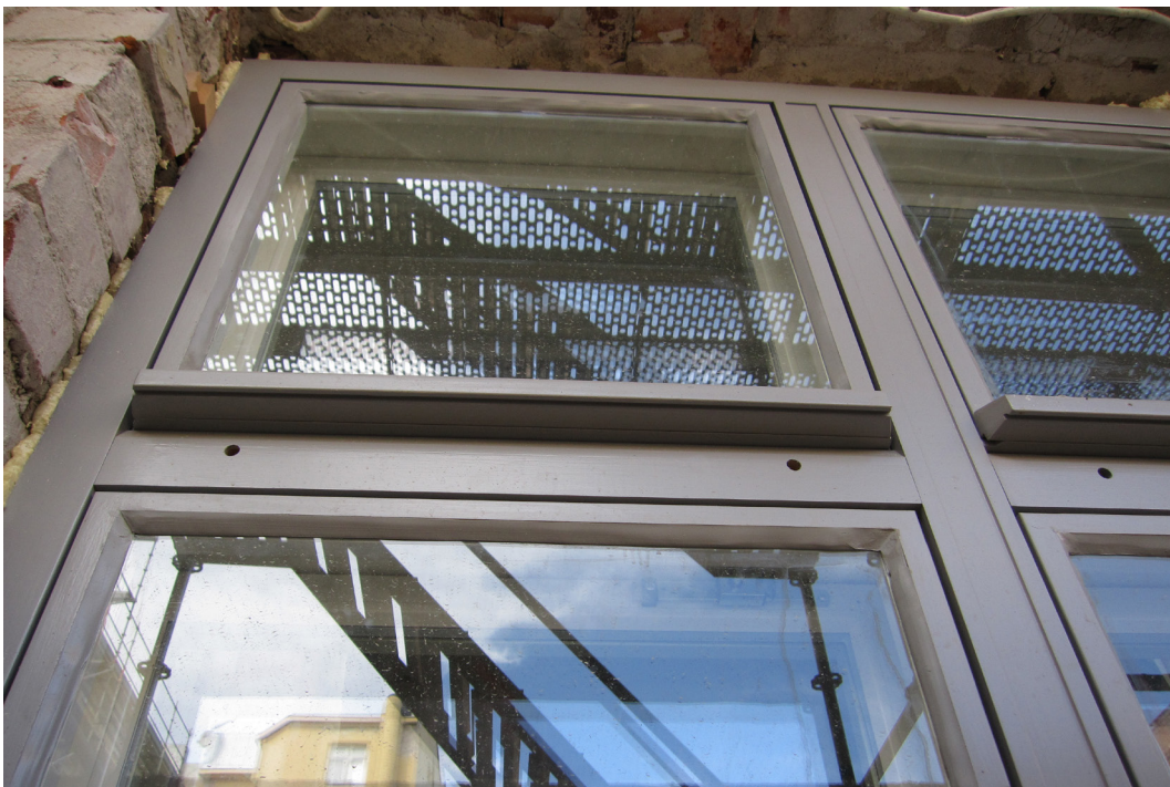
Sisään-sisään aukeavaksi muutettu uusi puuikkuna 1920-luvun rakennuksessa.
