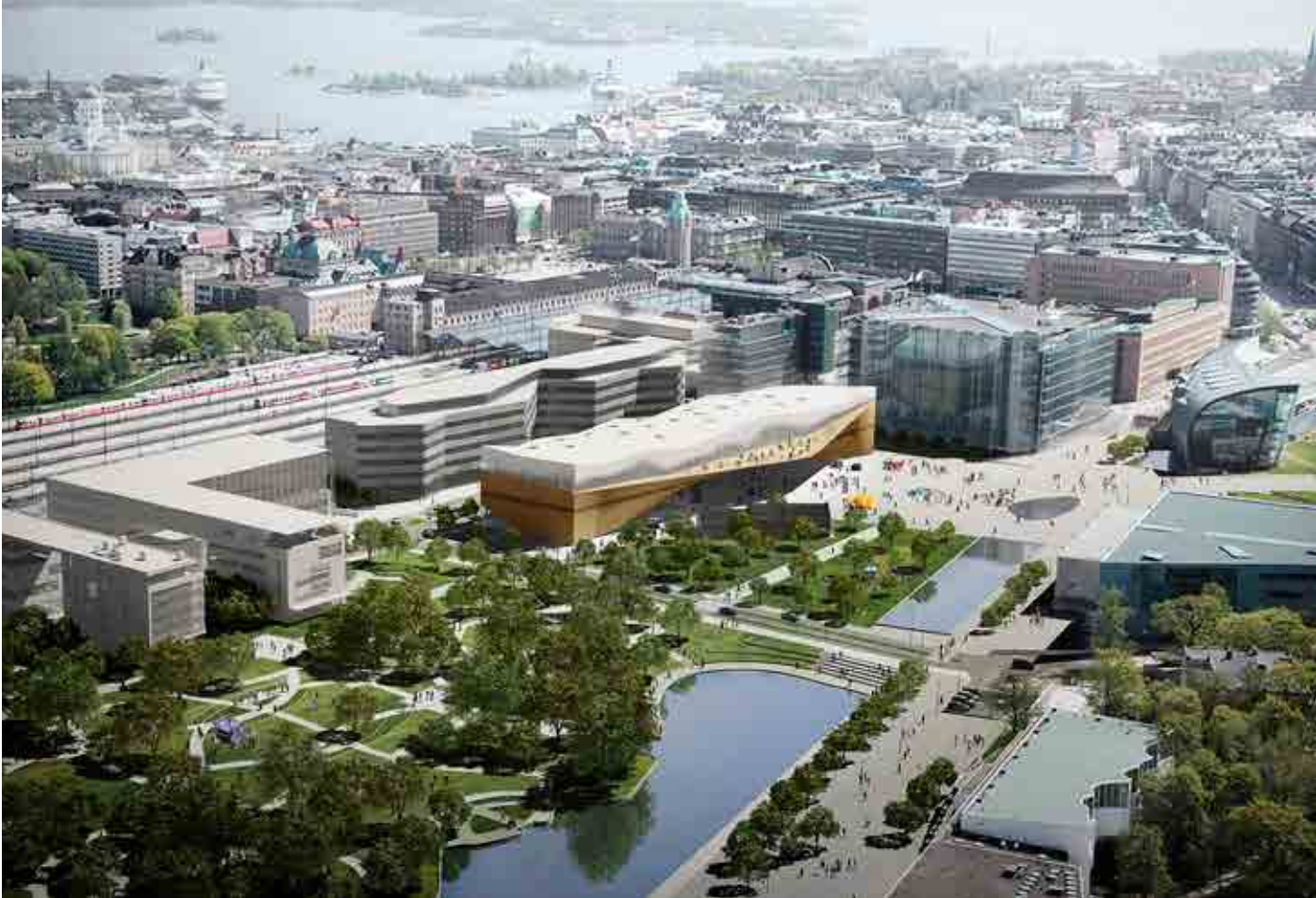
KESKUSTAKIRJASTO (ALA ARKKITEHDIT) CENTRUMBIBLIOTEKET (ALA ARKITEKTER) CENTRAL LIBRARY (ALA ARCHITECTS)
