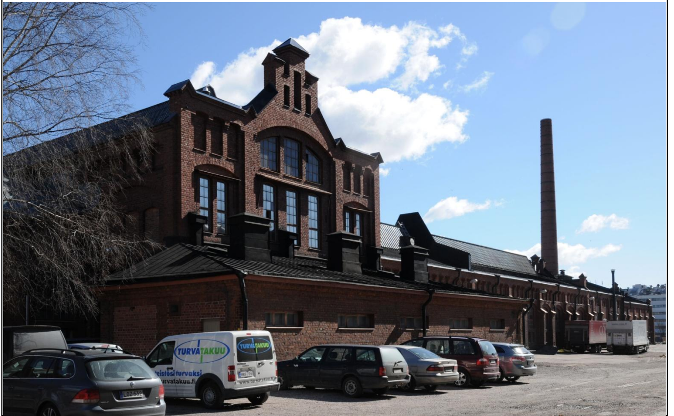
Suojeltavat rakennukset Pasilan konepaja, osa-alue V Kokoonpanohalli
