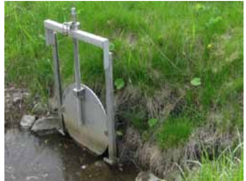
Tulvasuojauksiin liittyvä sulkuportti Vanhanväylän puistossa.
