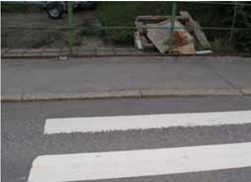
Suojatien kohdalla jalkakäytävän reunakiven tulisi olla luiskattu..
