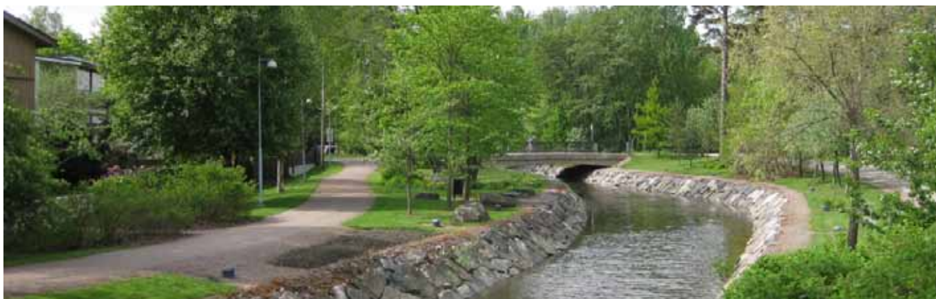
Tammisalon kanava (kohde 7) kunnostettiin asukkaiden aloitteesta vuonna 2001.
