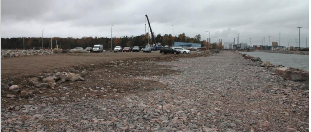
Kuva 24. Ruusuniemen kanavan vierustan laajennus ja uusi täyttöalue. (M. Vähäkäkelä)
