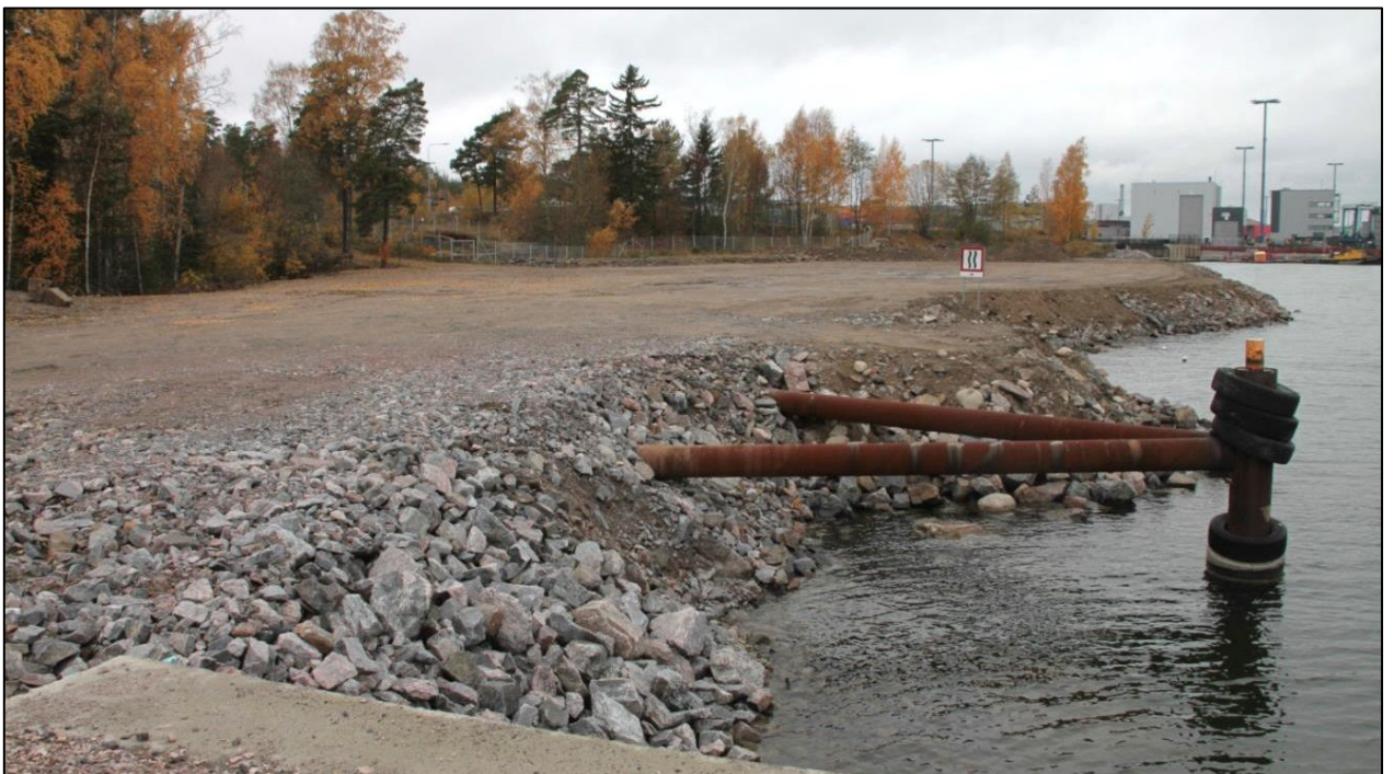
Kuva 25. Ruusuniemen kanavan vierustan uusi talvisäilytyskenttä, jota on suunniteltu vesibussien talvisäilytysalueeksi. (M. Vähäkäkelä)
