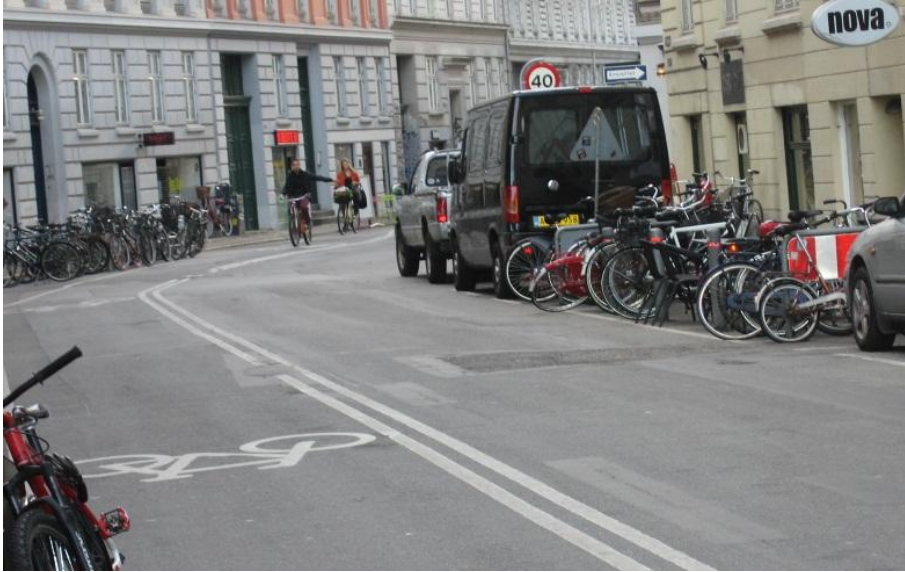
Kuva 22. Pyöräily yksisuuntaisella kadulla vastasuuntaan on osoitettu ajoratamaalauksin. Esimerkki on Kööpenhaminasta (kuva: WSP Finland Oy).
