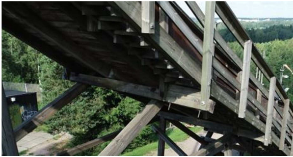
Kuva 24. Portaat ovat välttävissä kunnossa
