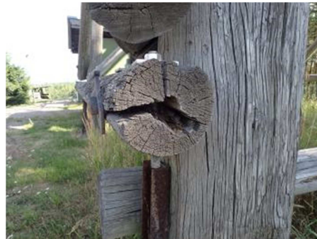
Kuva 17. Palkin pään halkeilua
