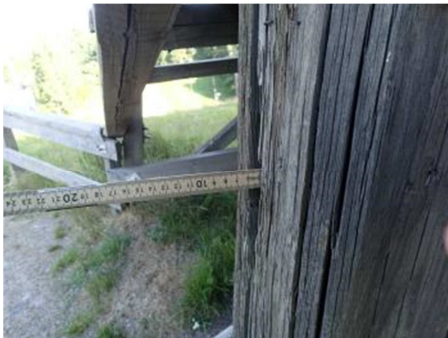
Kuva 12. Tyypillinen pilarin pystyhalkeilu
