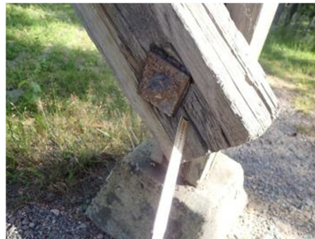
Kuva 21. Löysä pulttiliitos
