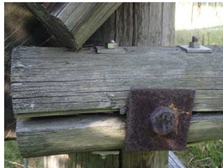
Kuva 23. Löysä pulttiliitos ja toimimaton palkin pään pulttivahvennos
