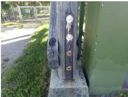
Kuva 20. Anturan ja pilarin liitos lattateräs
