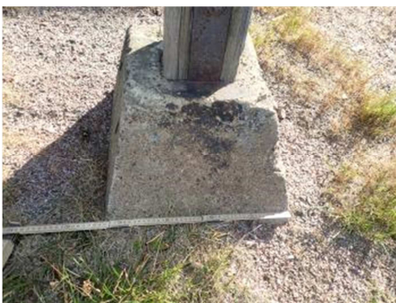
Kuva 10. Anturan pieni lohkeama
