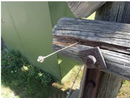
Kuva 3. Löysä pulttiliitos
