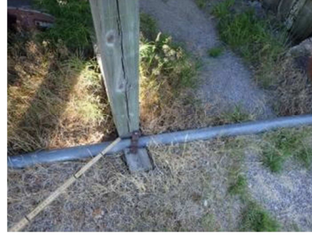
Kuva 11. Uusi maavarainen puuperustus
