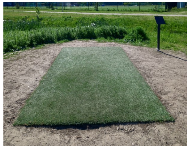
Kuva 8. Vuosaaren frisbeegolfradalle on to- teutettu hiekkatekonurmella päällystetyt 2x4m kokoiset heittopaikat.
