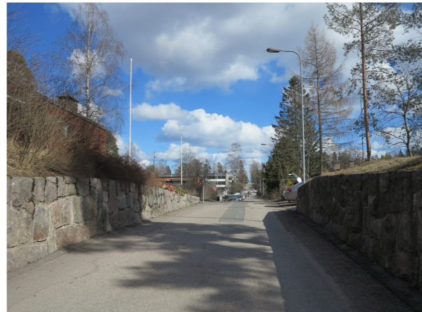
Kuva 285. Alkutie 85:n kohdalla katu on poikkeuksellisen kapea. Mäen harjalla katu leikkaantuu maastoon ja reunoja tukevat vanhat, huolella toteutetut luonnonkivimuurit.
