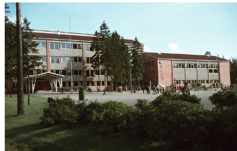
Kuva 209. Pakilan kansakoulu, nykyinen ala-aste, valmistui 1954. Koulurakennuksen on suunnitellut arkkitehti Jorma Järvi. Kuvaaja Constantin Grünberg 1965. Helsingin kaupunginmuseo. Rakennuksessa oli 2021 meneillään laaja peruskorjaus ja sen viereen oli rakenteilla uudisrakennus. Tämän vuoksi rakennusta ei ollut mahdollista valokuvata inventoinnin yhteydessä.
