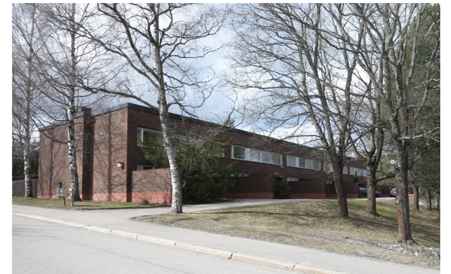
Kuva 226.. Osoitteessa Halkosuontie 73 sijaitseva rivitalo on vuodelta 1972.
