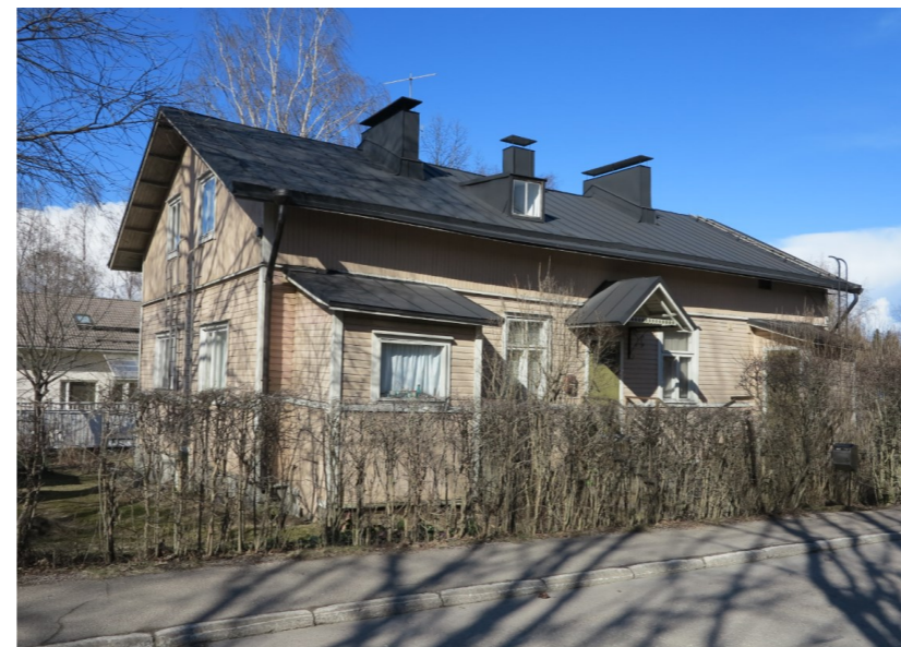
Kuva 168. Saarnaajantien länsipäässä (nro 9) on vanhempi, arviolta 1900-luvun alussa rakennettu lohkokivisokkelille perustettu asuinrakennus.
