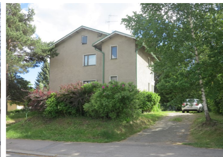
Kuva 200. Osoitteessa Ripusuontie 76 on rapattu 1960 valmistunut pienkerrostalo.
