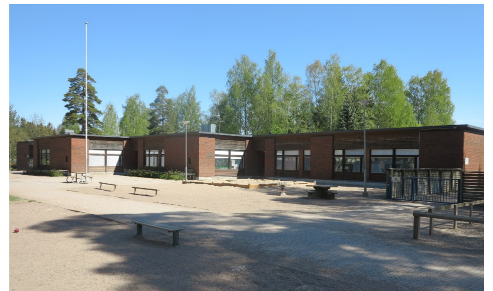
Kuva 250. Elontien varressa sijaitseva vuonna 1977 valmistunut päiväkotii
