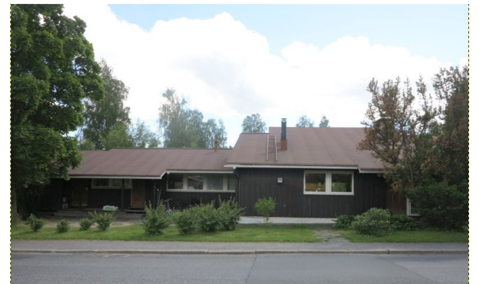
Kuva 195. Osuuskunnantie 58, omakotitalo Villa Karvonen, Kaija ja Veli Paatela (1956)
