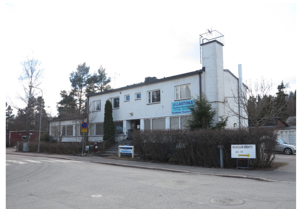
Kuva 249. Osoitteessa Rapparintie 6 sijaitsevan vuonna 1964 valmistuneen Zetterbergin asuin- ja liiketalon on suunnitellut arkkitehti Ylermi Salminen.
