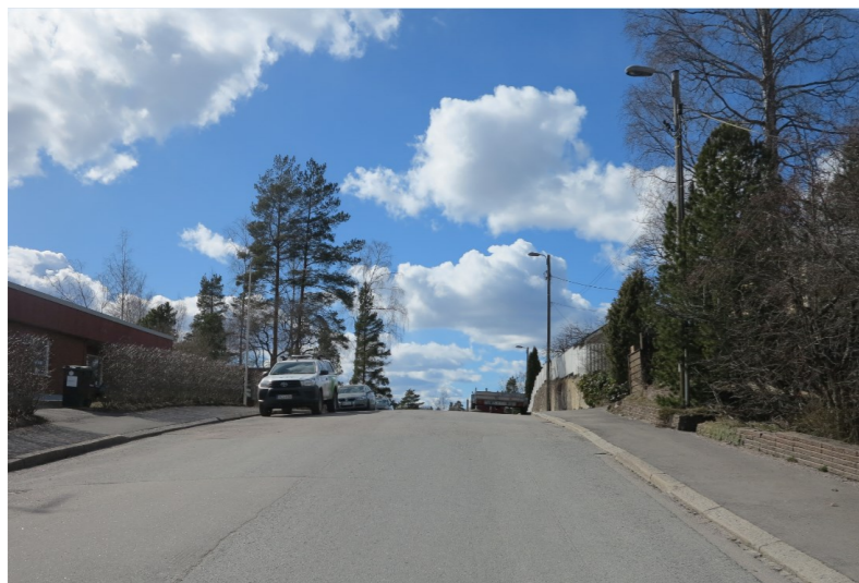
Kuva 156. Pakilantien länsipuolella Osuuskunnantie nousee kallioisen mäen yli. Kalliota on leikattu kadun pohjoisreunalla.
