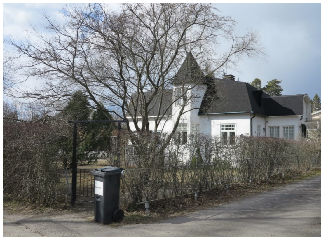
Kuva 166. Lepolantien varrella (nro 77) sijaitsevassa 1917 valmistuneessa rakennuksessa on aikanaan toiminut posti. Jugendvaikutteita omaavaan rakennukseen liittyi erityisenä yksityiskohtana pieni torni.
