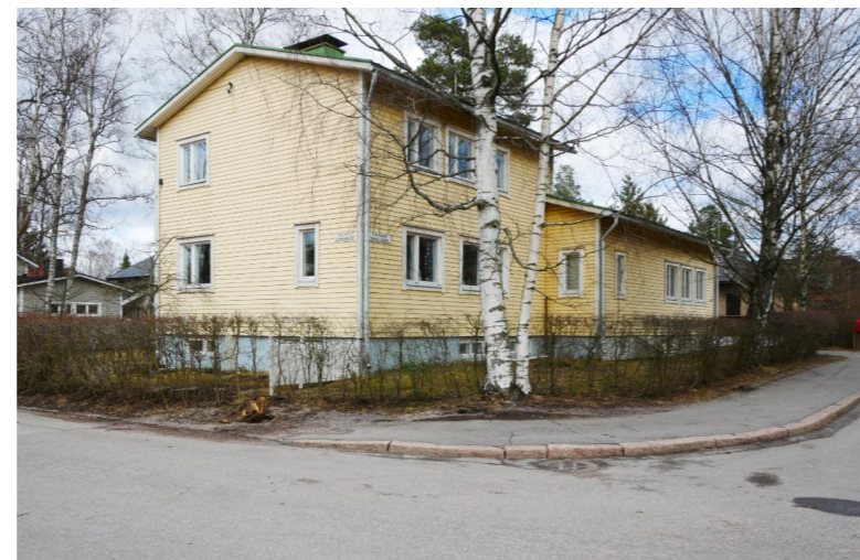
Kuva 199. Suovantien ja Halkosuontien risteyksessä on 1953 valmistunut limilautavuorattu kaksikerroksinen asuinrakennus, johon liittyy matalampi siipiosa.
