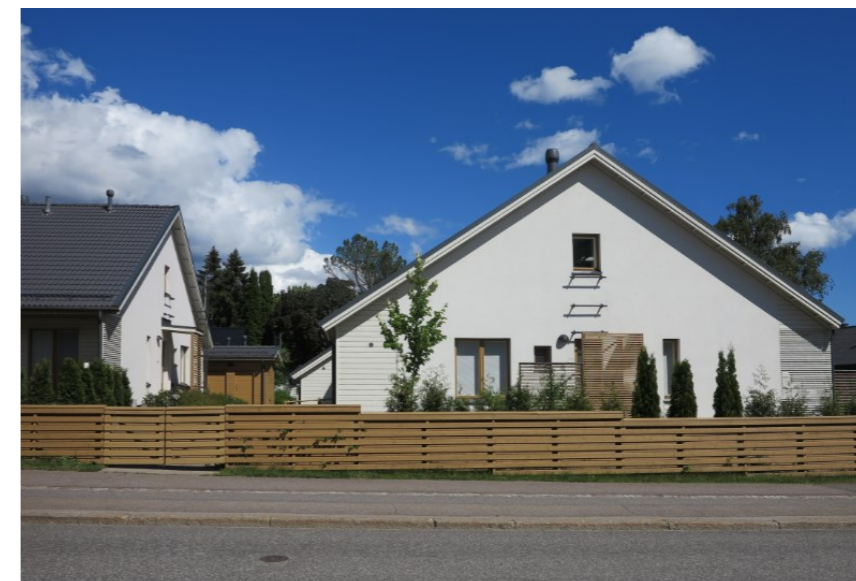
Kuva 258. Vuonna 2017 valmistuneita pientaloja Jakokunnantien varressa.
