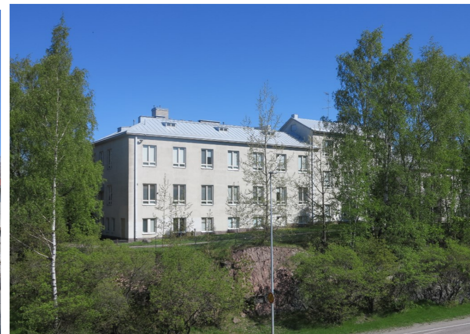
Kuva 181. Länsi Pakilaan vuonna 1939 valmistuneen kolmikerroksisen koulurakennuksen on suunnitellut arkkitehti Jalmari Peltonen. Laajennus on vuodelta 1967. Kaupunkisuunnitteluviraston vuonna 2004 laatimassa selvityksessä on rakennus arvotettu alimpaan luokkaan 3.
