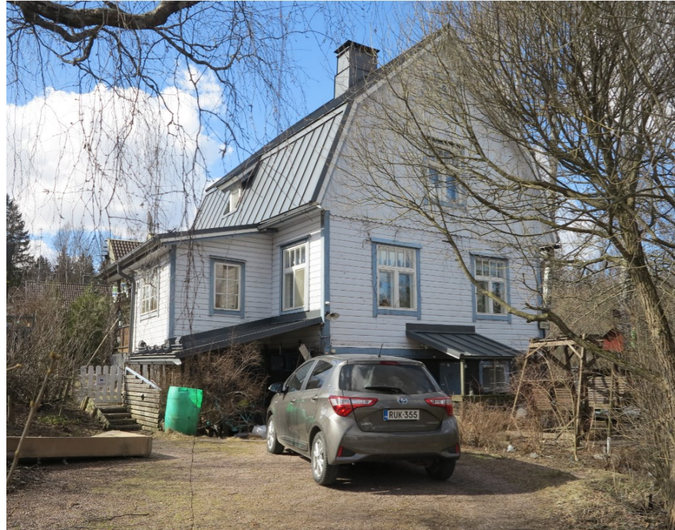
Kuva 170. Osoitteessa Alkutie 88 sijaitseva taitekattoinen huvila on vuodelta 1932.
