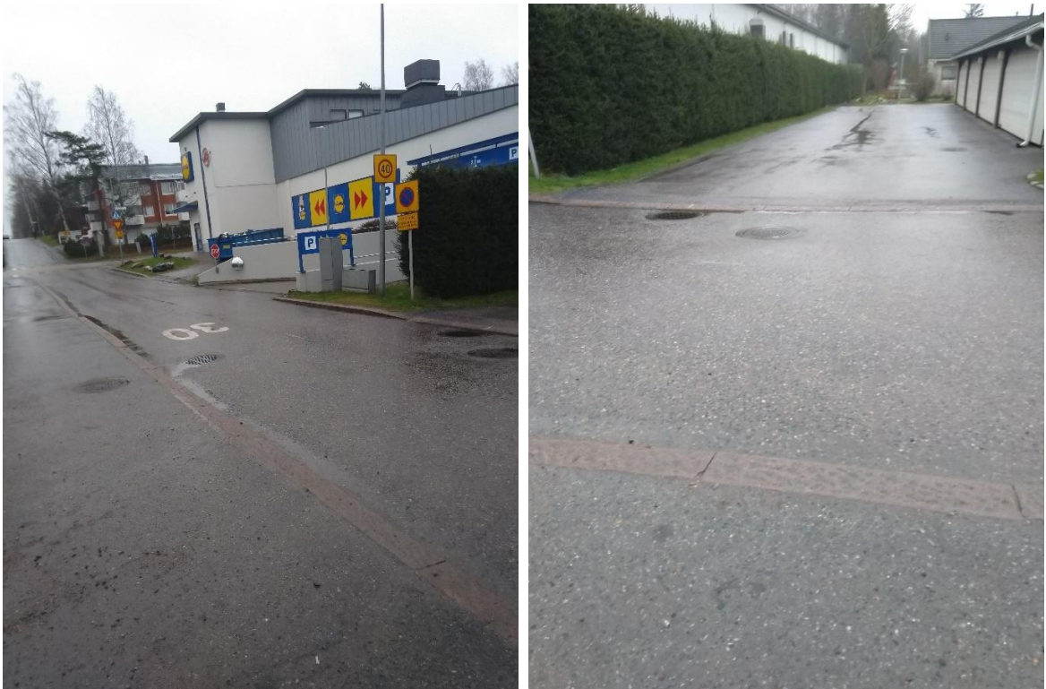
Kuva 24. Alkutiellä kaivojen mallinnettu tulviminen tapahtuu ruokakaupan ajo- luiskan (vas.) ja viereisen asuinkiinteistön pysäköintialueen (oik.) edustalla. Kynnykset kadulta ovat vähäiset. DN 500 runkoviemäri kulkee eteenpäin asuin- kiinteistön lävitse.
