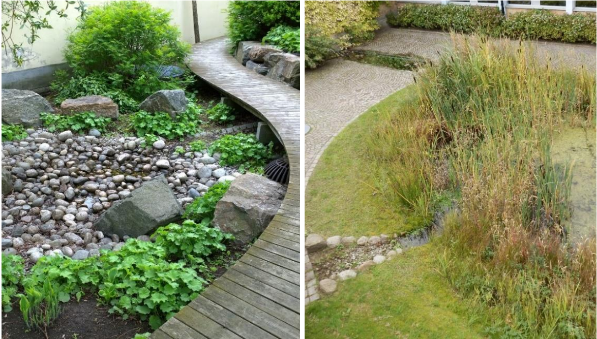
Kuva 42. Esimerkkejä kiinteistökohtaisesta hulevesien hallinnasta. Vas. Sadepuutarha hallitun ylivuodon mahdollistavalla kupukantisella kaivolla. Oik. Viivytyksaltaana toimiva vesiaihe.
