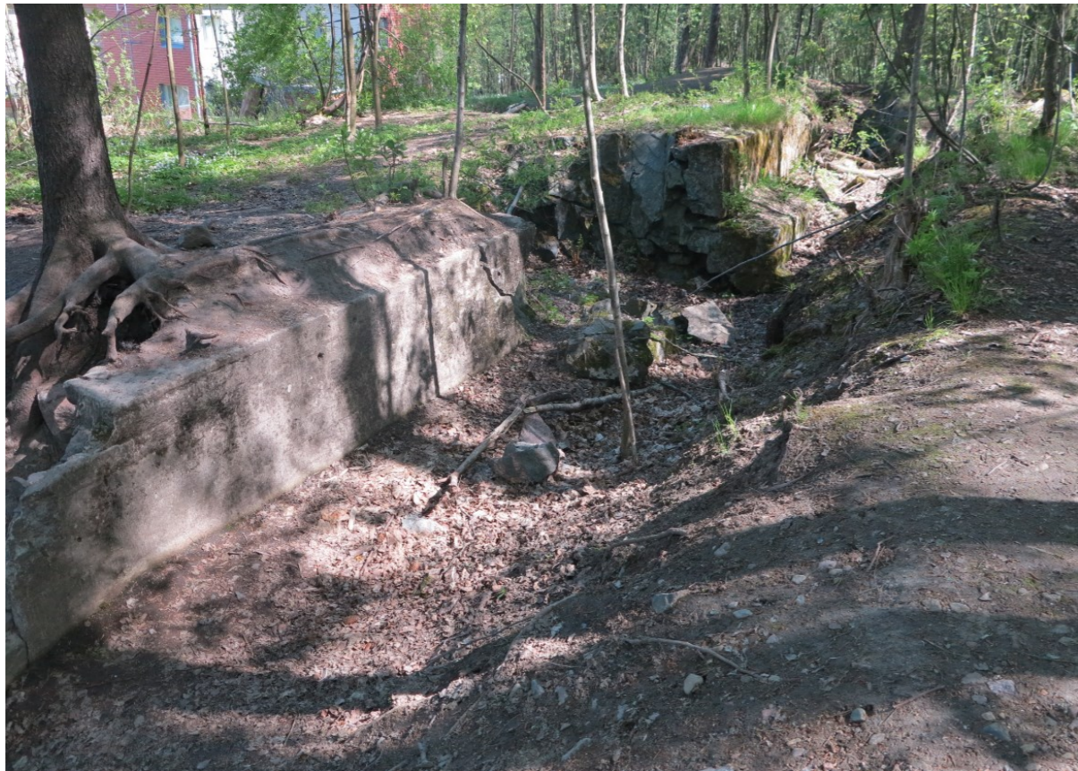
Kuvat 17-18 Tukikohdan XVII:13 säilyneitä rakenteita.
