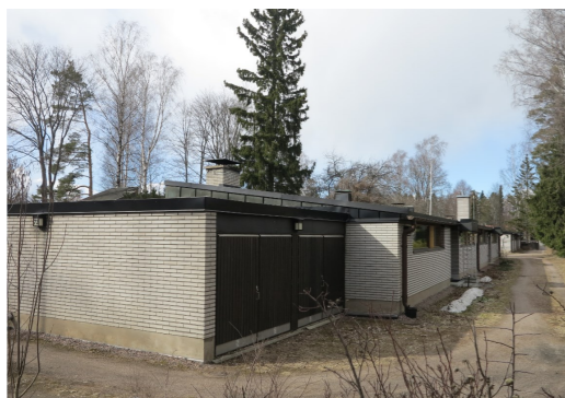
Kuva 127-128. Osuuskunnantien ja Lepolantien väliseen kortteliin valmistui vuonna 1966 arkkitehti Kai Palmqvistin suunnittelemat kaksi paritaloa. Julkisivut tehtiin vaaleasta kapeasta kalkkiviikkatiloista, ikkunat toteutettiin nauhamaisina pintoina ja loiva pulpettikatto häivyttiin levymaisten päätyseinien taakse. Päädyssä kadun puolella on autotallit. Rakennuslupapiirustus/ Arska. Vasemmalla kuva rakennuksesta tänä päivänä.
