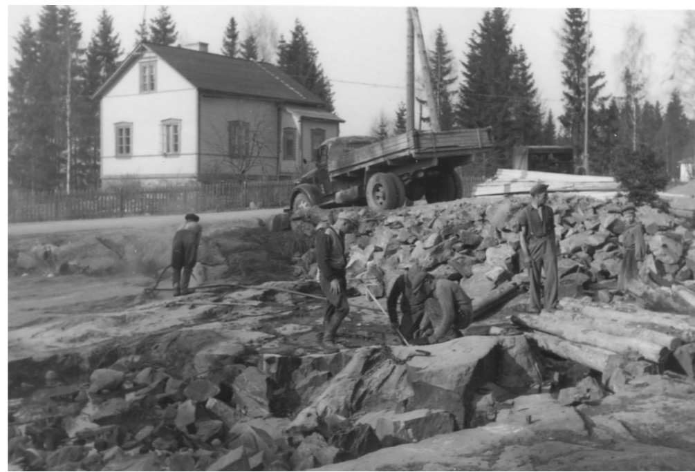
Kuva 35. Kaivosta louhittiin Halkosuontie 152-154 kohdalla vuonna 1956. Taustalla 1970-luvun alussa purettu Nurmen talo. Kuva Pakila-seura/ Mikko Vienonen
