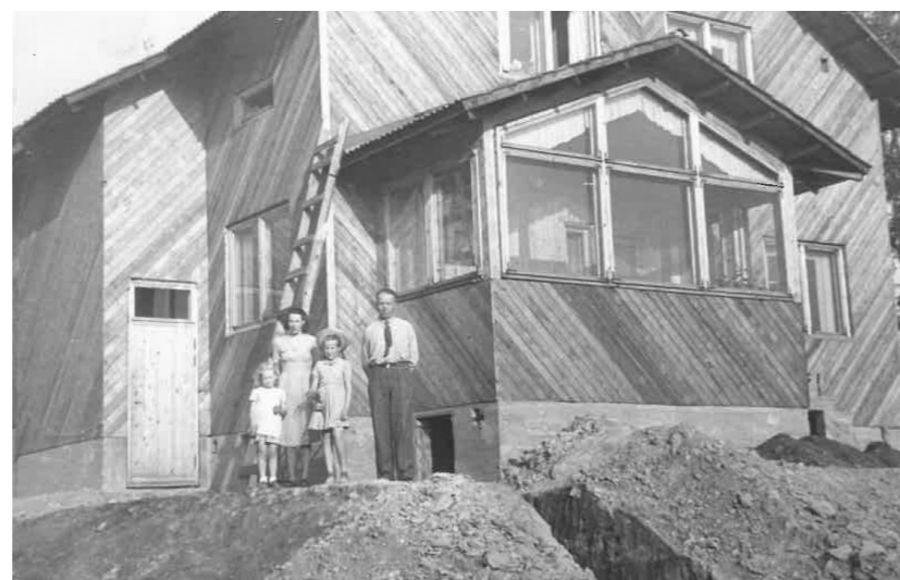
Kuva 71. Käyhtyn perheen talo rakenteilla Piikintien ja Koulumestarintien kulmassa 1950-luvun alku. Kuvan omistaja Kaija Käyhty. Pakila-seura.
