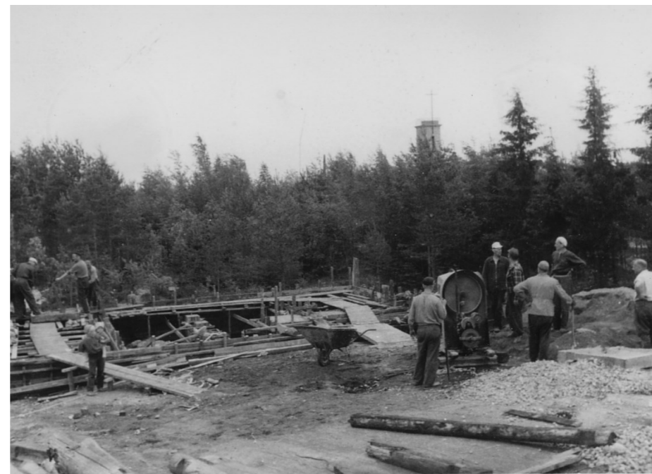
Kuva 91 ja 92. Pakilan partiomajan rakennustyömaa vuonna 1954. Kuva Pakila-seura/ Mikko Vienonen
