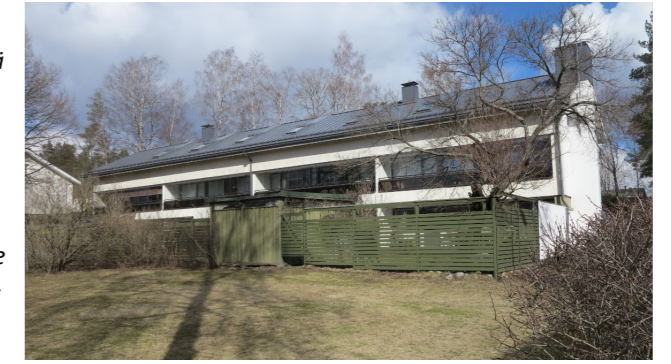
Kuva 131-132. Arkkitehti Antti Miettisen suunnittelema neljän asunnon rivitaloon vuodelta 1966 liittyy aikakaudelle tyypillisiä piirteitä kuten nauhaikkunat, koko julkisivun mittainen nauhamainen parveke, sekä hyvin matala tasakaton ilmettä kuvaava satulakatto. Rakennukseen liittyy maanpäällinen tummasävyinen jalustakerros, jonka päällä on asuinkerros valkeaksi rapattuine julkisivuineen. Rakennukseen on myöhemmin tehty ilmettä muuttaneita muutoksia. (Lepolantie 95) Rakennuslupapiirustus/ Arska. Oikealla kuva rakennuksesta tänä päivänä.
