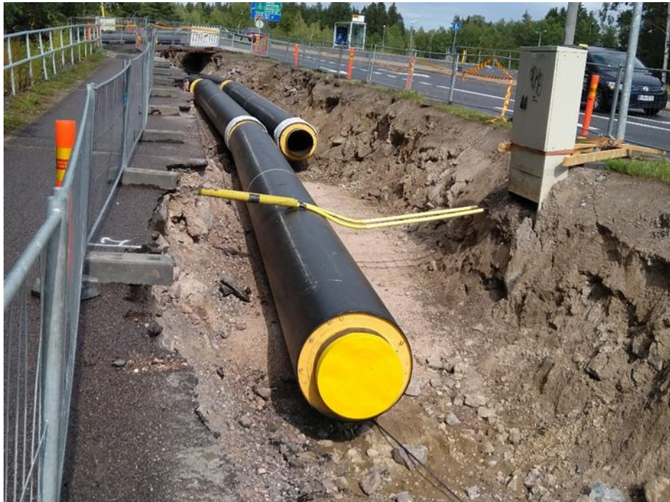
Kuva 9. Kaukolämpöputkien ja -kaivannon rakenne (2Mpuk)
