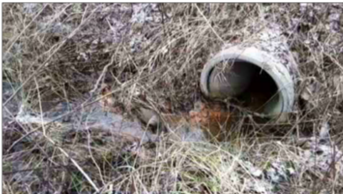
Kuva 10. Viilarintien 1000B viemäriin liittyvän 500B viemäriin suu
