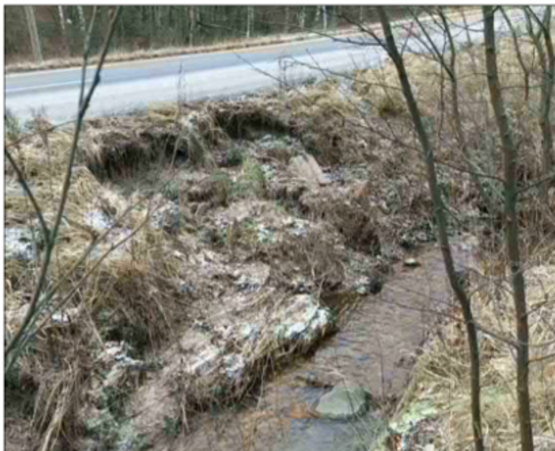
Kuva 13 Purku-uomassa on kulkenut suuria virtaamia lähes Viikintien tasossa, jotka ovat aiheuttaneet eroosioaurioita.
