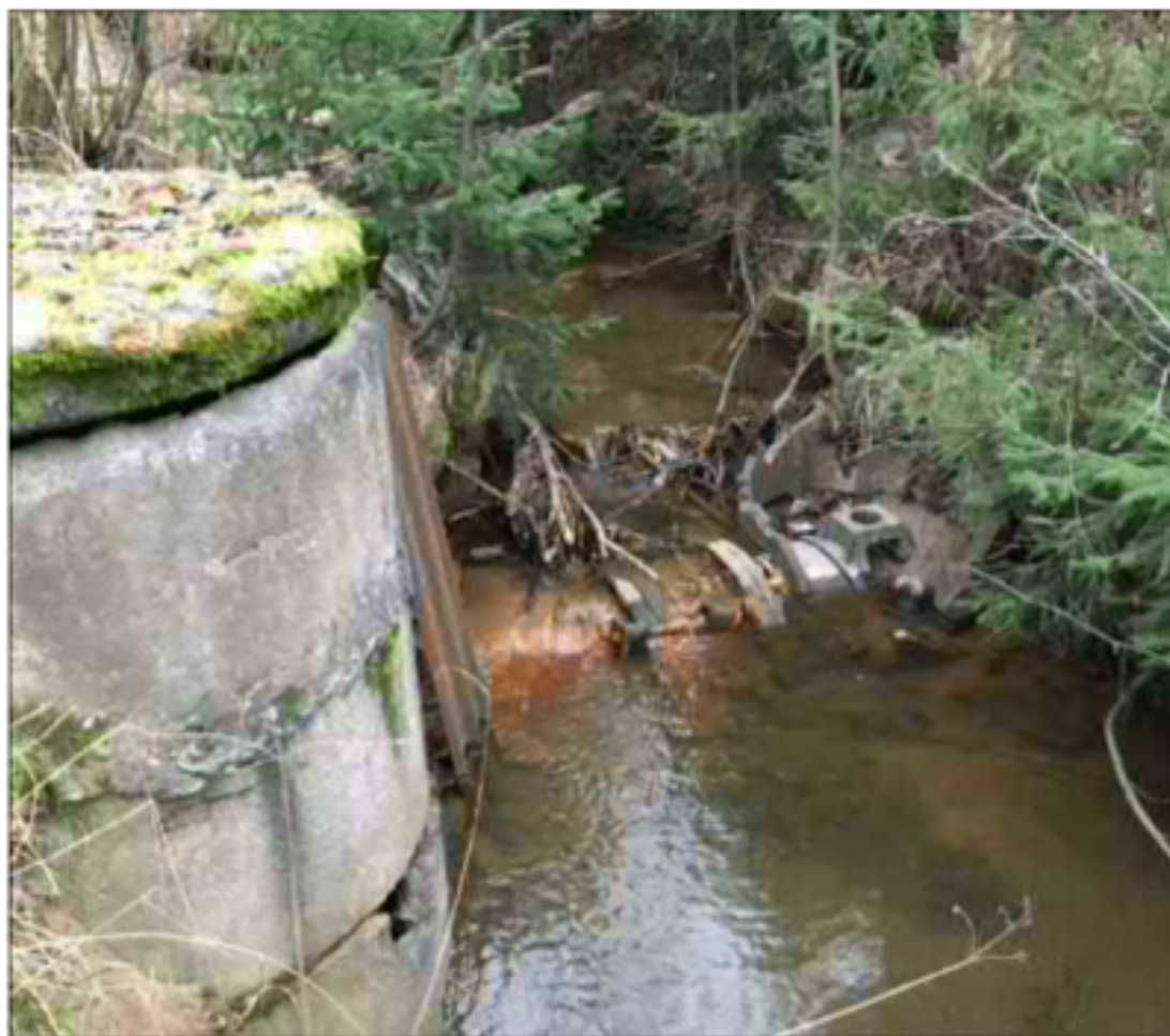
Kuva 14. Käytöstä poistettu vesijohto purku-uomassa.
