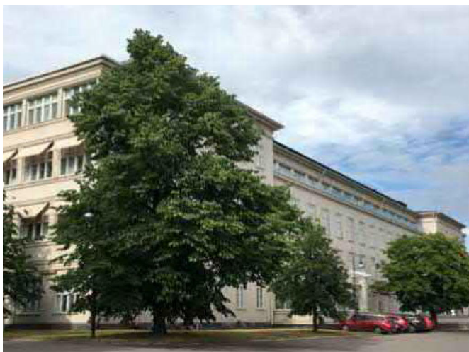
Läntinen potilaspaviljonki. Päädyissä, ylimmässä kerroksessa sekä maantasokerroksessa entiset ulkomakuuparvekkeet ja -terassit (kuva: Arkitehtitoimisto Freese Oy).
