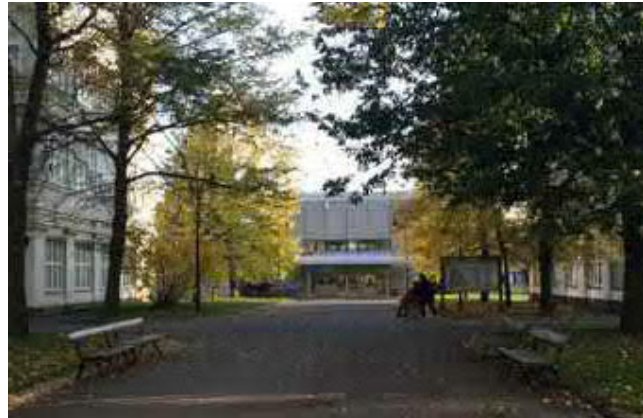
Alkuperäisessä suunnitelmassa symmetrinen keskeisakseli johdatti sairaalapuistoon, mutta viimeiset viisikymmentä vuotta akseli on päättynyt terveyskeskuksen pääsisäänkäynnille.
