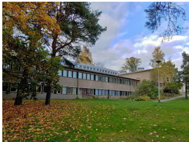
Rakennuksen eteläjulkisivu sairaalapuutarhan suunnasta.
