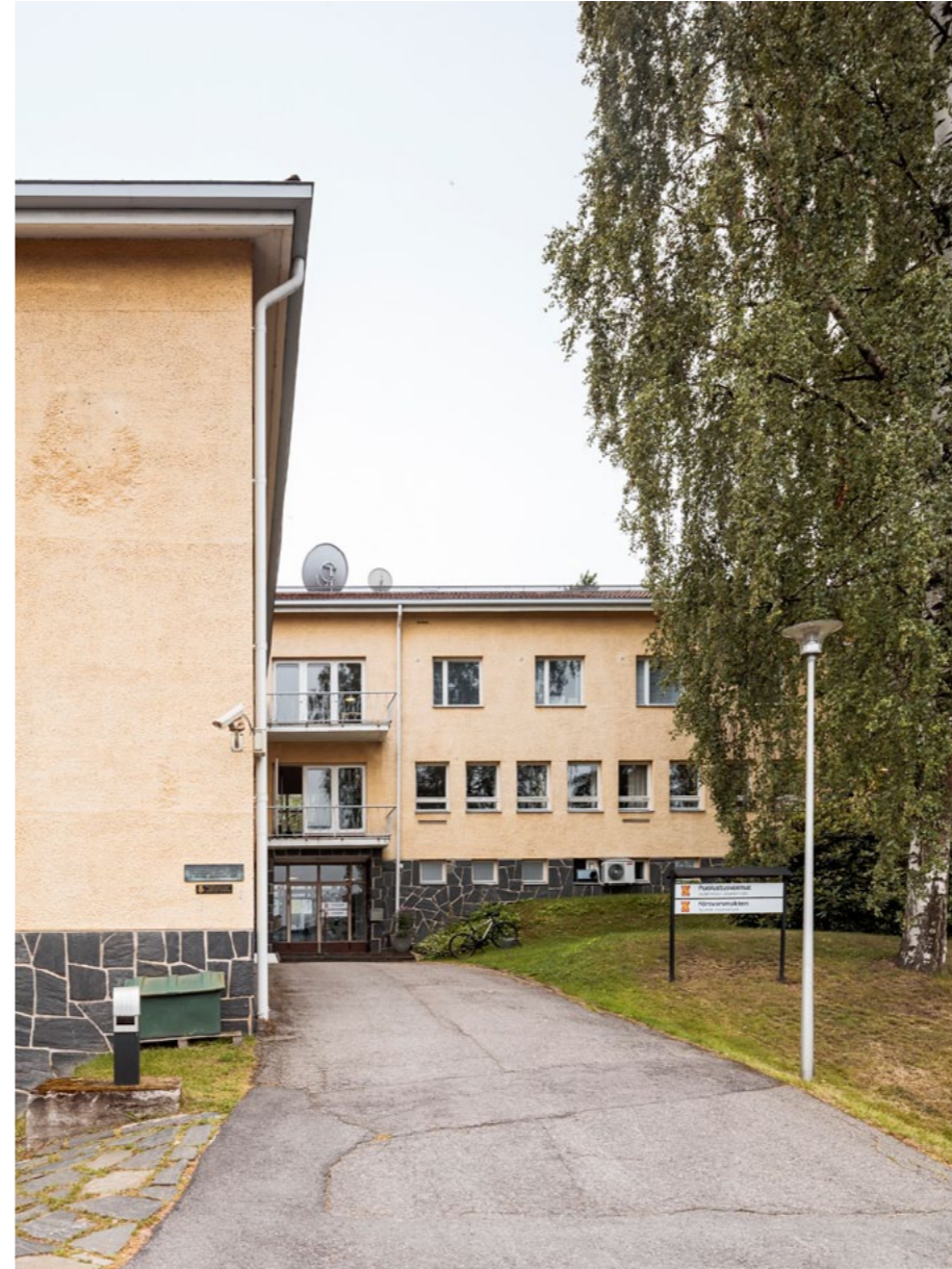
Suojeltavan päärakennuksen (RAK A) sisäänkäynti
