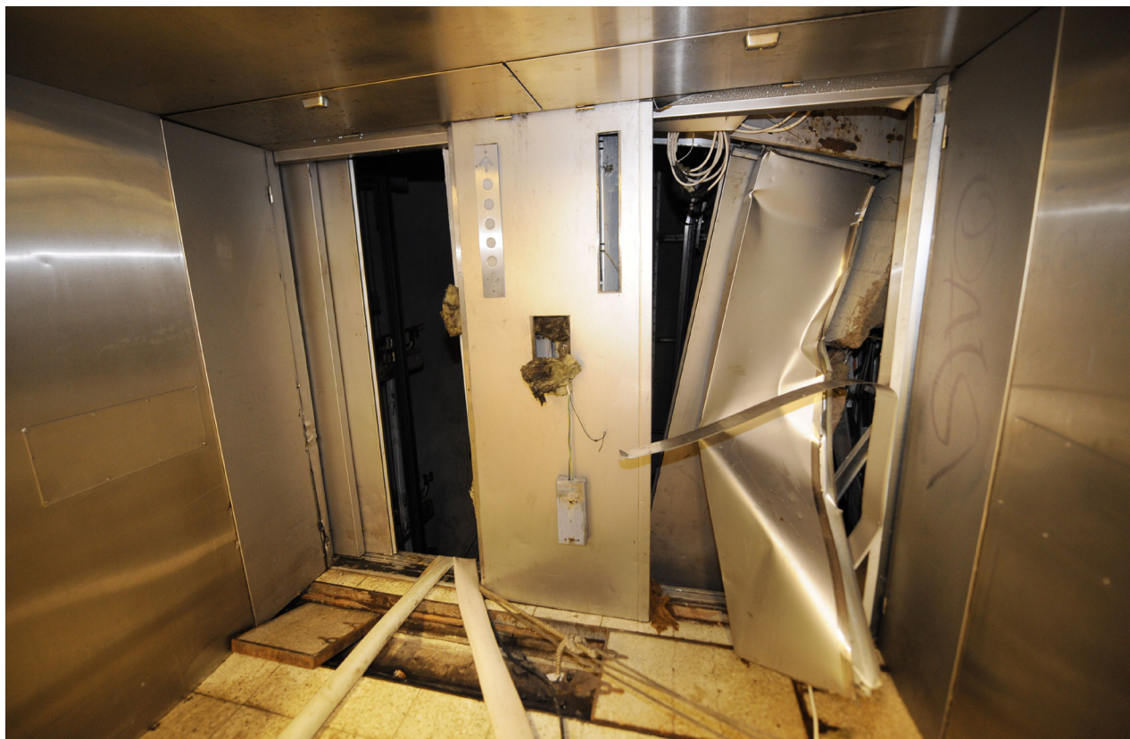
Kuva 6: Tulvaveden vaurioittama hissi Rautatientorin metorasemalla, 2009, STT, Lehtikuva, Martti Kainulainen
