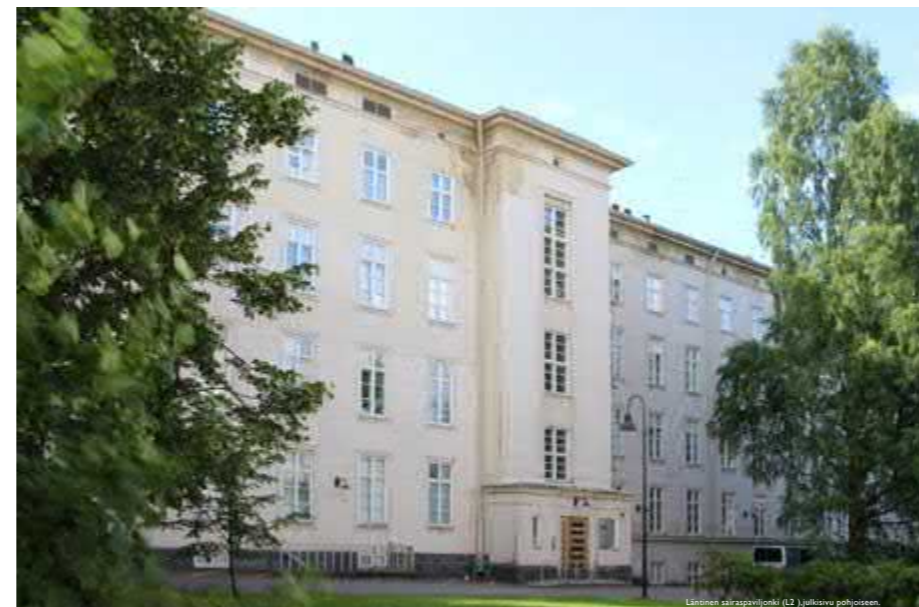
Läntinen säilyvä rakennus. Julkisivu pohjoiseen. Lähde: RHS
