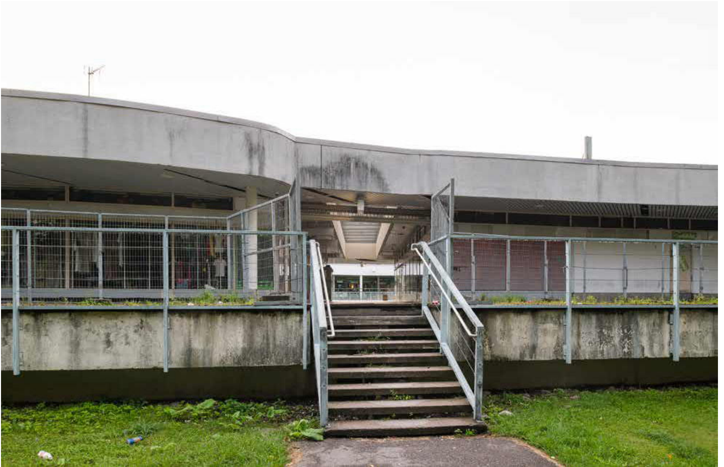
Verrantokuvat julkisivusta pohjoiseen. Betonikaaret on purettu, kaiteet vaihdettu ja avoin näkymä rakennuksen läpi vaihtunut C-osan laajennukseksi. Kuva vuodelta 2019. Kuvaaja Niclas Mäkelä.
