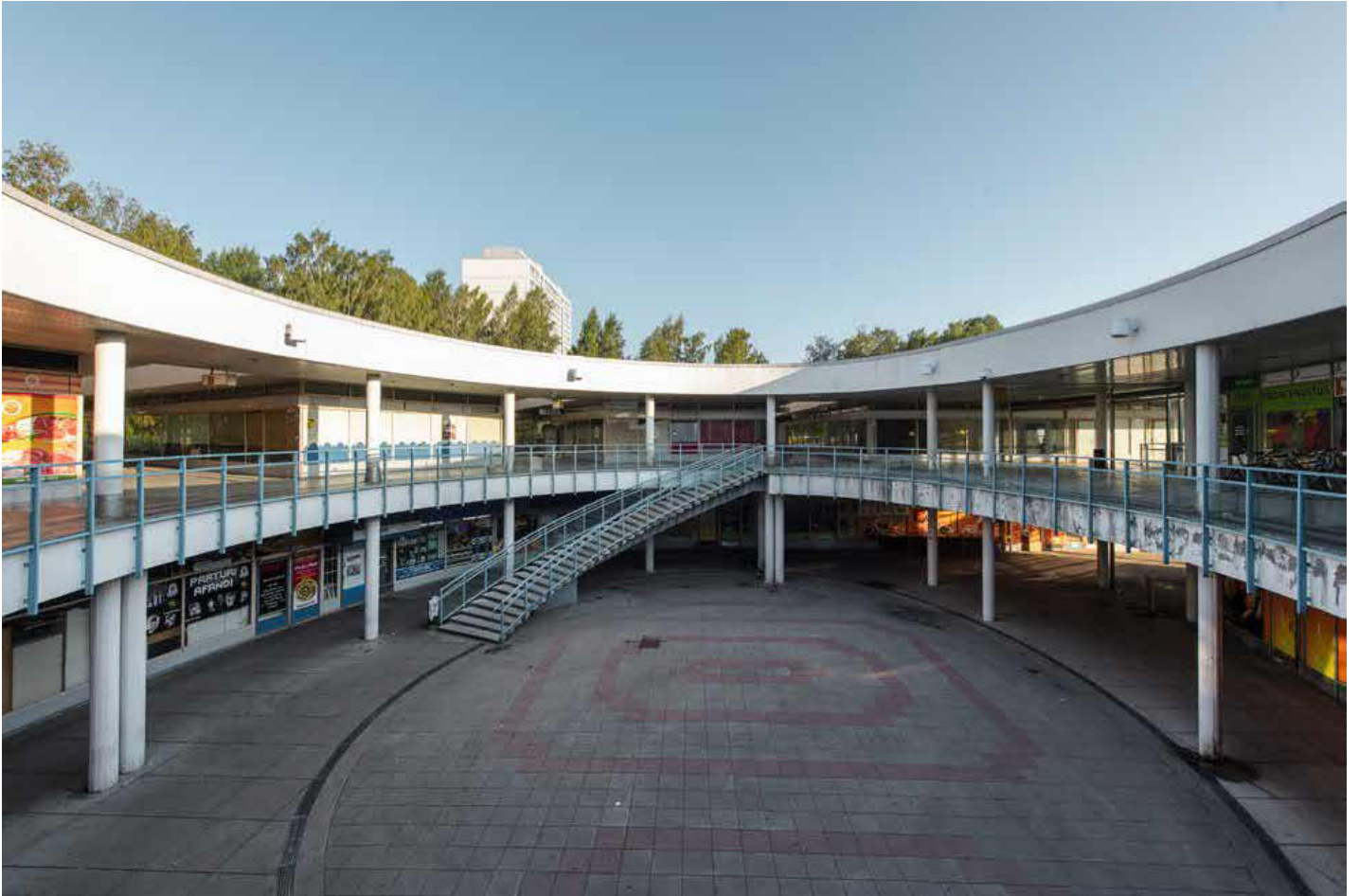
Näkymä 2.kerroksen tasolta sisäpihalle, 2019. Kuvaaja Niclas Mäkelä.
