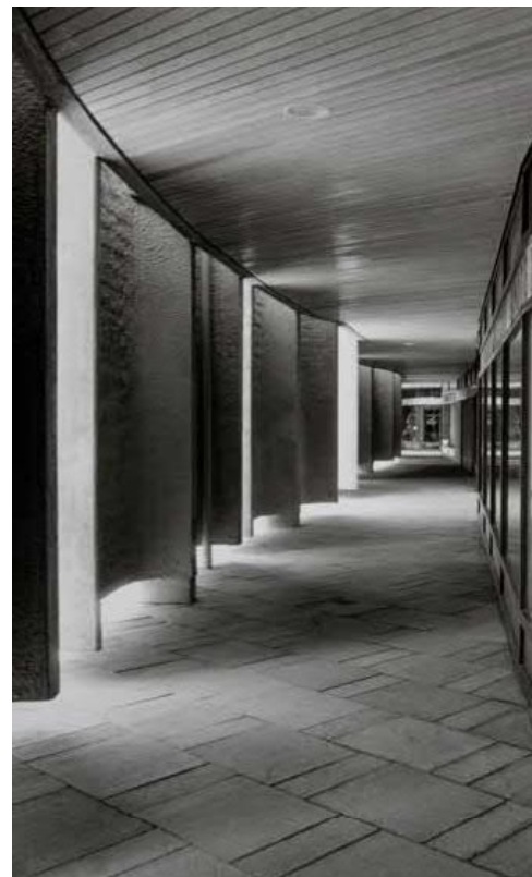
Betonikaarien takana sijainnut kulkukäytävä 1960-luvulla. Helsingin kaupungin museo, kuvaaja tuntematon
