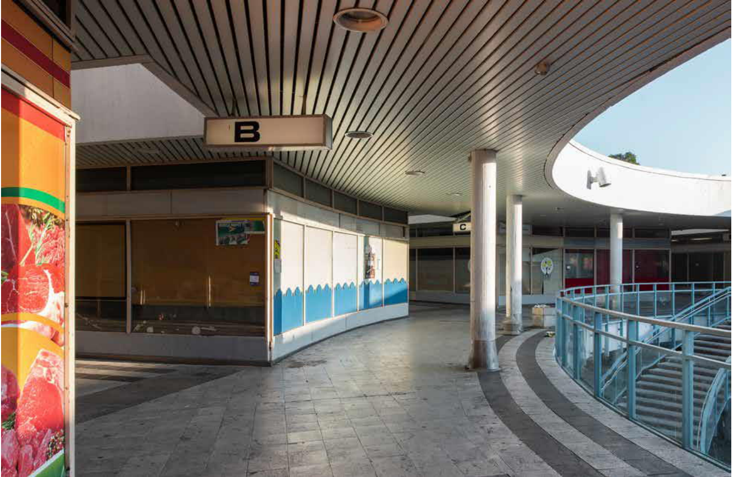
Verrantokuva sisäpihalta vuonna 2019. Alkuperäinen laatoitus on vaihdettu ja kaiteet uusittu. Myymälöiden ikkunat on teipattu umpeen ja betonipilarit maalattu vaaleiksi. Kuvaaja Niclas Mäkelä.
