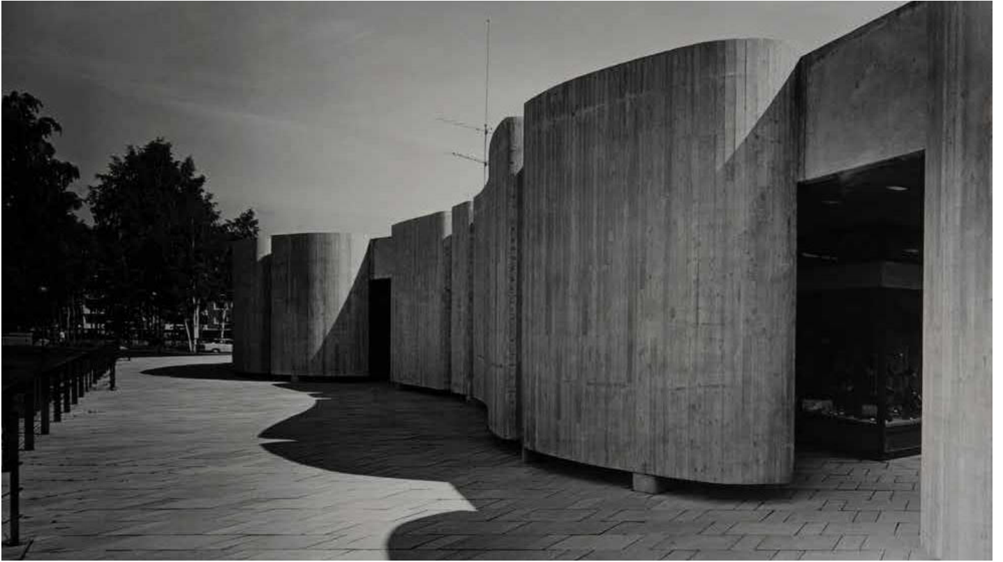
Betonikaaret pohjoisjulkisivulla 1960-luvulla. Helsingin kaupunginmuseo, kuvaaja tuntematon
