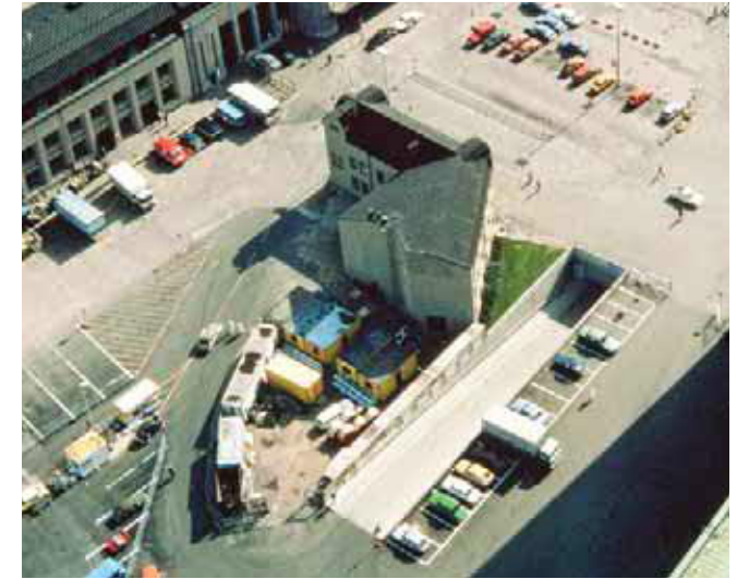
Viistonäkymä luoteesta, jossa näkyy metron huoltotunnelin suuaukko. Valokuva Pyykkö 1980, HKM
