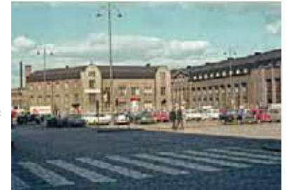
oik: Näkymä asema-aukiolta. Valokuva Constantin Grünberg 1967, HKM vas: Veturitallilta kohti asemarakennusta. Valokuva Tapio Keränen 1968 (vau-nut.org)
