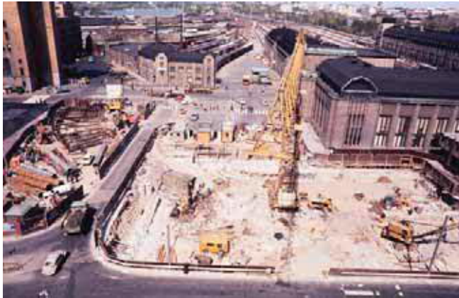
Metrotunnelin rakentaminen käynnissä. Tavaramakasiini- ja veturitallirakennus vielä kokonaisena olemassa Valokuva Osmo Aittapelto, 1977, HKM
