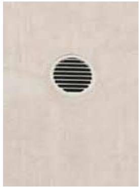
Rakennusajankohdalle epätavallinen korvausilma-aukko.
