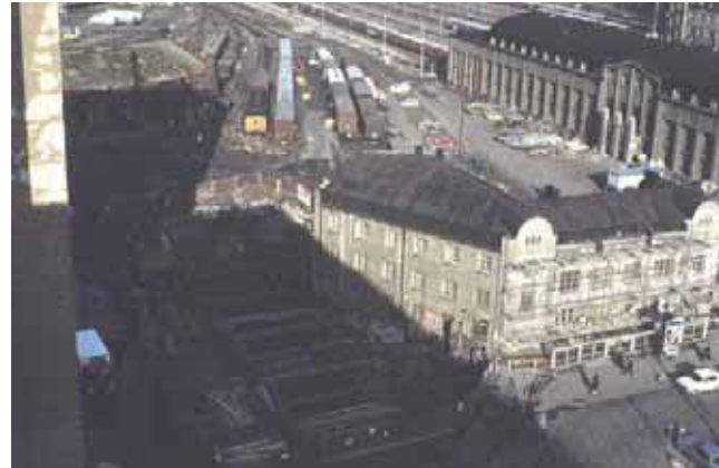
Metron huoltotunnelin rakentaminen käynnissä. Veturitallit on purettu. Valokuva 1978, HKM
