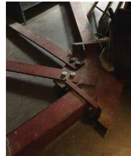
Ullakon käyttönottamisen mahdollistamiseksi on rakenteita vahvistettu teräksin.
