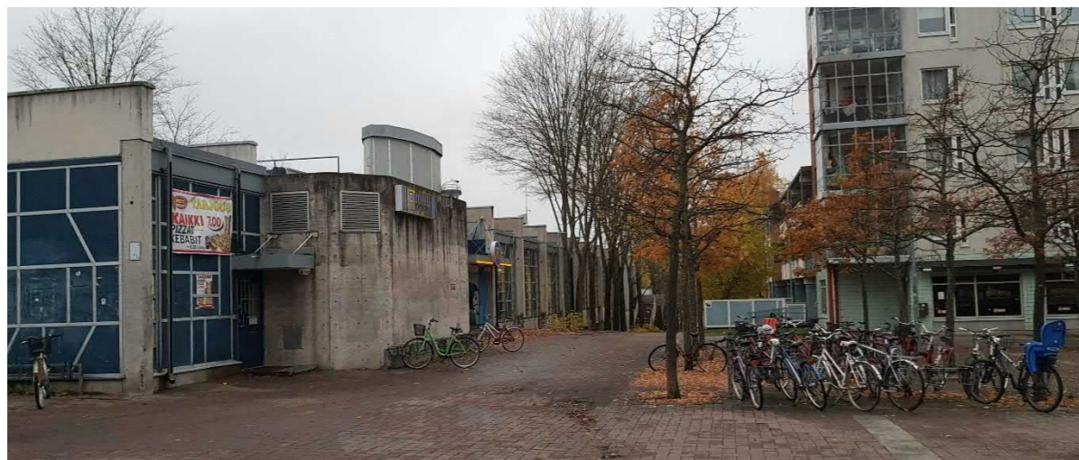
Mellunmäen asema vasemmalla. Liityntäpyöräköinnin pyöriä jätettiin asemalta vähän sivummas, koska telineet olivat pääosin rikki asemarakennuksen vieressä.
