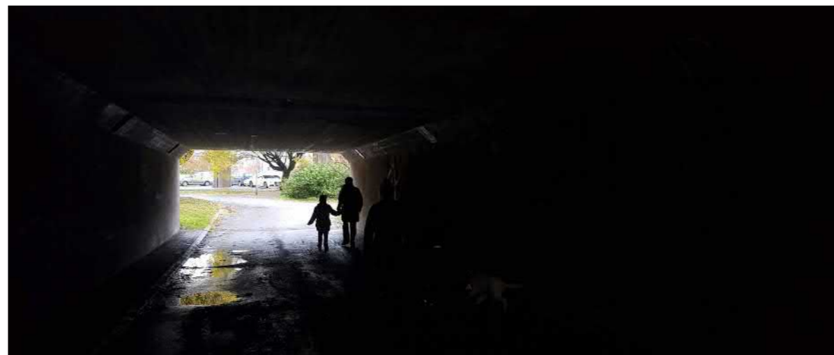
Kontulantien alikulku Mellunmäessä on matala. Valot ovat matalalla ja ne on spraymaalattu osittain umpeen. Päivisin pimeys korostuu.
