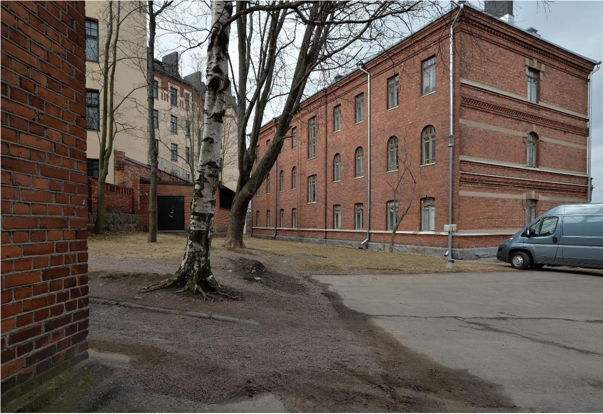
Asetuksella ja kaavalla suojeltu rakennus, näkymä pihan puolelta.
