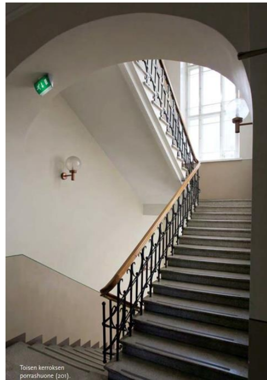
Toisen kerroksen porrashuone
