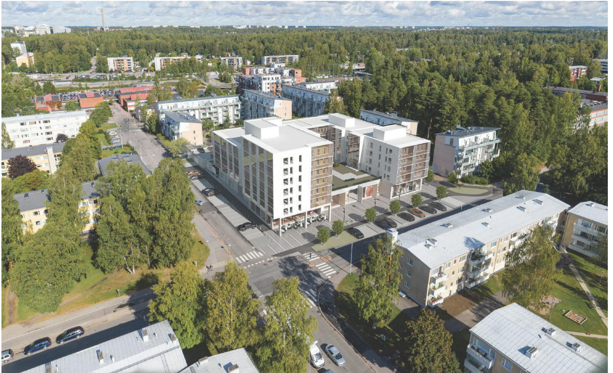
ILMAKUVA / NÄKYMÄ koilliseen - Rusthollarintien ja Klaavuntien risteys etualalla
