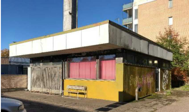
Lämpökeskus edestä kuvattuna
