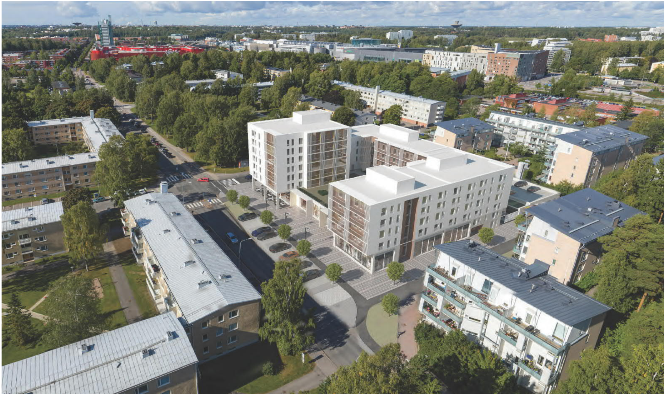
ILMAKUVA / Näkymä luoteeseen - Rättärinpolun ja Rusthollarintien kulmaus etualalla
