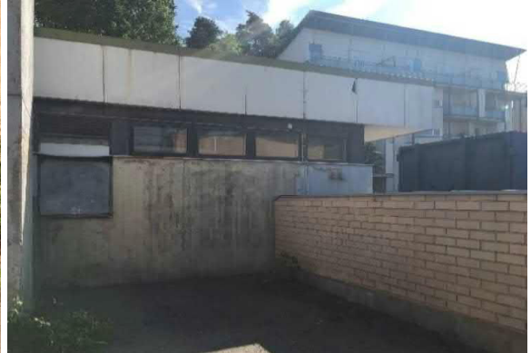
Lämpökeskus ja tontit rajaava muuri
