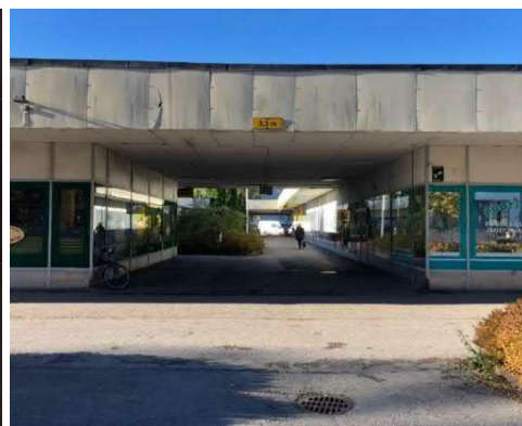
Katon yhdistämä "käytävä"
