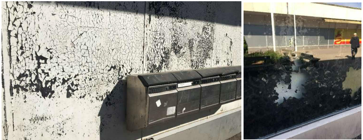
Sisäpihan julkisivujen seinä- ja näyteikkunapintoja nykytilassaan
