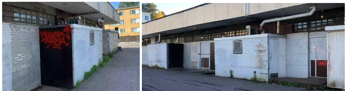
Parkkipaikan puoleiset Alepan yhteydessä olevat laatikkosuoijat huonossa kunnossa
