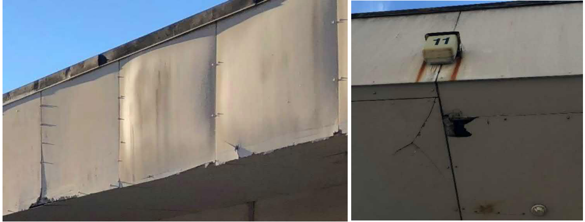
Tasakaton otsalistan alkuperäiset Minerit-levyt ovat kauttaaltaan vaurioituneita
