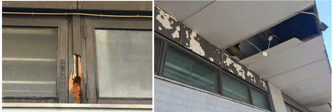
Rispaantuneet ikkunanpuitteet ja katto parkkipaikan puolella
