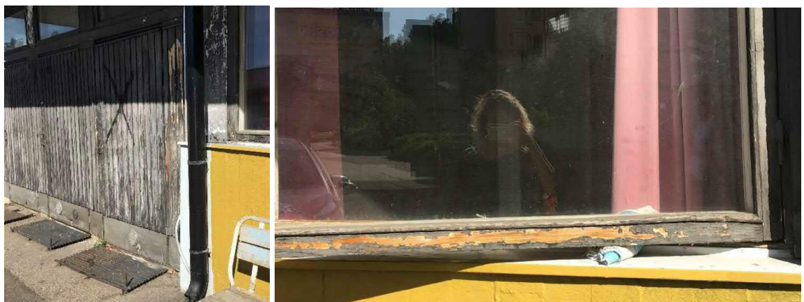
Lämpökeskuksen alkuperäiset ikkunat ja ovet kauttaaltaan lohkeilleet
