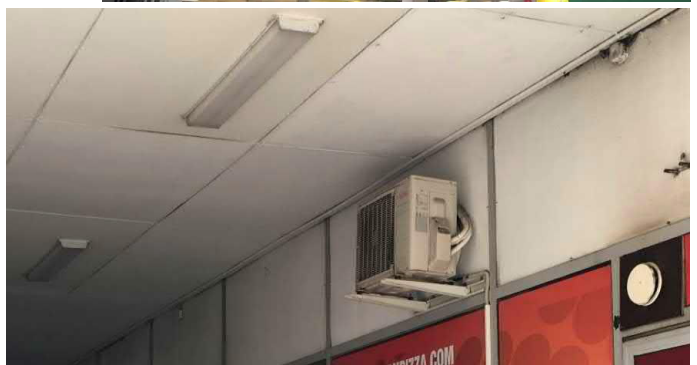
Talotekniikkaa liiketilojen katoissa ja julkisivuilla
