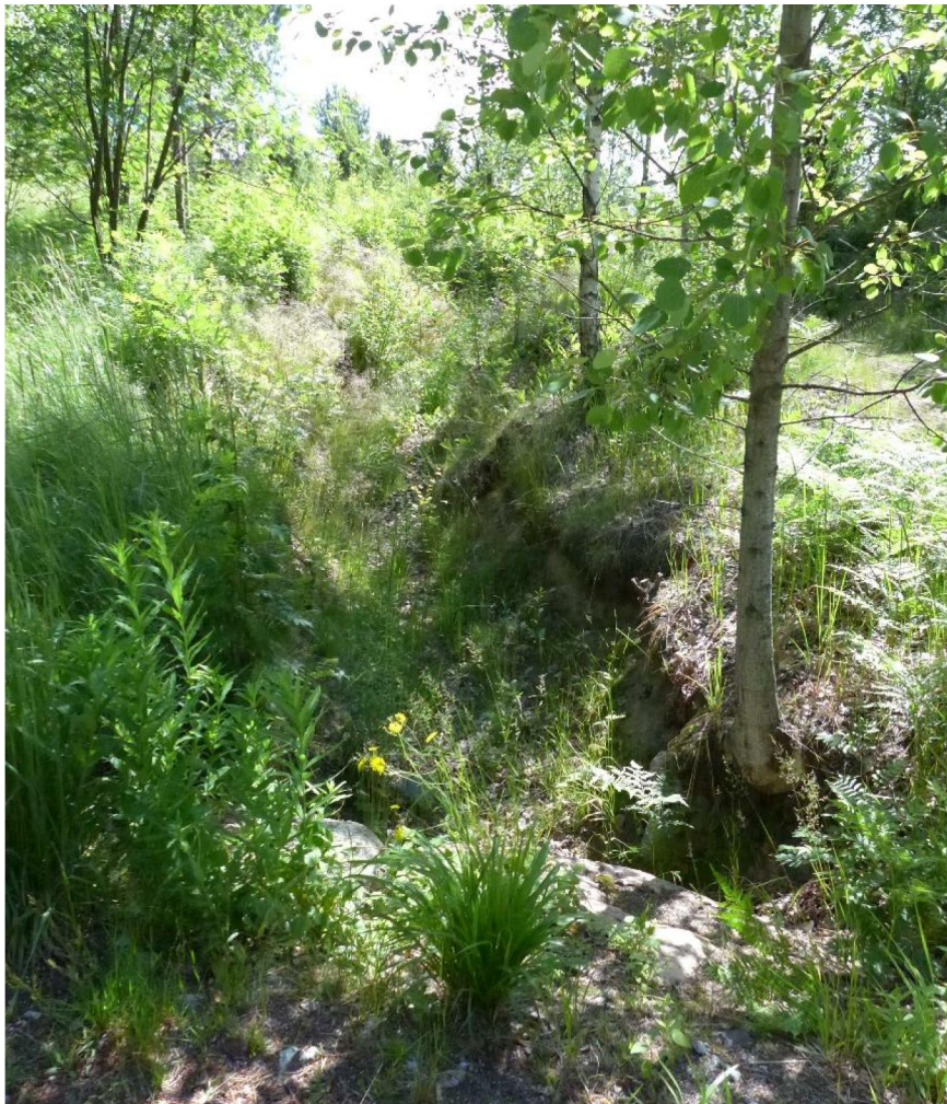
Puolustusasema IV:7, Kasvillisuuden peittämä yhdyskaivanto hiekkapolun pohjoispuolella.
