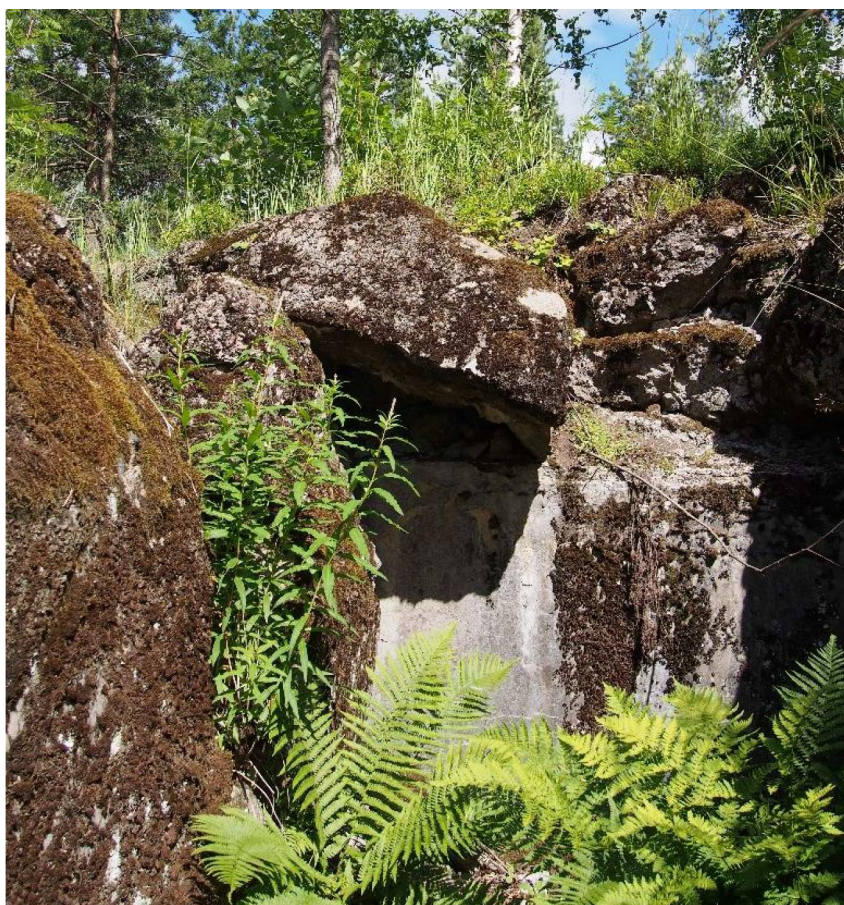
Puolustusasema IV:7, Suojahuone kallioleikkauksen eteläpuolella.
