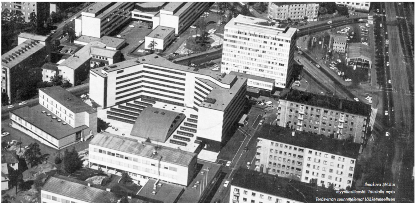
Yläriivi: TVK-talon sisäänkäynti (vas.) ja Urheilutalon toimistokerrosten sisäänkäynti (oik.), josta tulee Urheilutalon uusi pääsisäänkäynti. Keskirivi: Urheilutalon toimistokerrosten sisäänkäyntiaula (vas.) ja TVK-talon sisäänkäyntiaula nykytilassa. Alarivi: Ilmakuva korttelista ennen korotuksia ja lisäyksiä.
