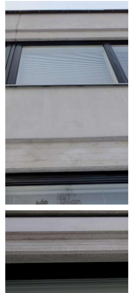
Yllä: Uusittua julkisivua. Alkuperäinen ulkonäöllinen ero sileiden betonielementtien ja ikkunoiden yläpuolisten otsien välillä on säilytetty, mutta otsat eivät enää ole paikallavalettuja erillisiä osia vaan osa kuorielementtiä. Tuuletus korjauksen jälkeen ikkunan yläpuolelta
