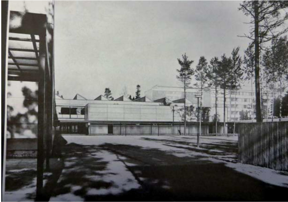
Eteläpiha. Eteläpään purretun sisäänkäyntikatoksen reunaa, pyöräkatoksen lautamuottipintaisen muurin reuna. HKA.
