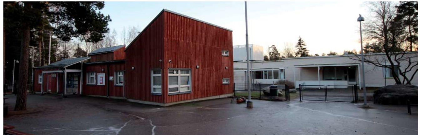
Peruskorjattu leikkipuistorakennus, takana kansakoulun yhteyteen kuuluva entinen sosiaalitoimen rakennus
