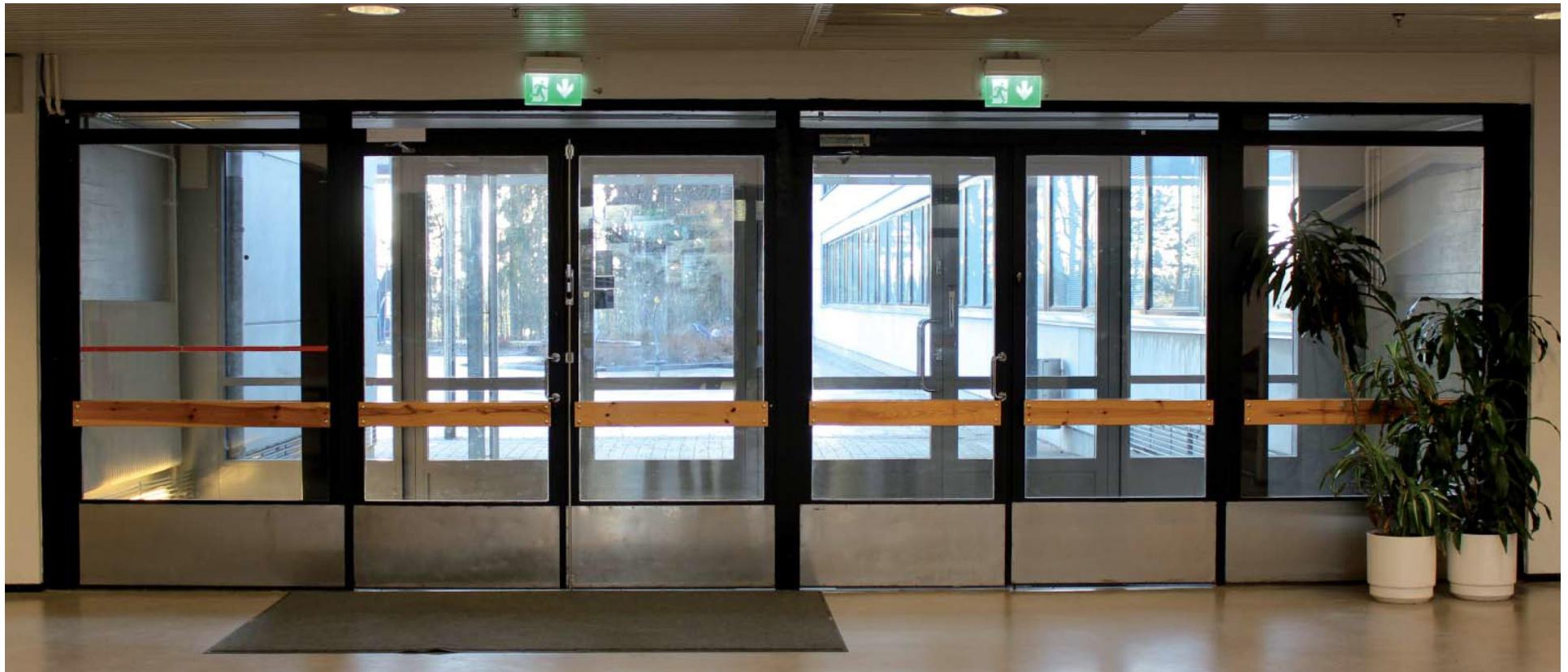
Aulan teräslasiovet mäntypuisine vetimeineen luokkasiiven eteläpäädyn ensimmäisen kerroksen uloskäynnin kohdalla.
