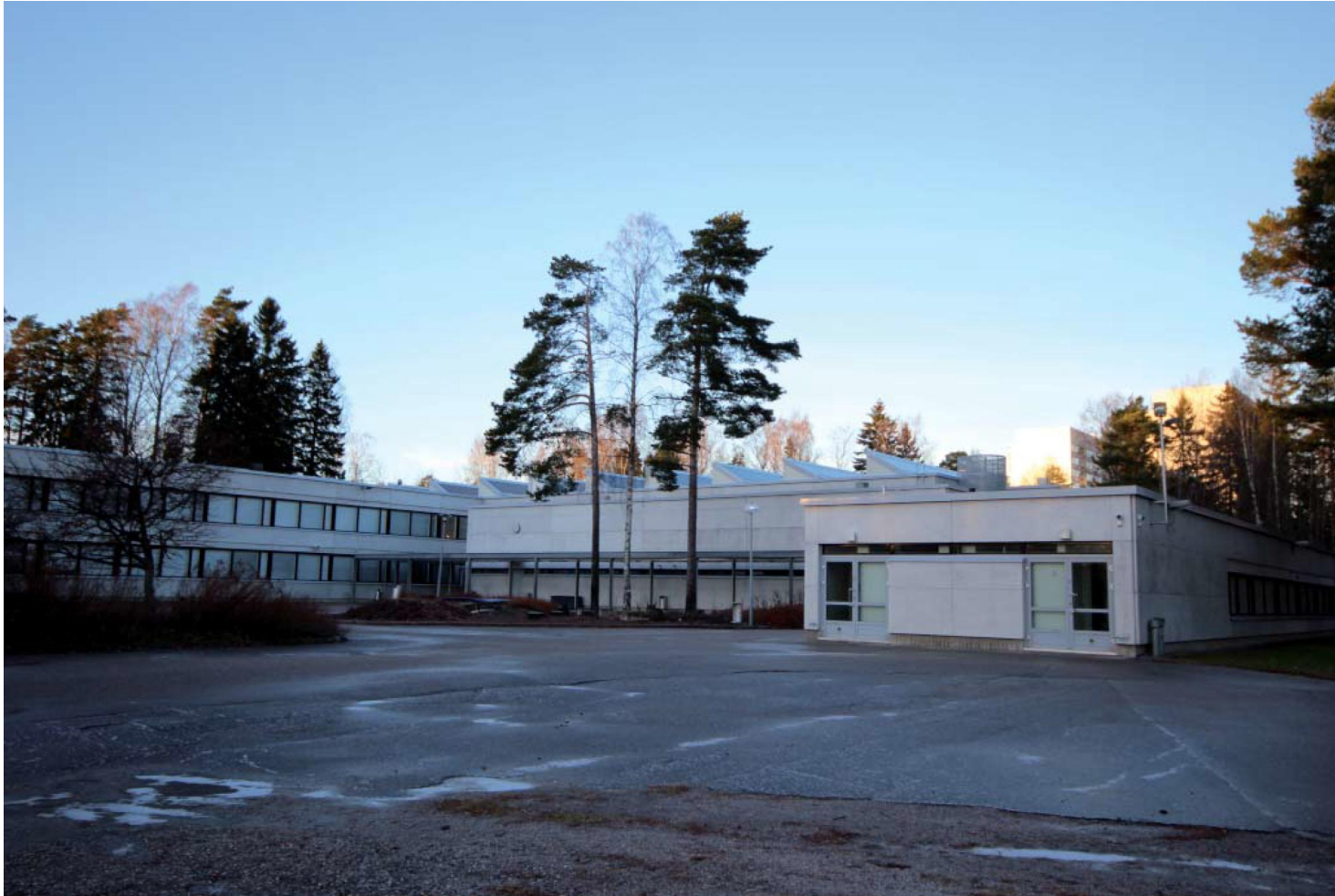
Peruskoulu piharakennuksineen, eteläjulkisivut
