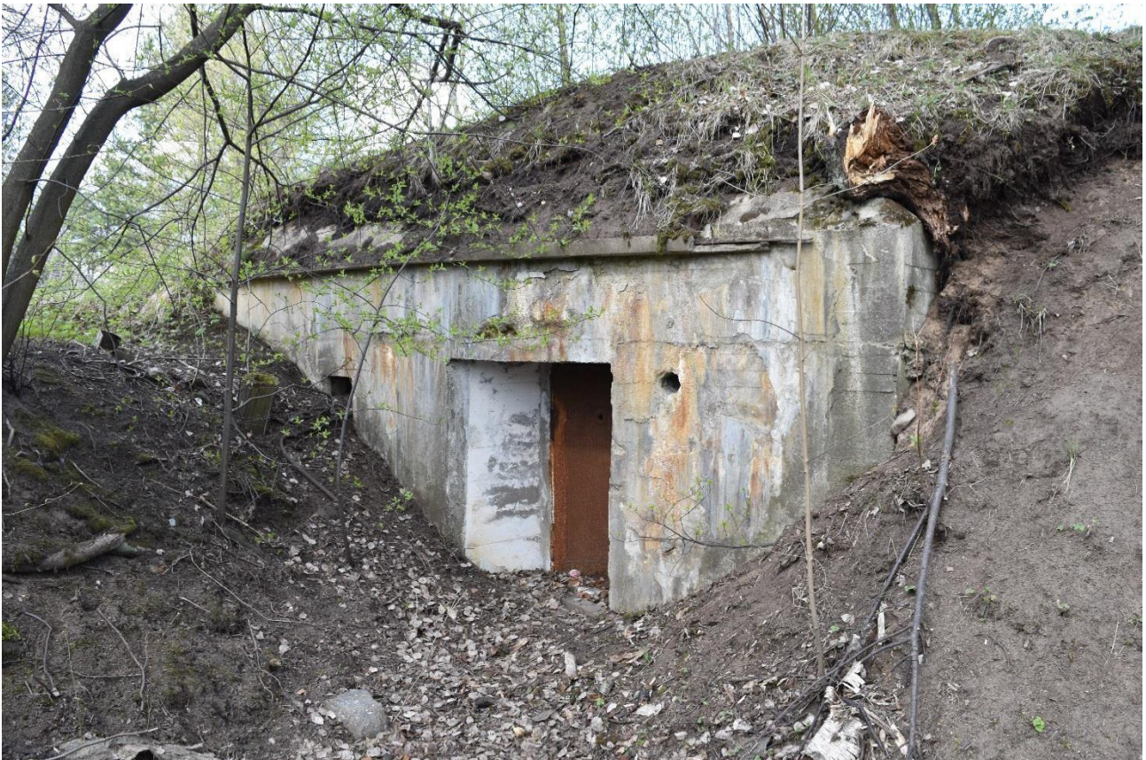
Kuva: Väestönsuojaksi korjattu puolustusaseman IX:3 suojahuone Malmin lentokentällä. Valtteri Heinonen 8.5.2017.
