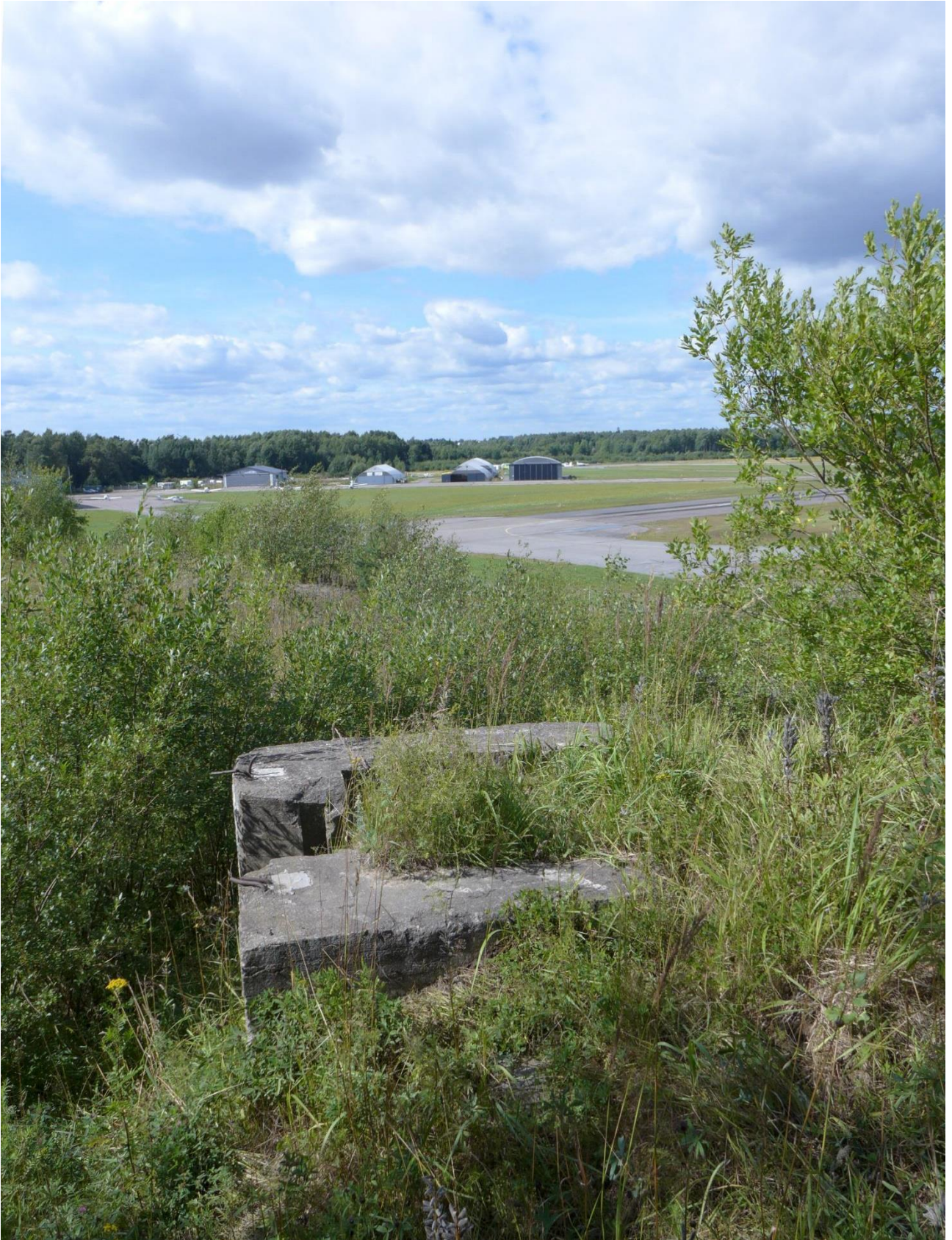
Kuva: Betonista valettu tulasema. Päivi Hakanpää 8.8.2017.
