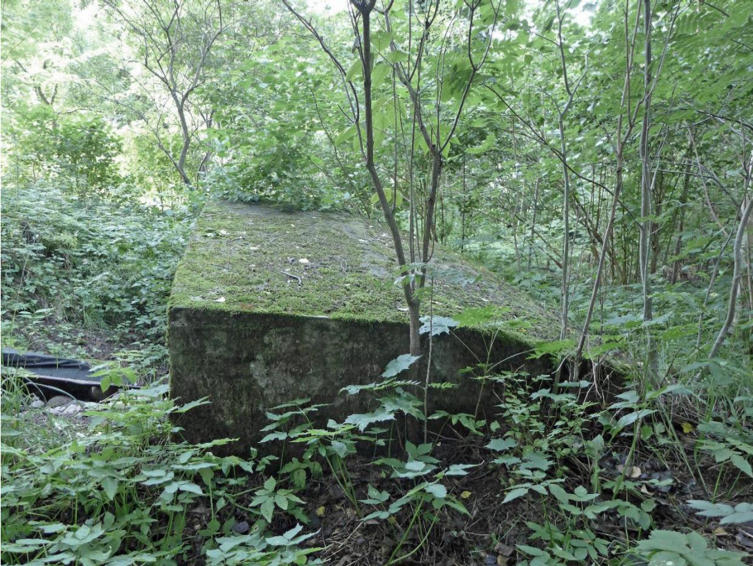
Kuva: Tien eteläpuolella olevan suojuhuoneen katto on kaareva. Päivi Hakanpää 8.8.2017.
