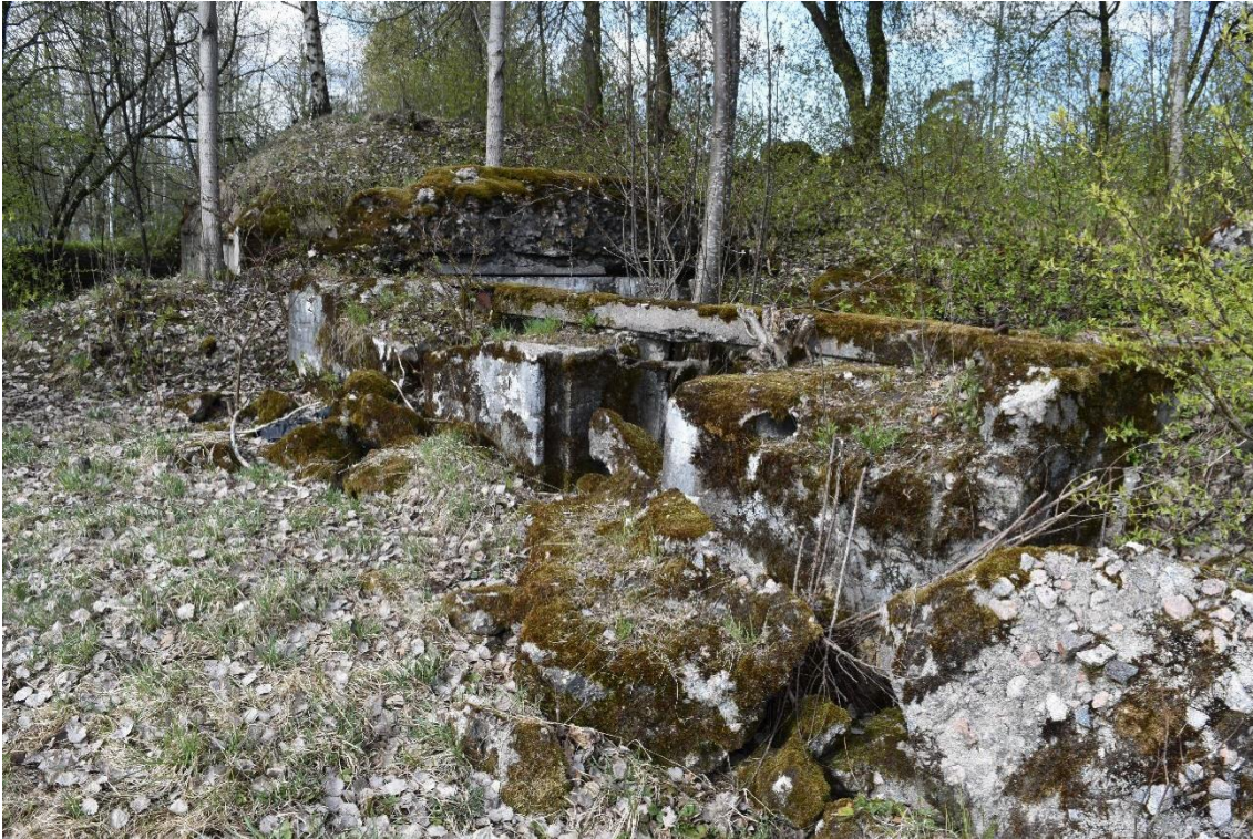
Kuva: Yksi suojahuoneista tien länsipuolella on jäänyt kunnostamatta. Valtteri Heinonen 8.5.2017, Helsingin kaupunki.
