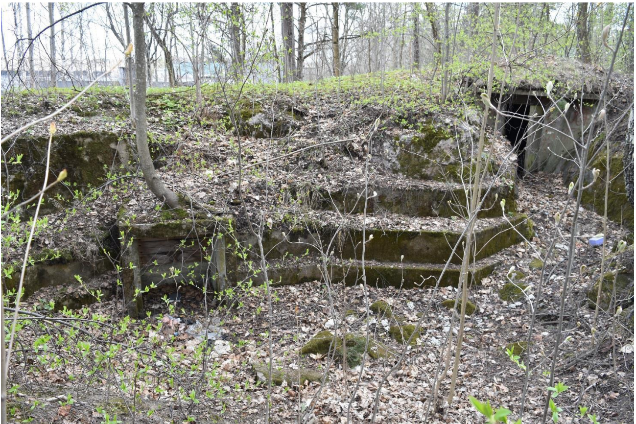
Kuva: Taisteluhaudan porrastettua seinämää ja komero. Oikealla on ovi kellariksi muutettuun tuliasemaan. Valtteri Heinonen 8.5.2017. Helsingin kaupunki.
