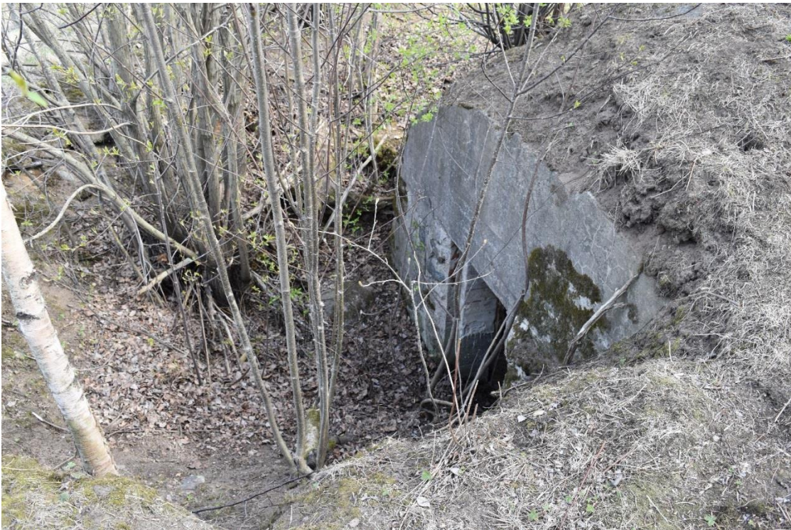
Kuva: Kivistä muurattu betonikattoinen suojahuone. Valtteri Heinonen 8.5.2017, Helsingin kaupunki.
