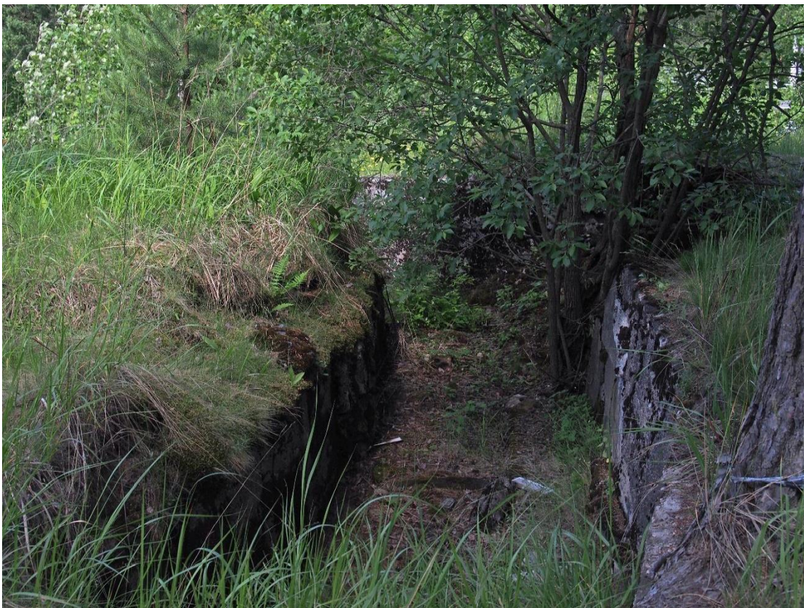
Kuva: Tukikohdan IV:7 betonilla lujitettua yhdyskaivantoa. Päivi Hakanpää 4.7.2017
