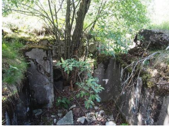
Kuva vasemmalla: Länsiosan tuliaseman katto on räjäytetty ja se on täyttynyt betonilohkareista. Sakari Mentu 4.7.2017, Helsingin kaupunki.
