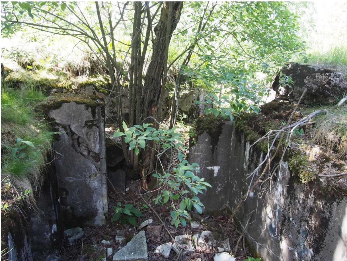
Puolustusasema IV:7, Itäosan tuliaseman pohja on peittynyt maalla. Sen kulkuaukon pielet ovat säilyneet ehjinä.
