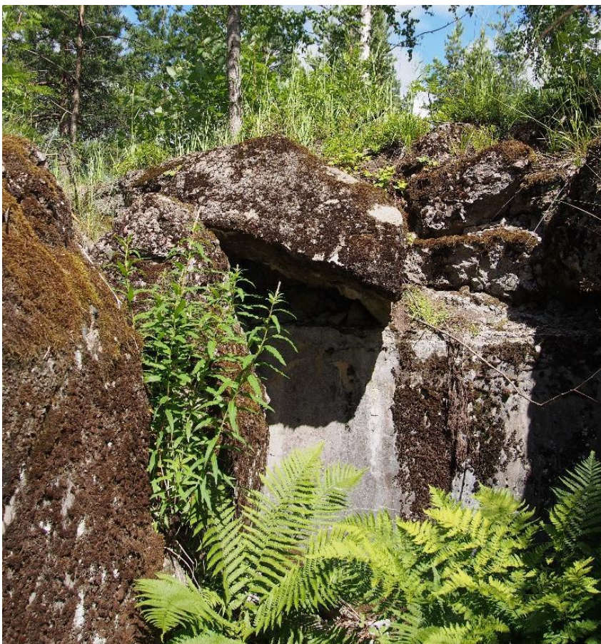
Puolustusasema IV:7, Suojahuone kallioleikkauksen eteläpuolella.
