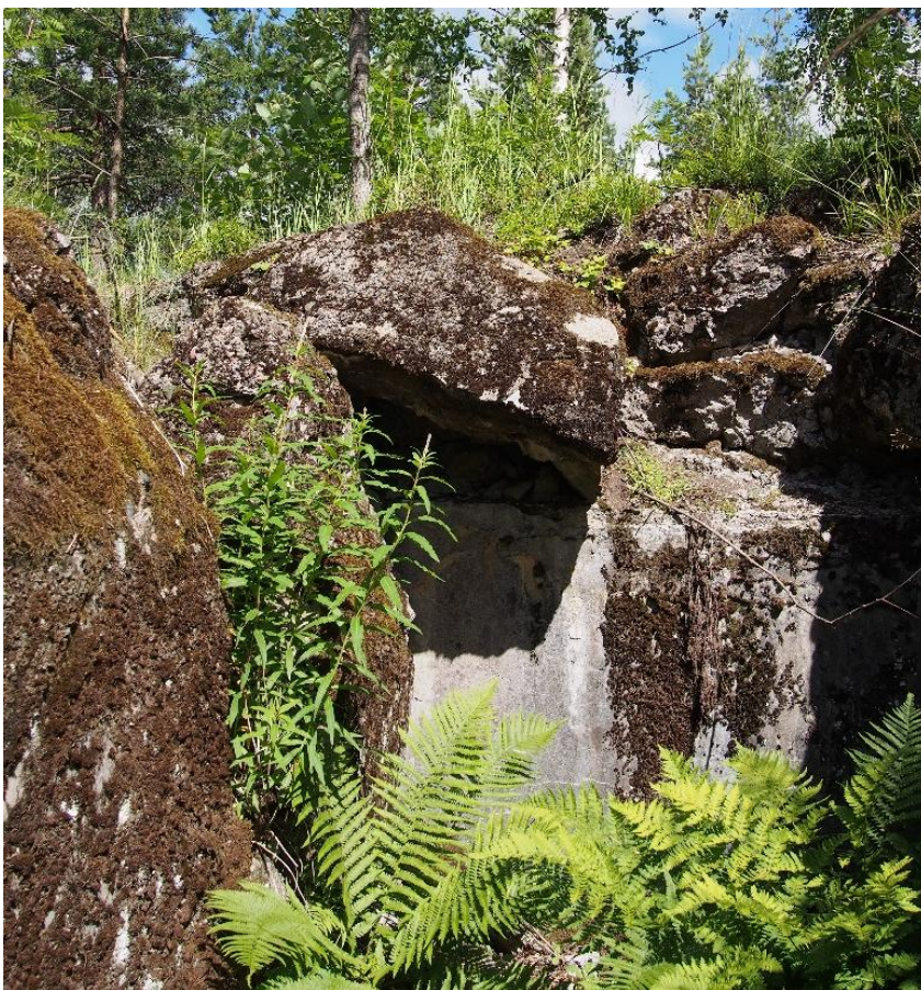
Puolustusasema IV:7, Suojahuone kallioleikkauksen eteläpuolella.
