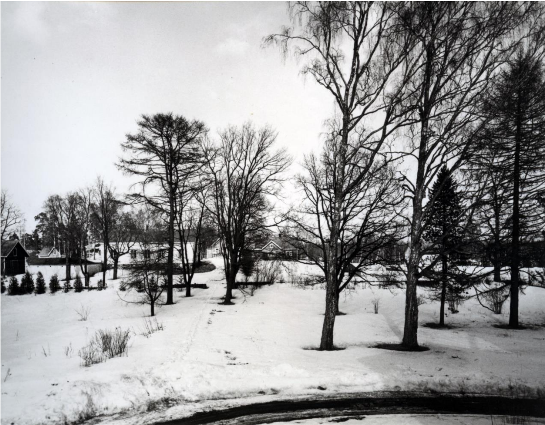
Kuva 17. Näkymä Nordsjön kartanon päärakennuksen edustalta pehtoorin asunnolle päin. Vasemmassa reunassa tallin pääty. Kiviaidan vieressä, kuvassa polun vasemmalla puolella on douglaskuusen taimia. Kuva Stig Bergström 1966. Vantaan kaupunginmuseo
