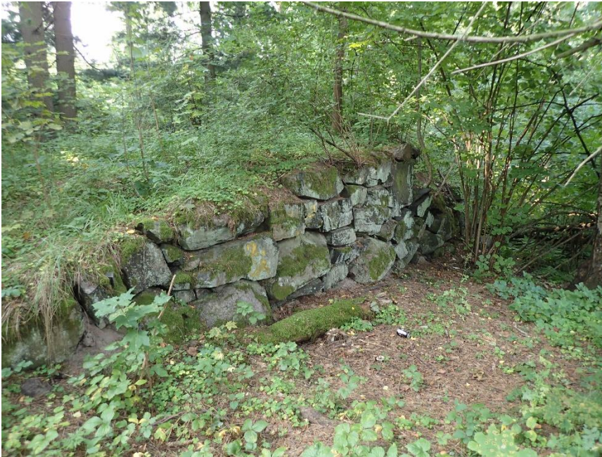
Kuva 33. Vanha ajoluiska on ilmeisesti johtanut poistetun rakennuksen yläkertaan. Kuvan oikeassa laidassa näkyy pähkinäpensas.
