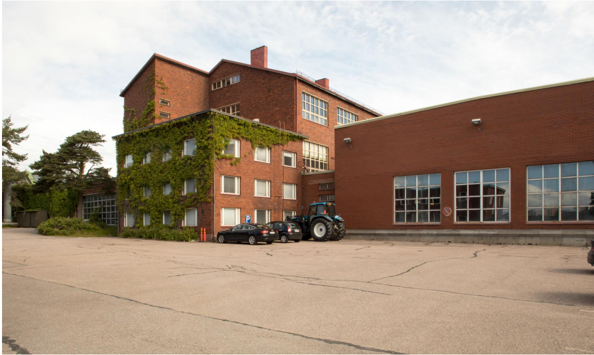
Tehdasrakennuksen eteläjulkisivussa yhdistyy monia eri rakennusvaiheita
