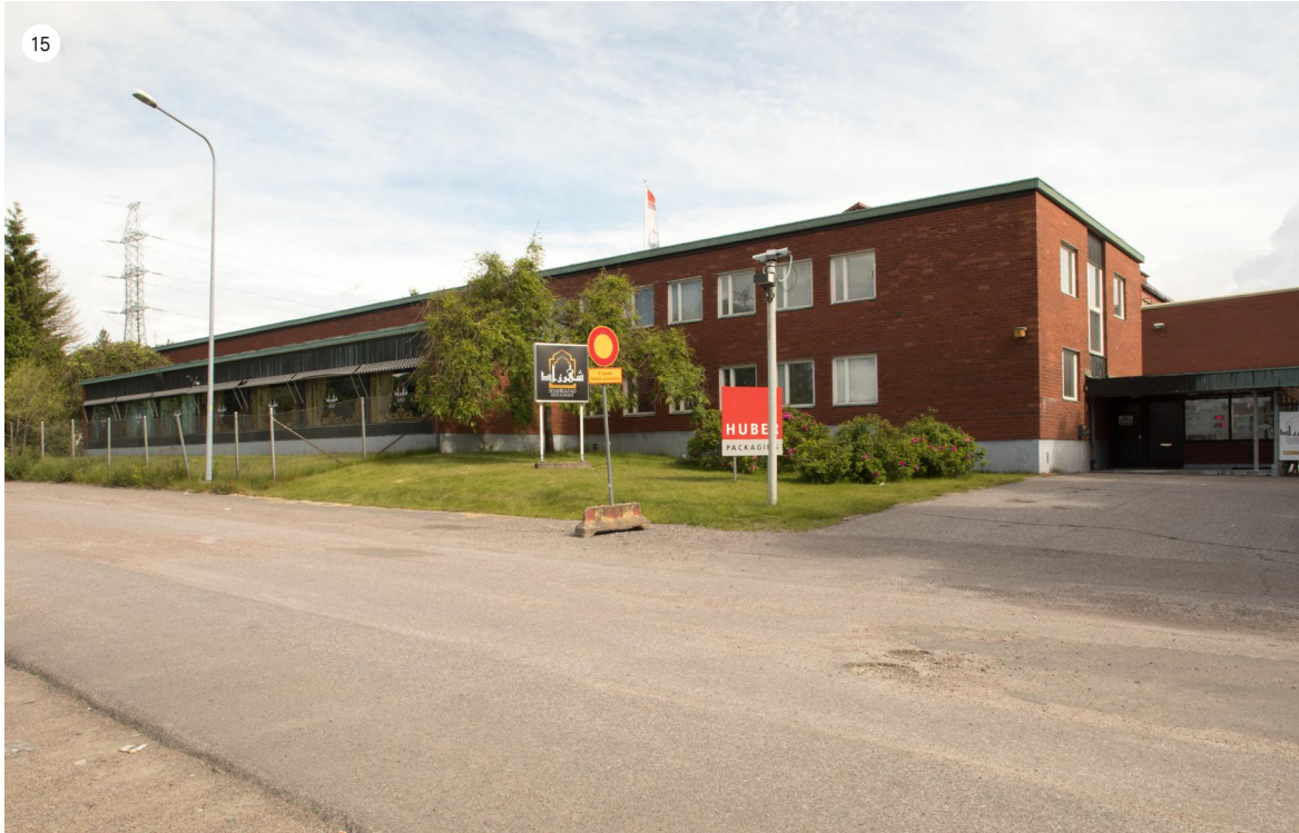
Toimistorakennus rajaa tonttia etelään. Rakennus on vuodelta 1963 ja sen on suunnitellut arkkitehti Heimo Kautonen.
