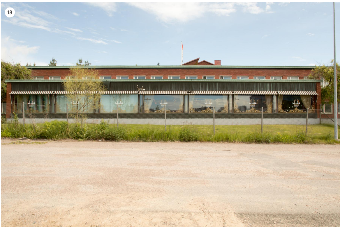
Toimistorakennuksen eteläsivulla on rakennusmassasta ulkoneva yksikerroksinen osam jonka julkisivussa on kuparilevyä ja suuret ikkunapinnat.
