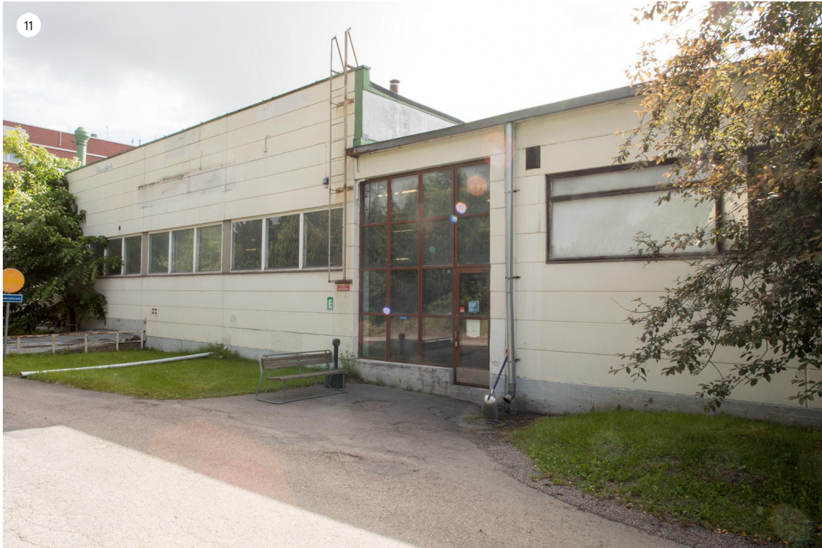
Länsilaidan viimeinen laajennusosa on vuodelta 1971 (1h) ja erottuu kokeampana massana. Liitokohtaan vuoden 1966 (1e) rakennuksen kanssa rakennettiin välikappale, jossa on iso ikkunapinta. Julkisivut ovat Siporex-elementtiä.
