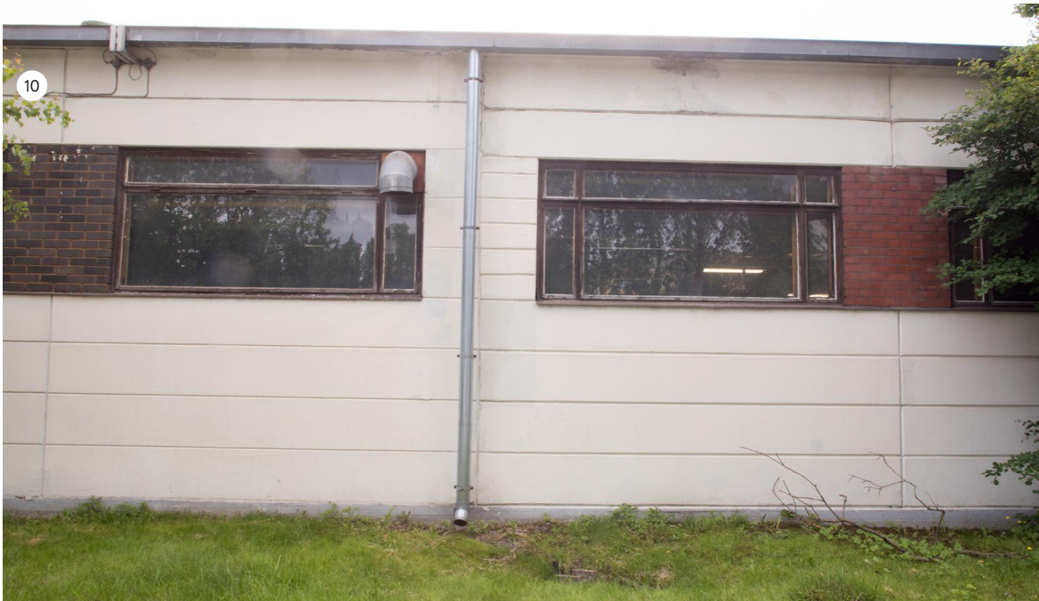
Vuosien 1963 (1c) ja 1966 (1 d) laajennusten liitokohta. Materiaalit ja massoitelu pysyvät samoina, mutta tiilidetallit on muurattu tummemmasta tiilestä.
