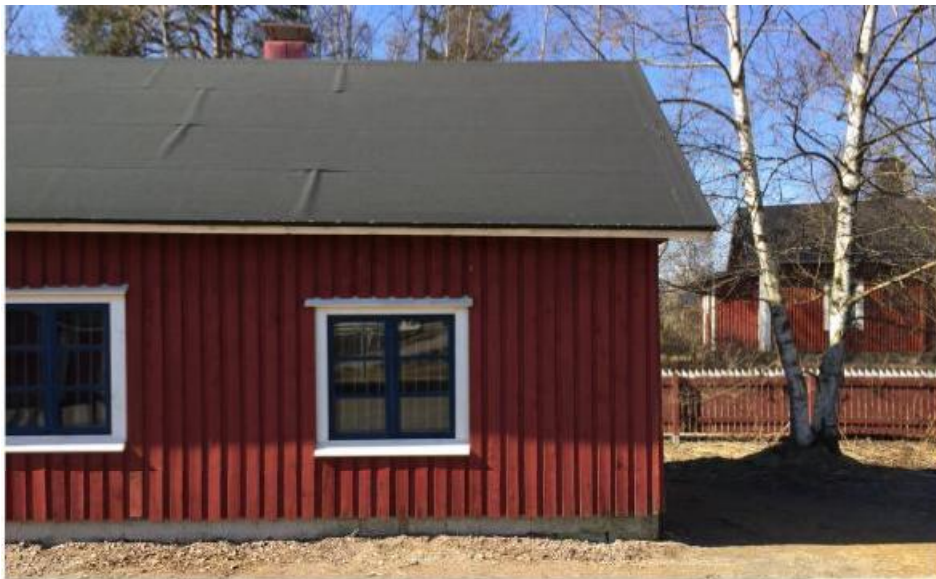
Vanha sauna on muutettu ponitalliksi
