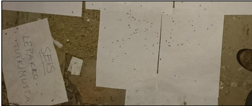
Kuva 5. Kaivoshuvilan ullakon piipun juureen asennetuille papereille oli kertynyt useita kymmeniä lepakon papanoita, 23.8.2017.
