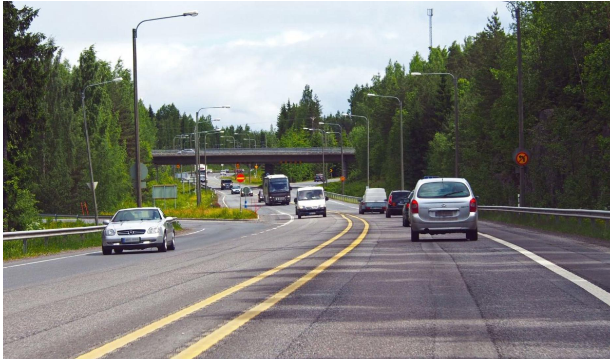
Kuva 39 Leveä keskimerkintä kaksoisjyrsinnällä auttaa kuljettajia pysymään oman ajosuunnan puolella erityisesti talviaikaan sellaisissa kohdissa, joissa poikkileikkaukseen kuuluu monta kaistaa. Toimenpidettä esitetään Torttilan, Harjavallan, Peipohjan, Nyhkälän/Polarin ja Nummelanharjun eritasoliittymiin.
