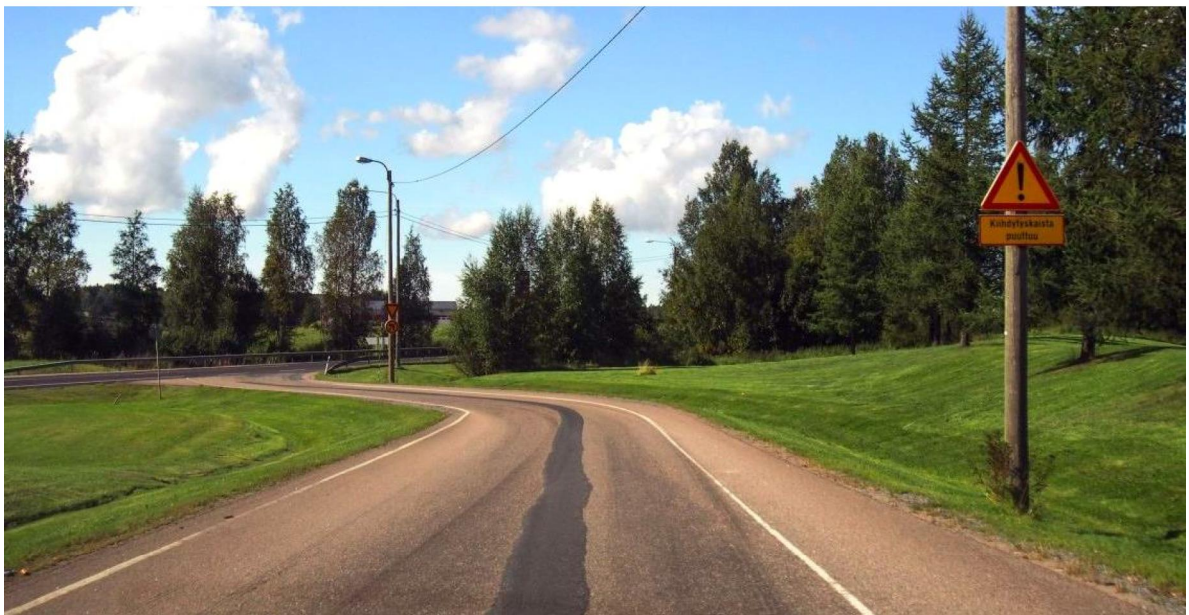
Kuva 8 Puuttuvia liittymiskaistoja on valtatiellä 2 Laanin (vt 8, Pori), Nakkilan (kuvassa), Mommolan (Huittinen, vt 12/kt 41), Humppilan (vt 9) sekä Pilvenmäen ja Yhtiönkadun (Forssa) eritasoliittymissä.
