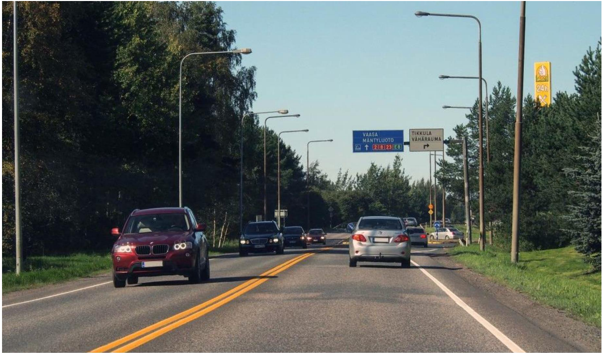
Kuva 52 Valtateiden 2 ja 8 yhteinen osuus Porin Tikkulan kohdalla on nykytilassa ruuhkautuva pullonkaula, joka vaatii nelikaistaistamista. Samassa yhteydessä on järkevää nelikaistaistaa koko jakso Laanin ja Tiilimäen eritasoliittymien välillä. Kohteeseen esitetään lisäksi uutta rinnakkaiskatua ja sen mahdollistamaa Tikkulan eritasoliittymän täydentämistä länsipuolen rampeilla.
