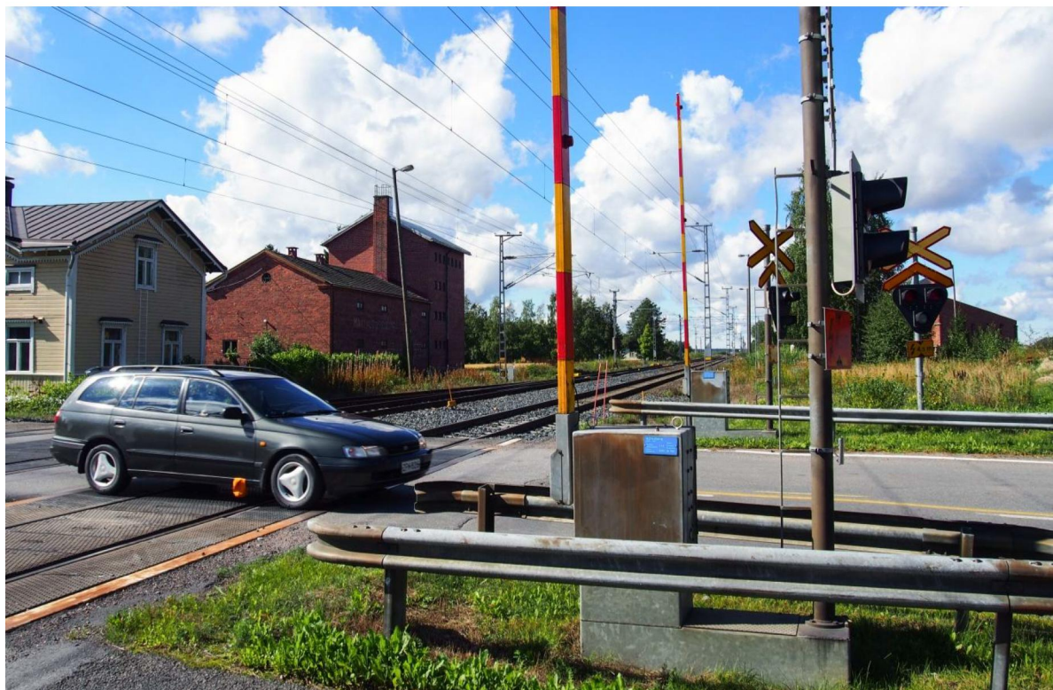
Kuva 40 Tasoristeysiä esitetään poistettavaksi Pori-Mäntyluoto-rataosuudella ja Kokemäen Peipohjassa. Erityisesti vaarallisimmista ja helpoimmin korvattavista tasoristeyksistä tulisi vähitellen pyrkiä eroon myös muissa kohdissa.
