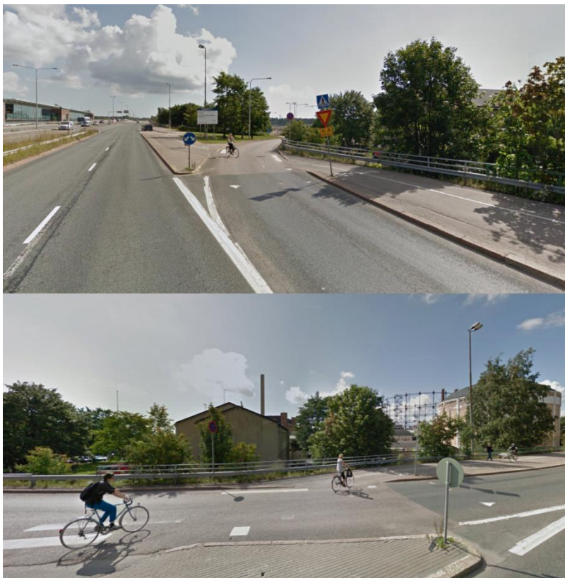
Kuva 1.3. Liittymä Junatiellä, nykyään jo purettu. (Google Maps)
