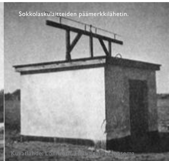
Sokkolaskulaitteiden suuntalähtetimen antenni.
