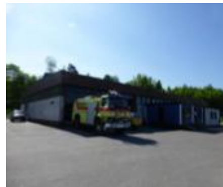
5. Autosuoja ja huoltorakennus
