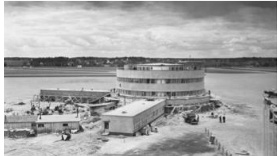
Terminaalin rakennustyöt 1937-38. (Pietinen / MV)
