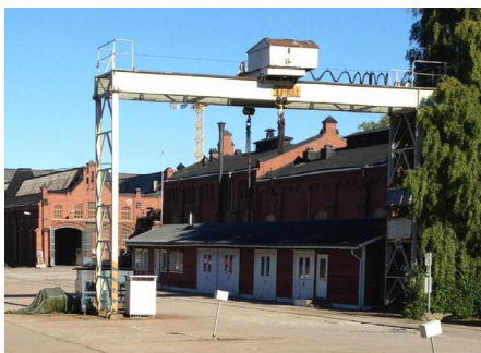
Vanha nosturirakenne siirretään Piippuaukiolle
