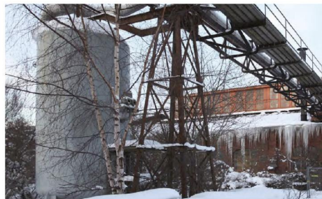
Piippuaukion säilytettävä ilmasilta ja painesäiliö
