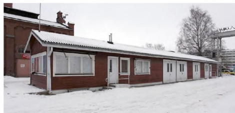
Purettava rakennus, kuljetus- ja siivousosasto
