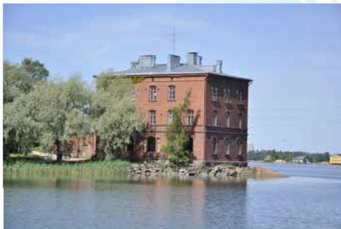
2 ...Venetsiarakennuksen alakerrassa olisi museokahvila ja veden päällä lounasterassi?
