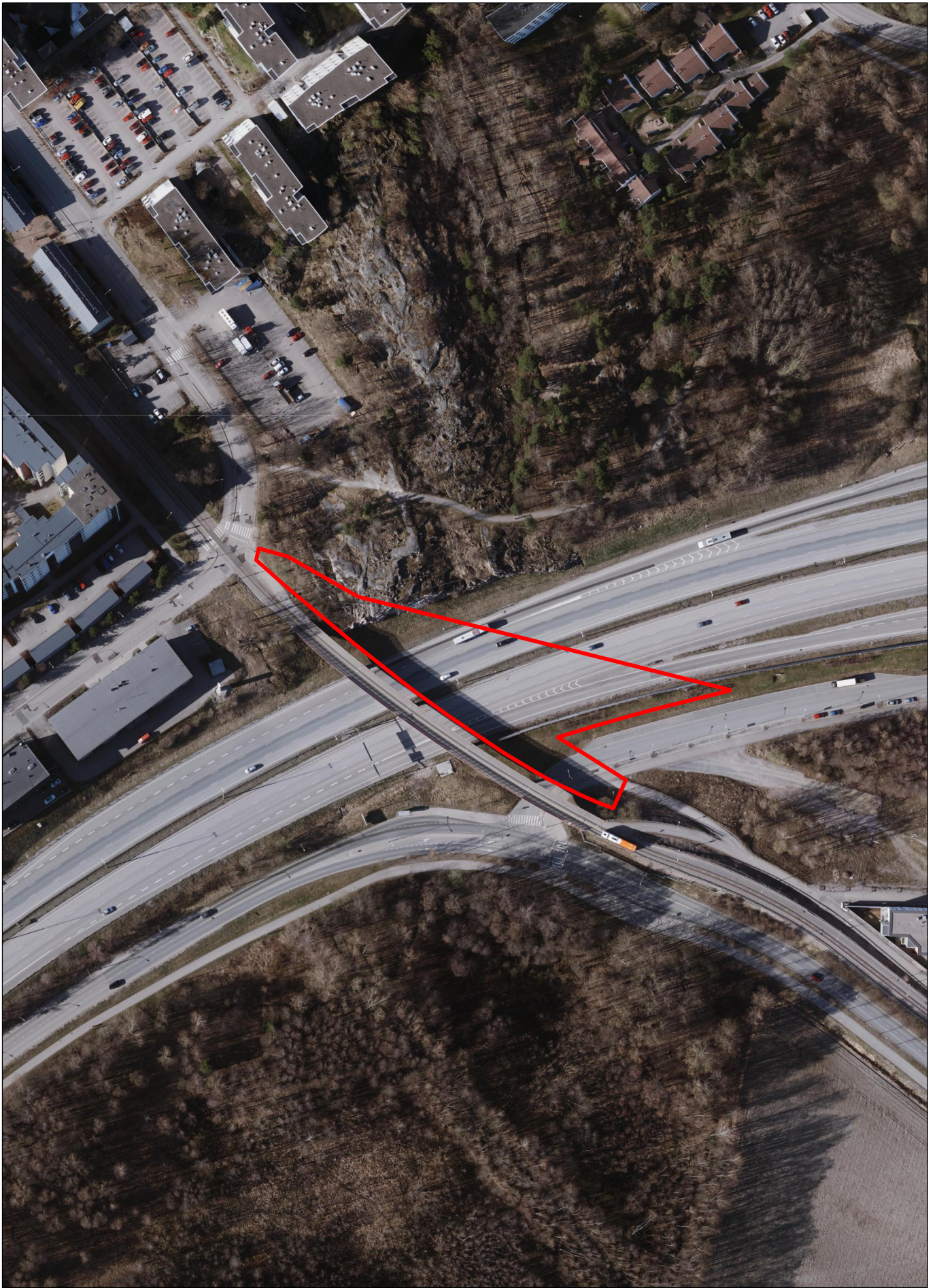
Ilmakuva 5. Lahdenväylän silta
