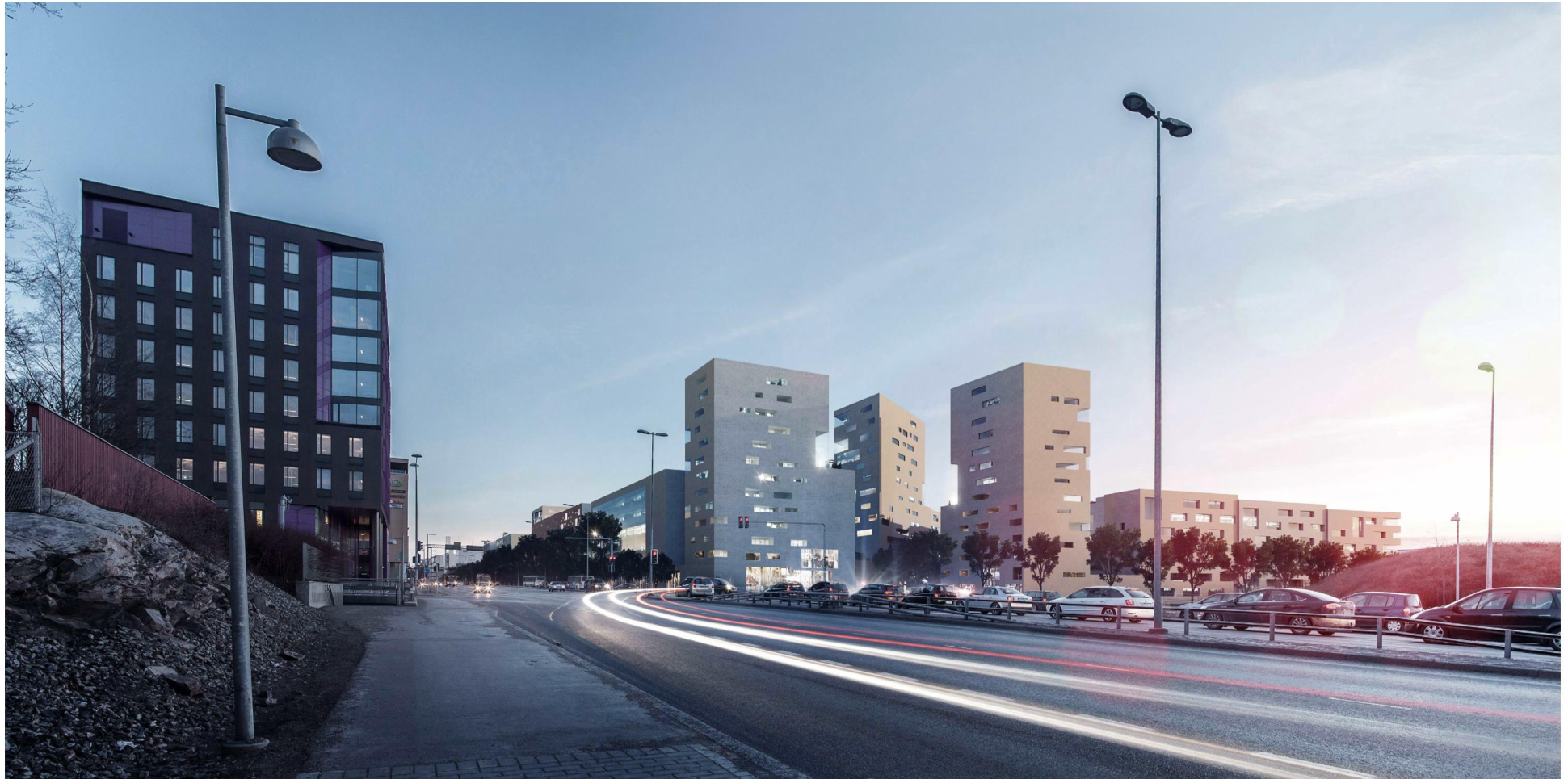
Näkymä pohjoisesta Hämeenlinnanväylältä: Kolme sisarta muodostavat portin alueelle
