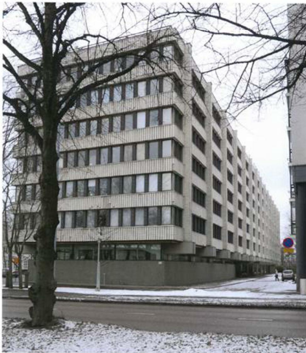
Mechelininkadun puoleinen päätyjulkisivu
