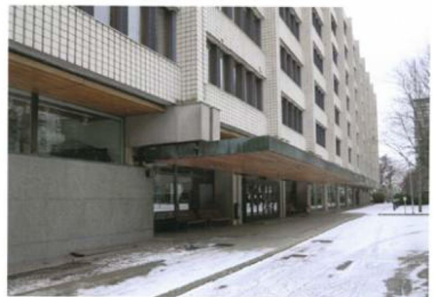
Korttelipuiston puoleista julkisivua
