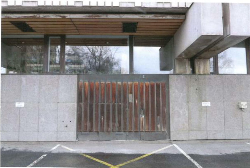
Pihakannen ulko-ovi ja seinän graniittilaatta verhous
