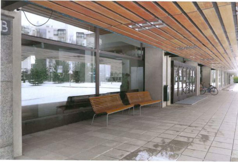
Sisäänkäyntikatokset ja tuulikaappi
