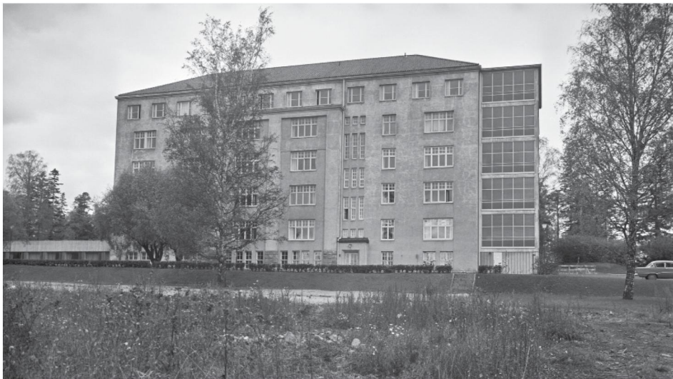
Ensimmäisessä vaiheessa rakennettu C-paviljonki kuvattuna etelästä päin vuonna 1965 (HKM)
