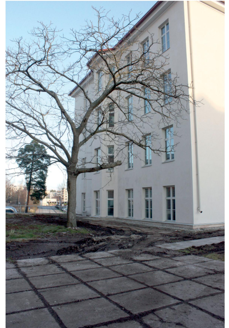
Kuva oik. Rakennus G:n päädyssä on vielä jäljellä suurikokoista betonilaatoitusta ja yksi 1960-luvulla istutetuista jalopähkinäpuista
