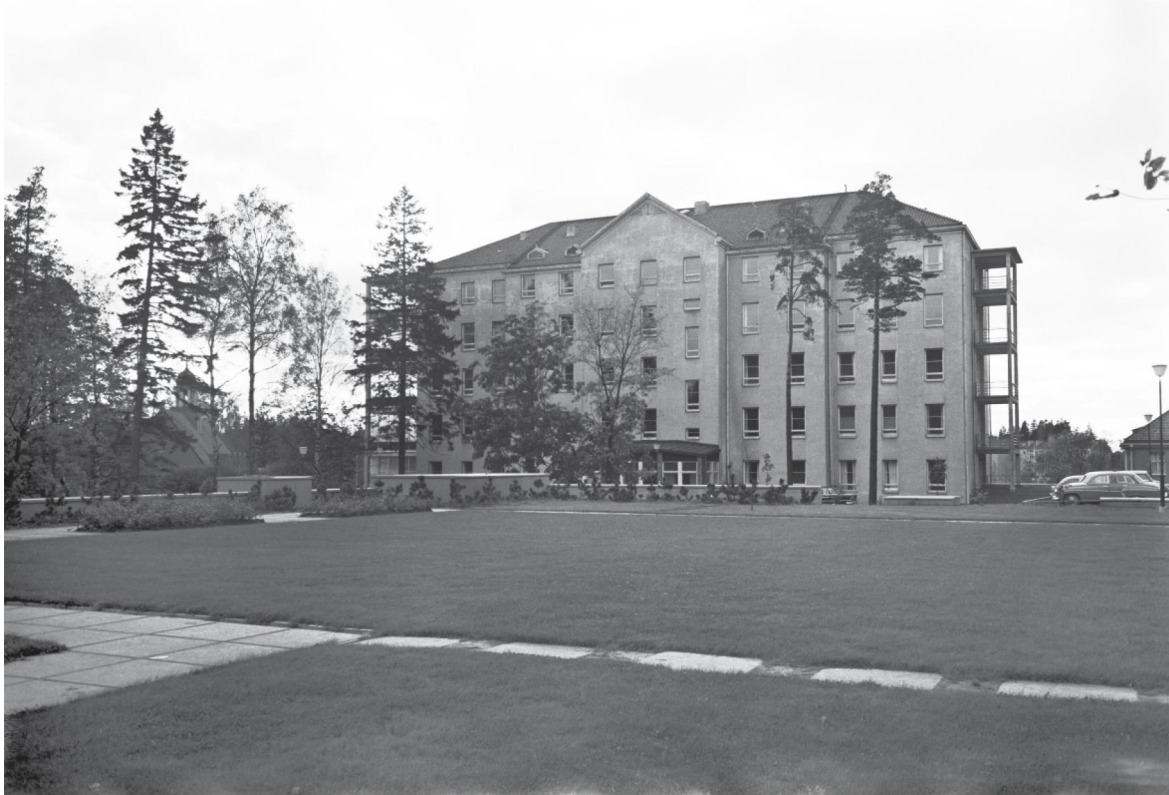
Kuva ylh. Näkymä vuodelta 1965 G-rakennukselta yli väestönsuojan kansipihan kohti paviljonki C:tä. Kansipiha toteutettiin A.Savonlahden vuonna 1961 laatiman suunnitelmien mukaan. Vuoden 1965 valokuvassa piha-alue on huolellisesti toteutettu ja se edustaa hyvin 1950-60-luvun puutarha-arkkitehtuurin suunnitteluperiaatteita.
