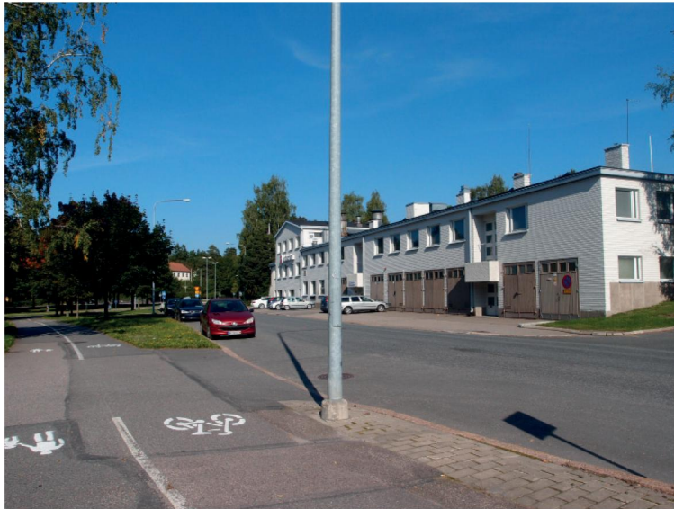
Pesularakennuksen edessä on pysäköintipaikkoja, josta johtuen katutilan rajautuminen on epämääräinen
