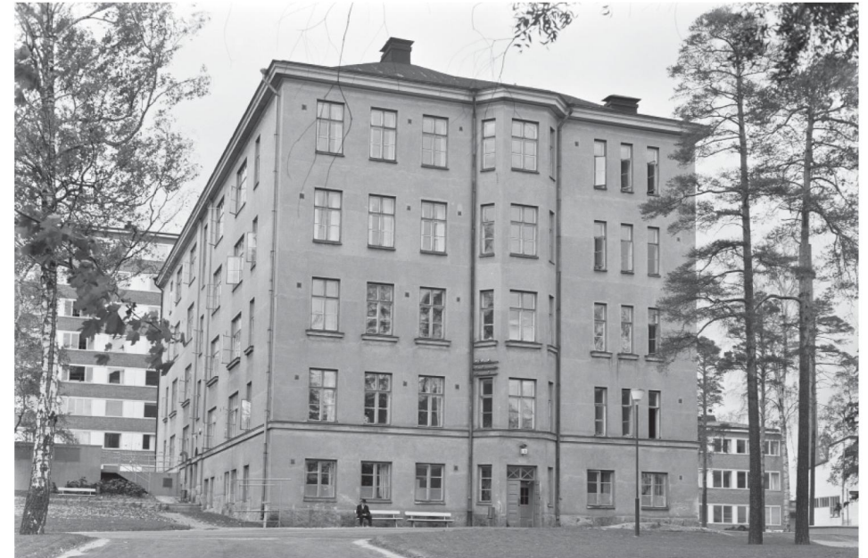
Toisessa vaiheessa rakennettu G-paviljonki kuvattu vuonna 1965 (HKM)
