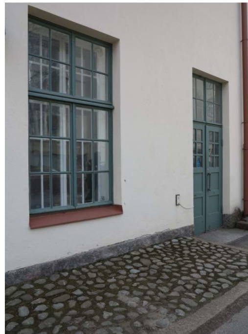
Koillissivun alkuperäinen, säilynyt puuikkuna ja -ovi .
