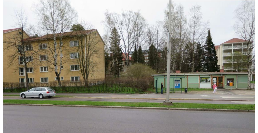
Sokkeli on harmaaksi maalattua betonia, julkisivut vaalean vihreän sävyistä poimulevyä, pystypeitelit ovat lakattua puuta. Vesikatteena punainen peltikatto.
