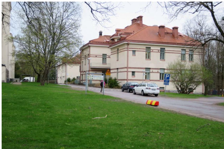
B-talo luoteesta, taustalla E-, vasemmalla A-rakennus.
