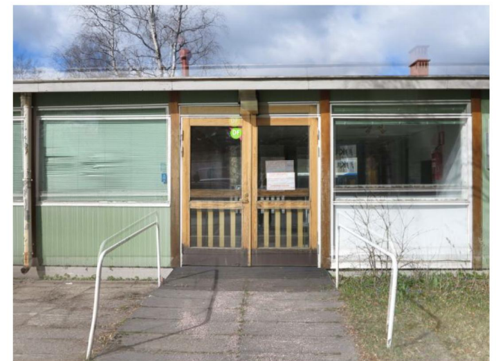
Sokkeli on harmaaksi maalattua betonia, julkisivut vaalean vihreän sävyistä poimulevyä, pystypeitelit ovat lakattua puuta. Vesikatteena punainen peltikatto.
