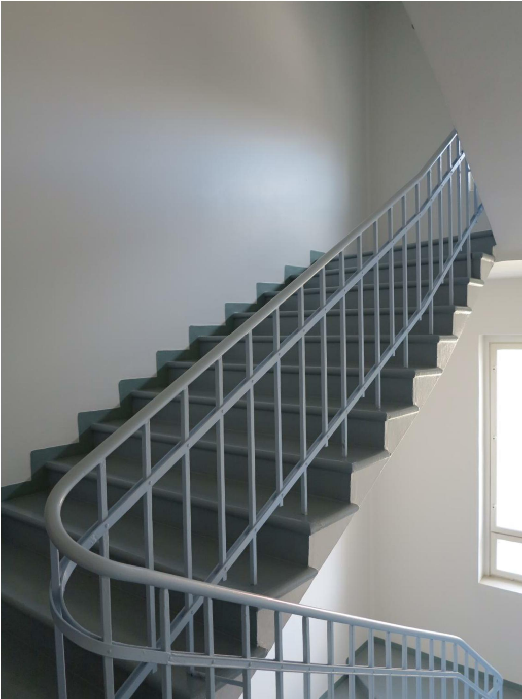
Koillissivun portaan alkuperäinen kaide ja maalatut betoniaskelmat.
