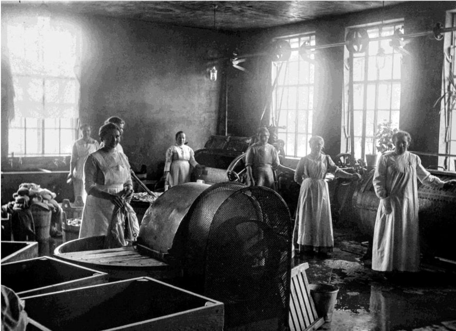
Pesula rakennuksen etelänurkassa. Taustalla teräsikkunoiden kytketyt avausmekanismit .HKM
