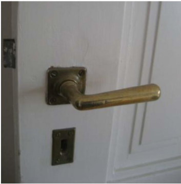
Parvekkeen ovi, jossa on säilynyt alkuperäinen mes- sinkopainike
