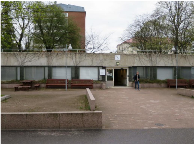
Matalan D-rakennuksen julkisivukatkelma ja ovi, josta lähtee tunneli N-rakennuksen ja väestönsuojan suuntaan.
