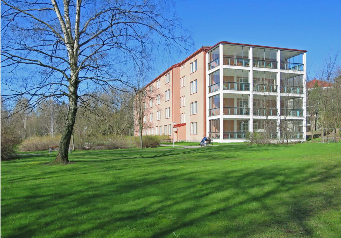
Päädyissä uudet parvekelasitukset.
