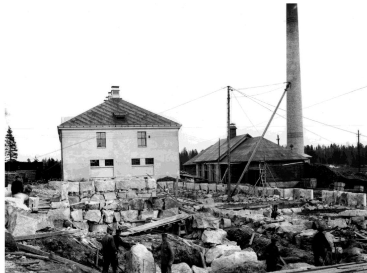
B-rakennuksen kivijalkaa rakennetaan noin vuonna 1910. Taustalla pesularakennus E, jonka vesikatteena on tilapäinen huopakatto. Oikealla alueen keskuslämmityksen pannuhuone piippuineen. HKM
