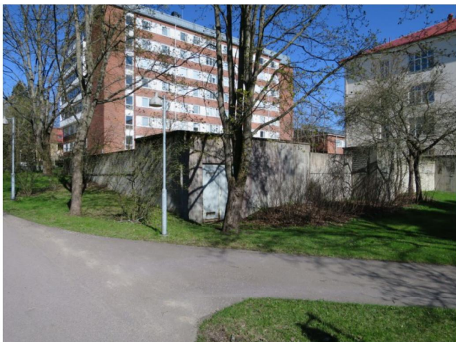
Näkymä etelästä, vasemmalla N-rakennus, oikealla G-rakennus..
