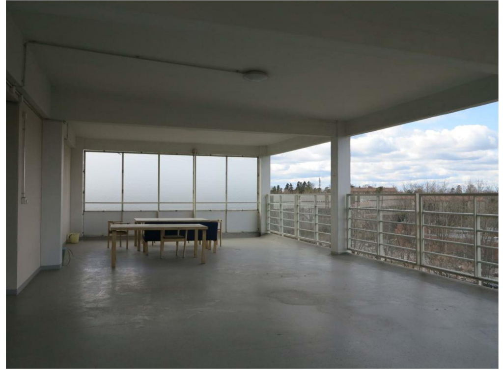
Luoteispäädyn suuri yhtenäinen lasiseinäinen parveke, 5. kerros.
