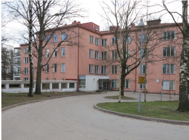
F-rakennuksen luoteissivulla näkyy pihasiiven jatkeeksi 1962 rakennettu yksikerroksinen rakennus, jonka kautta yhdystunnelista nouseaan maantasolle.
