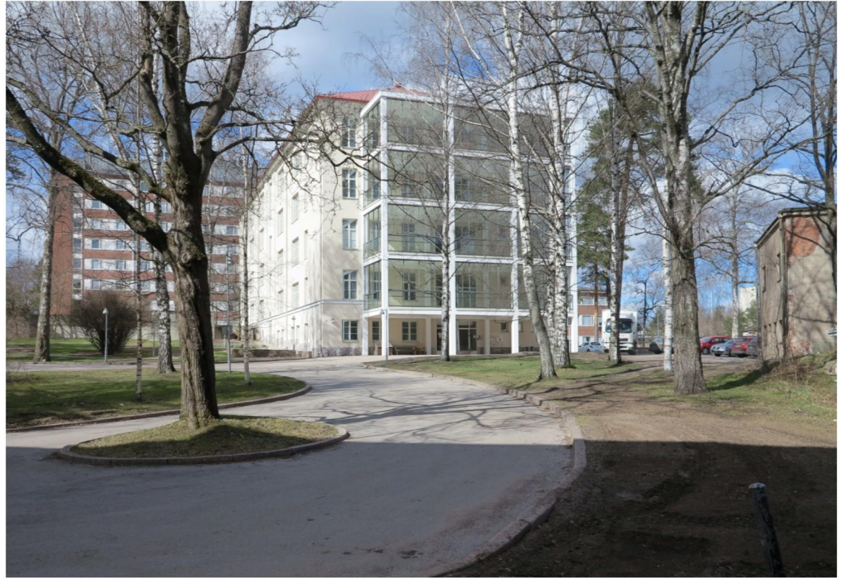
Kaakkoispään erkkeri on purettu ja eteen on rakennettu isot parvekkeet. 1968. Betonikaiteet on purettu ja parvekkeet on lasitettu. Parvekelasitus on uusittu vuonna 2014.
