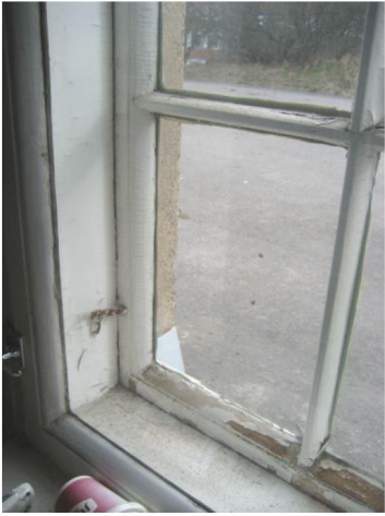
Alkuperäinen, säilynyt ikuna. Höyläprofiili on pyöristetty.
