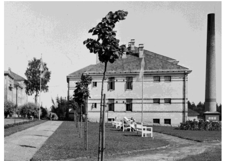
B-rakennuksen pääty. Valokuva 1900-luvun alusta (osa). Valokuva Olof Sundström, HKM.
