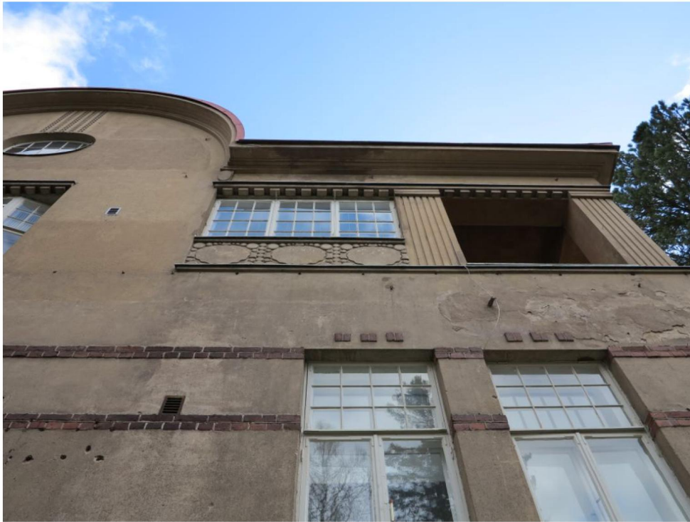
Länsikulman parvekettä kehystävät uritetut pilasterialheet.
