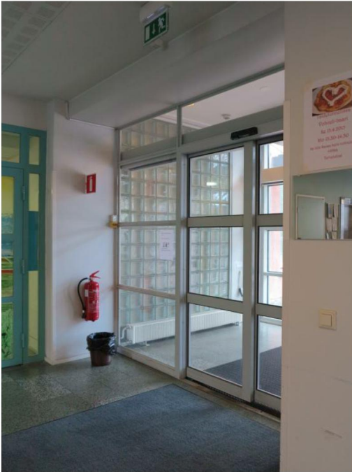
Sisäänkäynnin tuulikaappi sisältä.
