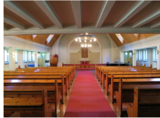
Näkymä parven alta alttarille päin. Parven reunapalkin alapinta on tehty hieman ylöspäin kaarevaksi klassisten sääntöjen mukaisesti.
