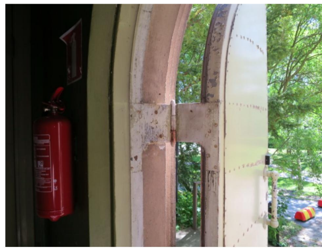
Eteläpäädyn alkuperäinen ovi, jossa on 180 asteen avautumista mahdollistava alkuperäinen sarana.
