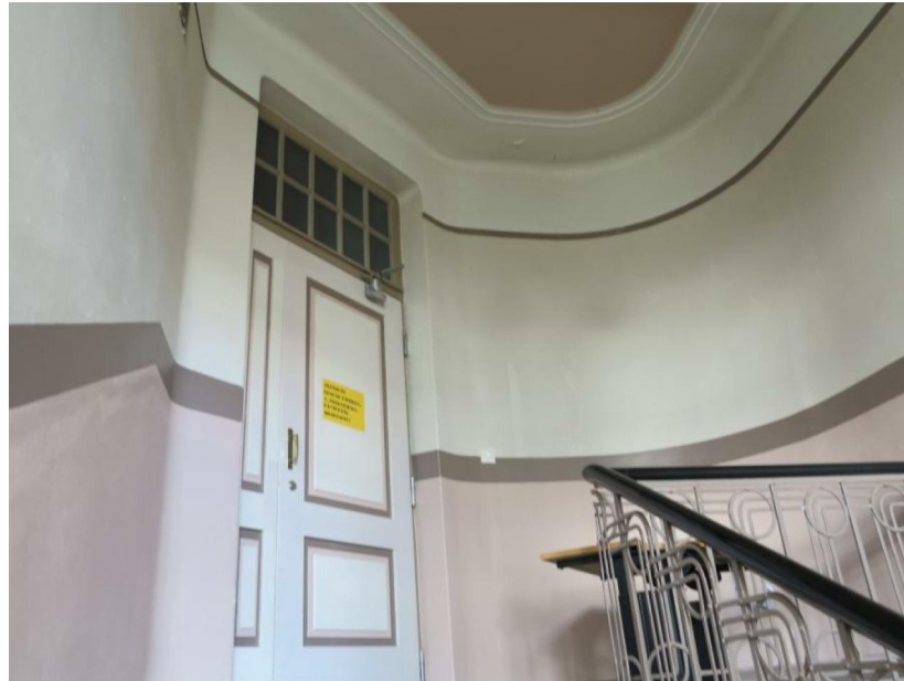
Pääportaan sirot, graafiset takorautakaiteet ja sementtimosaikkiaskelmat ovat alkuperäisiä säilyneitä rakennusosia. Nykyinen väritys tai eri väripintojen sommittelu ei perustu alkuperäisten pintakäsittelyjen tai värien tutkimukseen.
