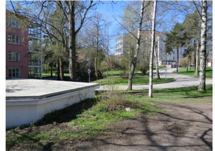
F-rakennuksen sisäänkäyntiin nousevan käytävän katto. Vrt. kuva vasemmalla.
