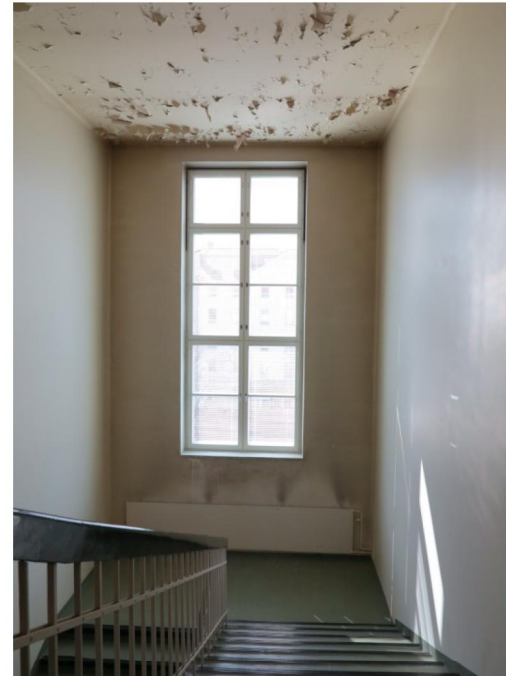
Alkuperäinen porras lounaissivulla. Askelmat ja lepotasot on päällystetty, alku- peräiset kaiteet ja käsijohteet ovat säily- neet.
