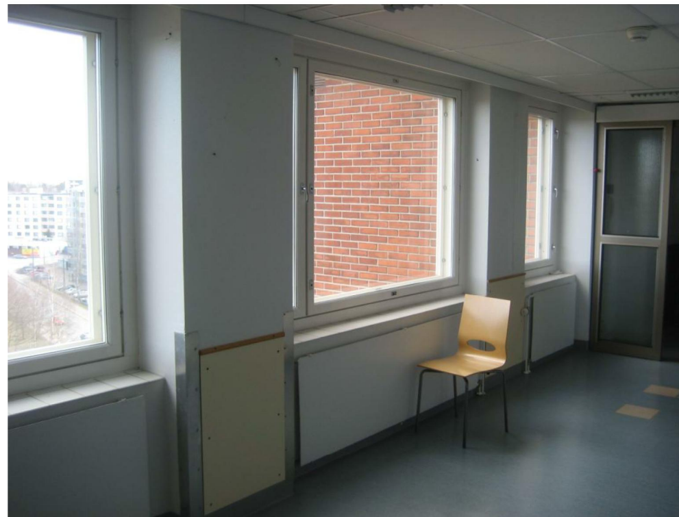
1986 toteutetut ikkunat. Vanhat yhtenäiset 2-kert. ruudut korvattu tuuletusikkunoin varustetuin sivusaranoiduin kolminkertaisin ikkunoin.
