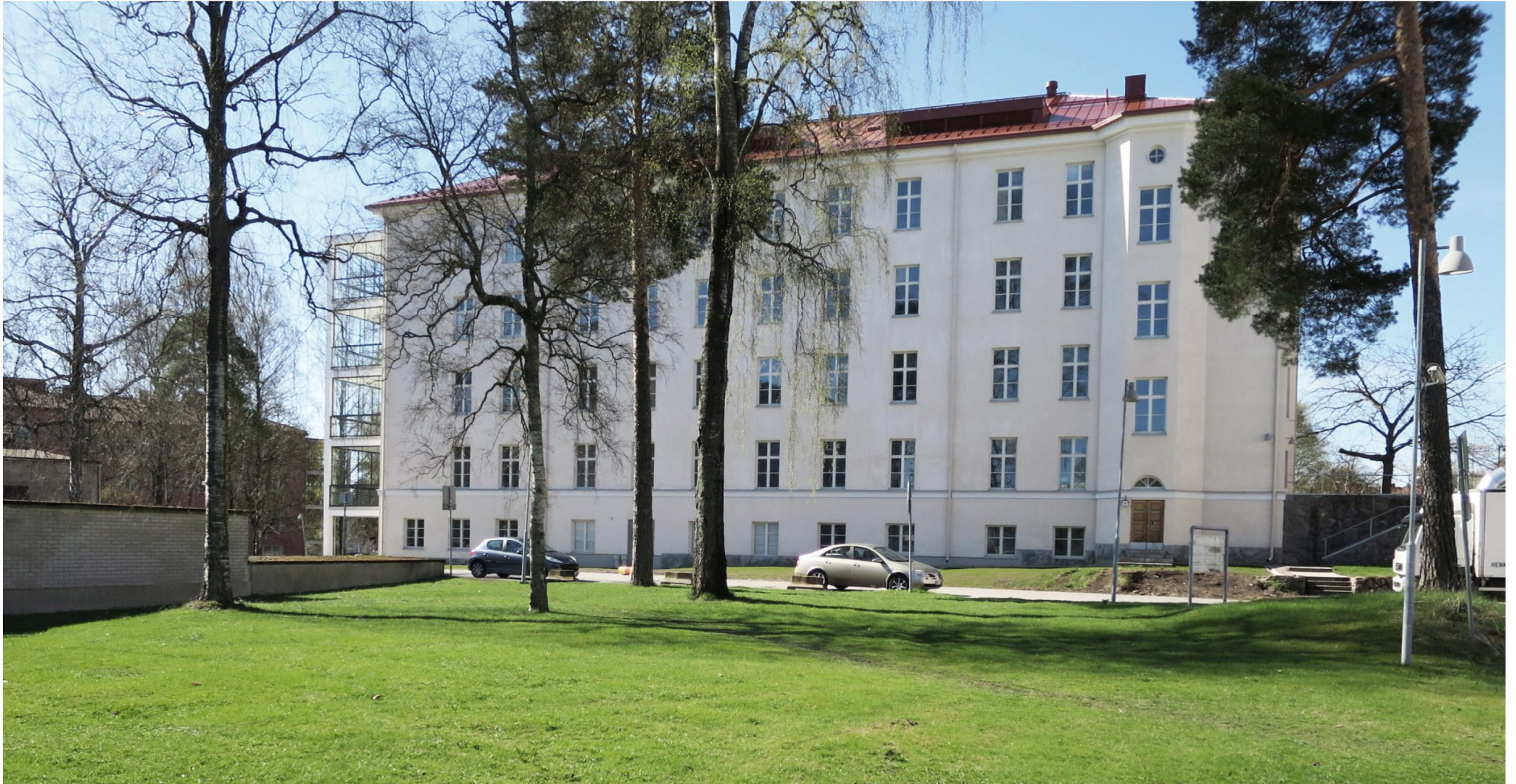
Vuoden 1968 lisärakentamisen yhteydessä noudatettiin koillisivulla johdonmukaisesti alkuperäistä, muuriaukkoihin perustuvaa julkisivusommitelua. Umpeen rakennetuilla osilla tehtiin entisten kaltaisia moniruutuisia ikkunoita. Vuonna 2014 ikkunat uusittiin vanhaa jakoa noudattaen.
