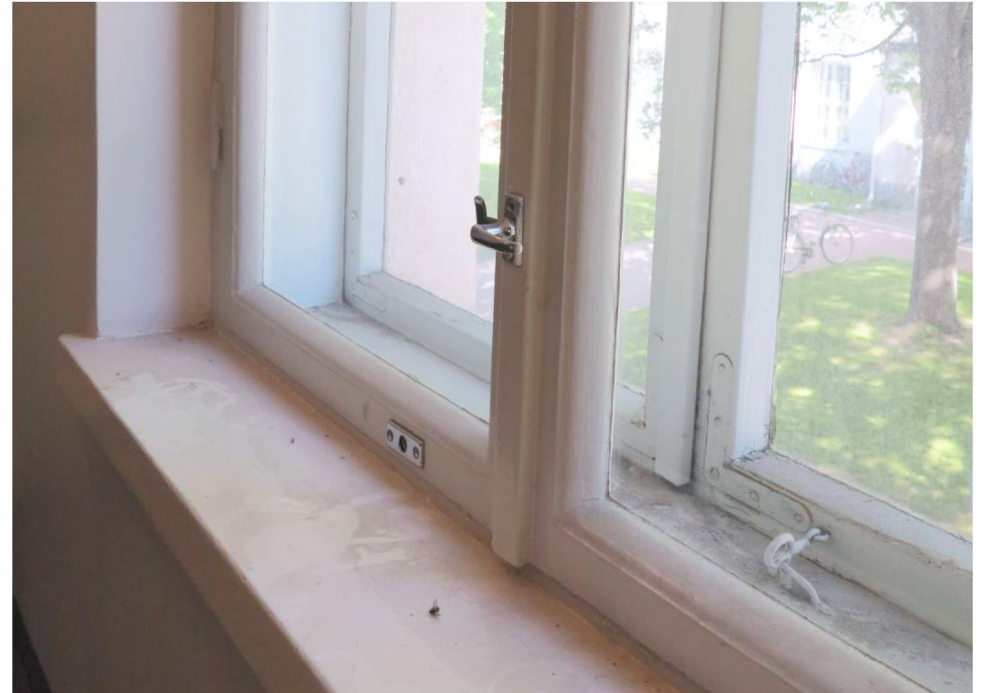
B-portaan vanha sisäikkuna, jossa pyöristetty höyläysprofiili. Osa heloista uusittu
