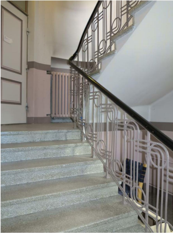
Pääportaan sirot, graafiset takorautakaiteet ja sementtimosaikkiaskelmat ovat alkuperäisiä säilyneitä rakennusosia. Nykyinen väritys tai eri väripintojen sommittelu ei perustu alkuperäisten pintakäsittelyjen tai värien tutkimukseen.
