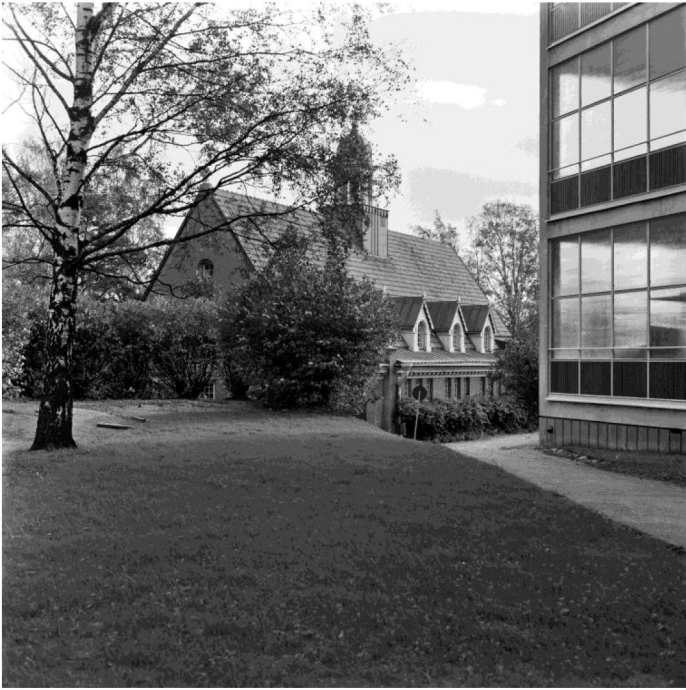
C-rakennuksen uusi parveke ja kappeli 1965 . Valokuva Raija Järvelä, HKM.
