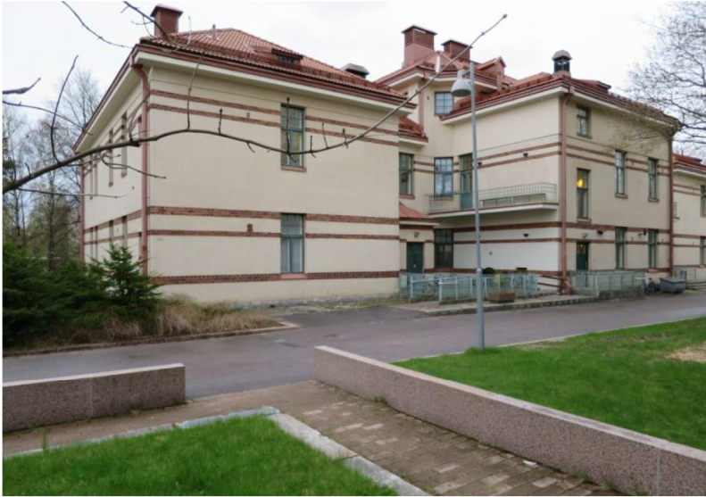
B-rakennuksen länsinurkka ja monimuotoinen koillissivu, piiput on uusittu alkuperäisiä löyhästi soveltaen
