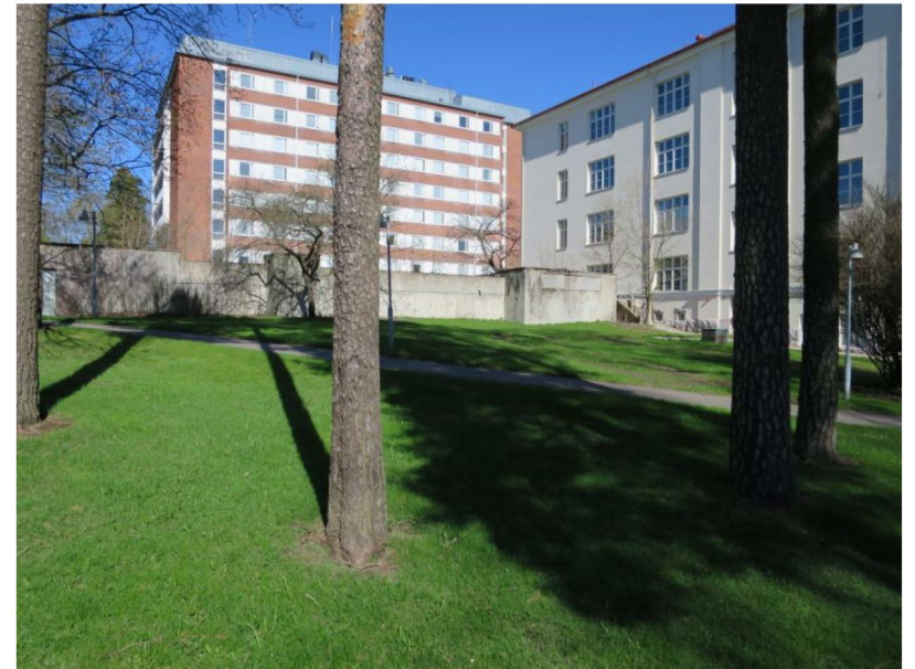
Tilanne 2015. Näkymä kaakosta, oikealla G-rakennus, etualalla väestönsuoja. Katolle on 1990-luvulla rakennettu uusi IV-konehuone.
