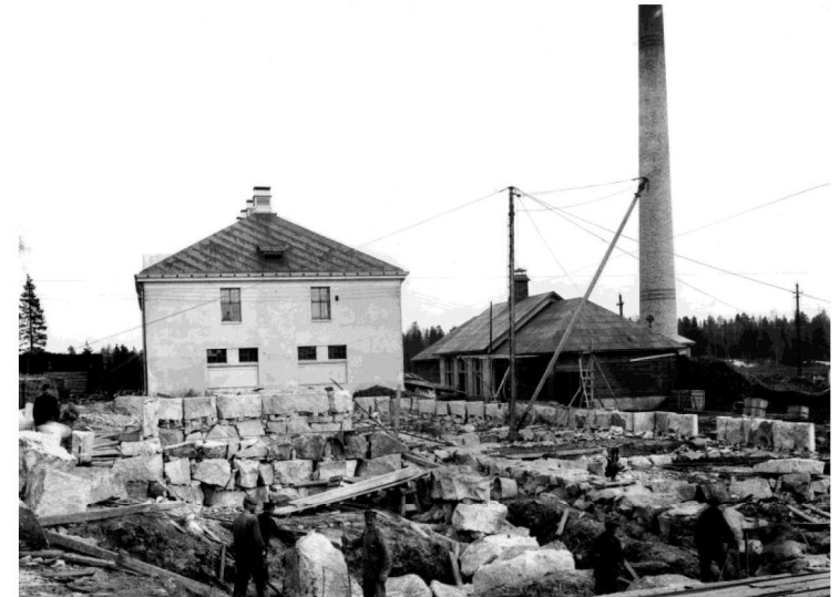
B-rakennuksen kivijalkaa rakennetaan noin vuonna 1910. Taustalla pesularakennus E (huom. tilapäinen huopakatto) ja alueen keskukslämmityksen pannuhuone piippuineen. HKM
