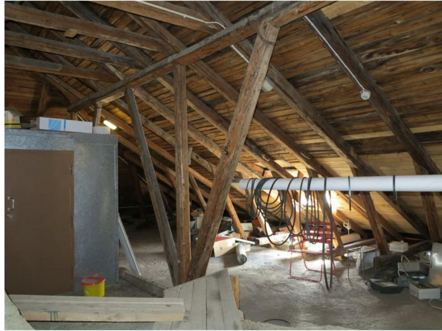
Ullakon vanhoja kattorakenteita. Lämpö- ja palo eristettyjä putkia ja iv-kanavia
