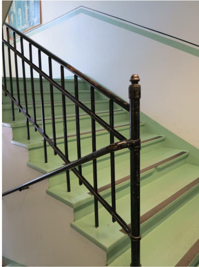
Portaan alkuperäinen kaide ja betoniaskelmat
