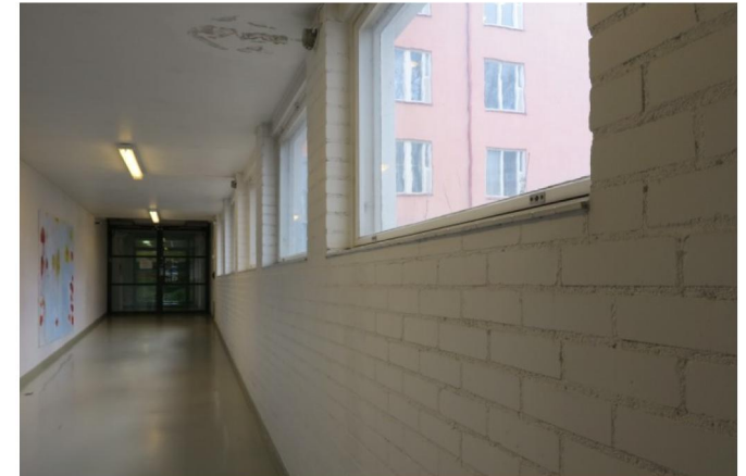
F-rakennuksen sisäänkäyntiin ja maanpinnan tasolle johtava käytävä. Vrt. kuva vasemmalla.
