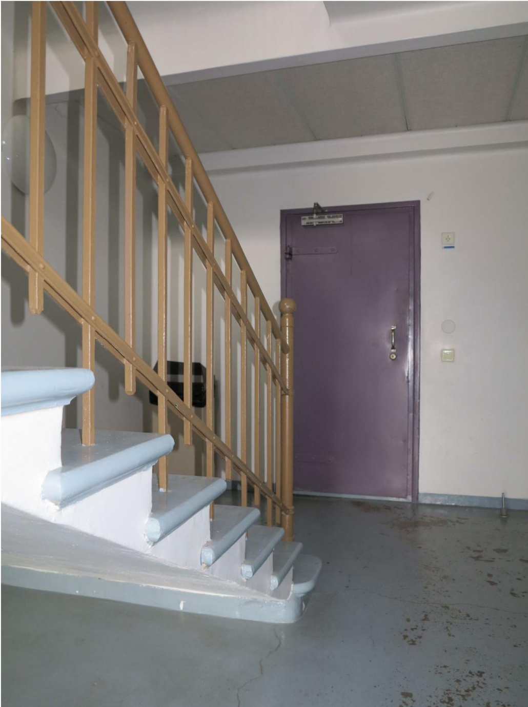
Lounaissivun portaan lähtötaso kellarikerroksessa.
