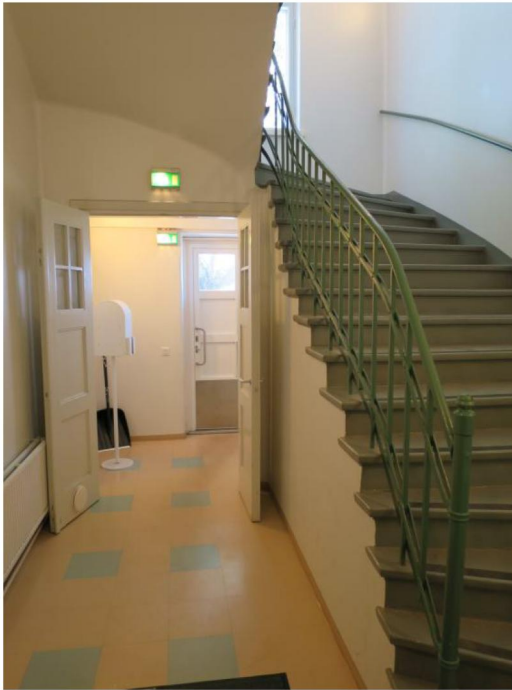
Koillispuolen säilyneen B-portaan 1.kerroksen sisäänkäynti. Uudet, vanhaa mallia myötäilevät puuovet.
