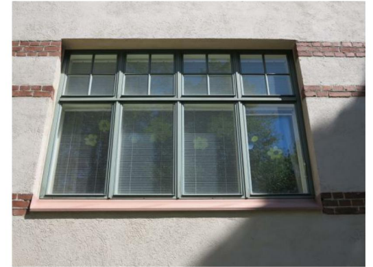
Lounaissivun uusittu ikkuna, vanha puitejako, uusi detailointi ja muutos sisään-sisään aukeavaksi, sisäpuiteessa umpiolasi.
