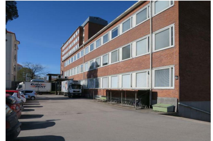
N-rakennuksen toimisto-ruokala-osanhuoltopihalta nähtynä
