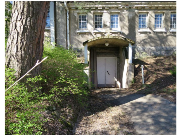
Ovi kellariin. Ovi uusittu, samoin betoniset tukimuurit ja katos uusia
