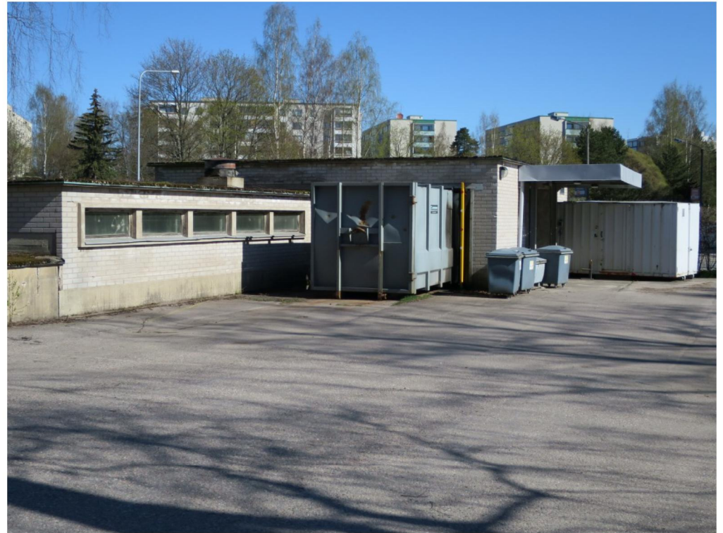
Rikkasäiliö (jäterakennus) ympäristös-ään, vasemmalla N-rakennuksen matalaa osaa.
