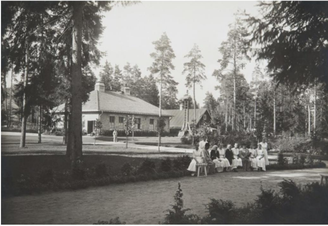
Vanha, 1910-luvun sauna, purettu 1950-luvulla. Nykyisin N-rakennuksen korkea osa sijaitsee samalla paikalla. HKM
