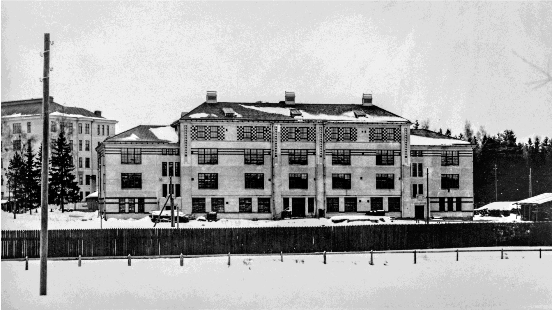
F-rakennus, työlaitos sellaisena kuin se rakennettiin Hård af Segerstadin v.1913 muutospirustusten mukaisesti. Taustalla v.1925 valmistunut G-rakennus. Kuva 1930-luvun alku. HKM
