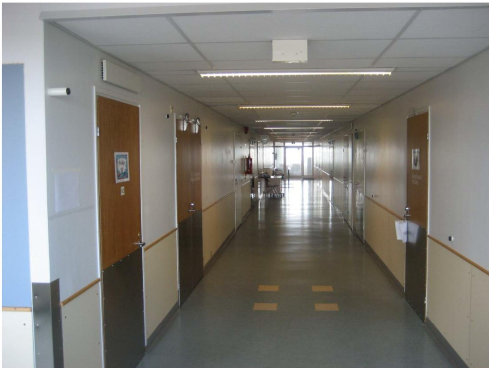
Tyypillinen sairaalakäytävä . Pinnat on uusittu.
