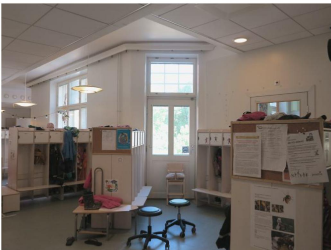
2.krs:n keskushallin vanha ikkuna-aukot ja ovi parvekkeelle, uudet ikkunat ja ovi sekä alakatto.
