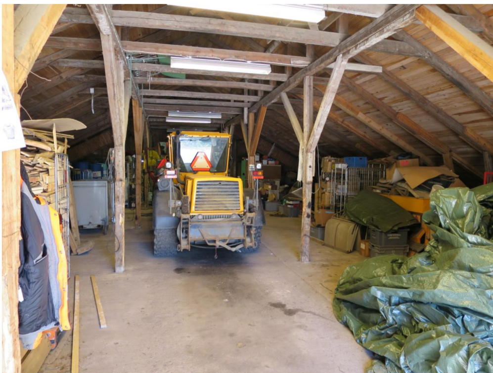
Juurikaskellarin ullakkoa käytetään työajoneuvo- ja kalustovajana
