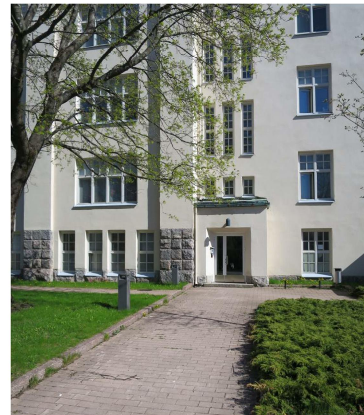
Uusitut ikkunat mukailevat alkuperäistä, 1.-4. kerroksen ikkunajakoa
