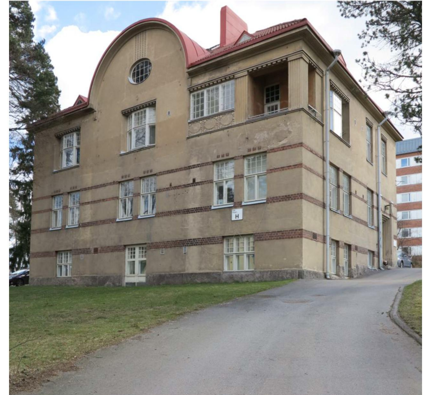
Valokuva luoteesta 2015. Julkisivun yksityiskohdat ovat säilyneet varsin hyvin. Ikkunoiden sävy on nykyään lähes valkoinen. Kellarin keskimäinen ikkuna on muutettu oveksi.
