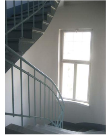
Sivuportaassa on muotoilultaan pelkistetty takorautakaide. Betoniaskelmat on maalattu.
