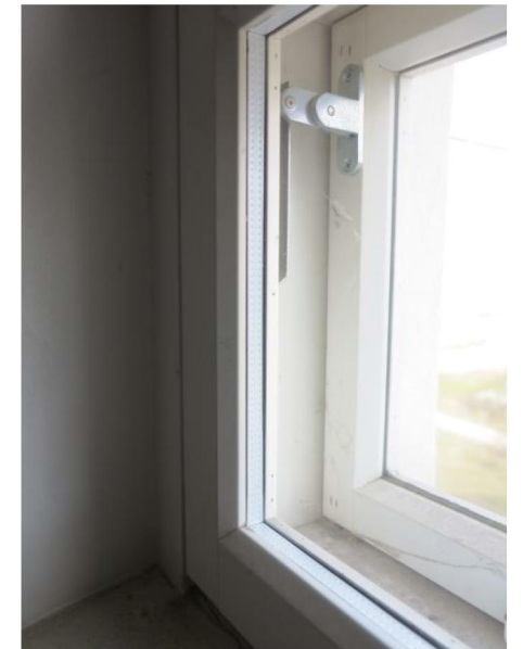
Uusittua 3-kertaista ikkunarakenetta
