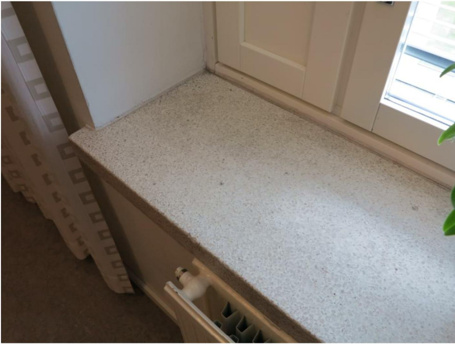
Laajennusten yhteydessä tehty mosaiikkibetoninen ikkunapenkki, uusitti levypatteri ja 2009 uusittua ikkunarakennetta.
