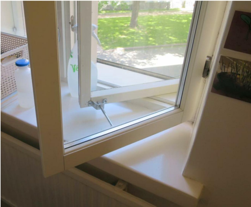
Uusittu ikkuna, sisäpuiteessa umpiolasi.
