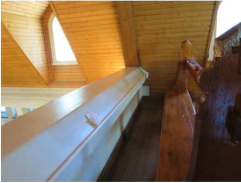
Parven teräsbetonikaide on alkuperäinen. Muoto oli jo määritelty Castrénin palkkisuunnitelmassa.
