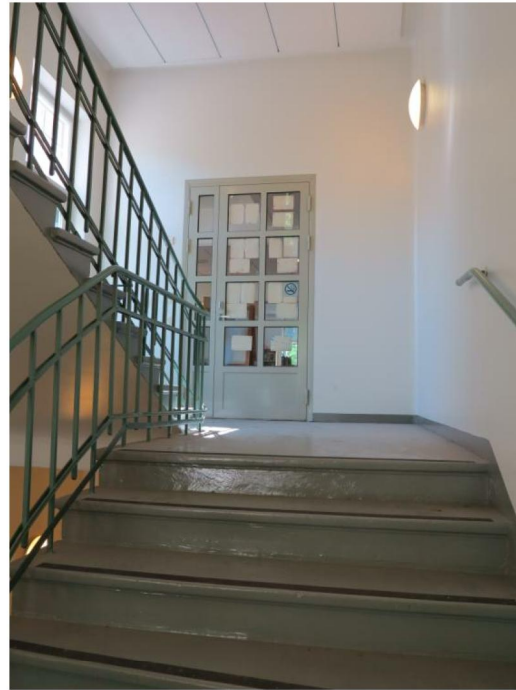
Lounaissivun säilynyt A-porras, kerrostason palo-ovi, lk E30.
