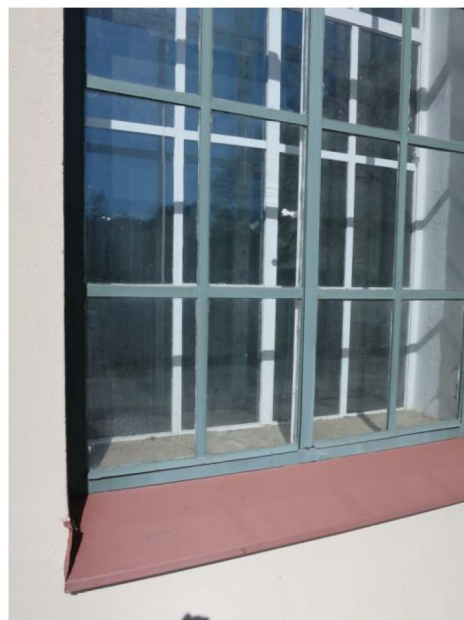
Lounaissivun alkuperäinen siro teräsikkuna. Lasit on kiinnitetty kittaamalla T-profiilin sisäpuolelle.
