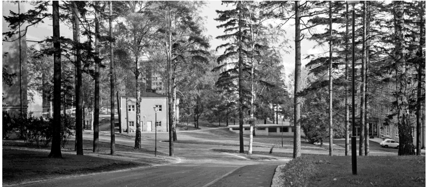
Kuva kohti F-rakennuksen luoteispuolen piha-alueita, luultavasti v. 1965. Taustalla tunneliin liittyvä rakennus. (Alkuperäisen kuvan osa) C. Grünberg HKM.
