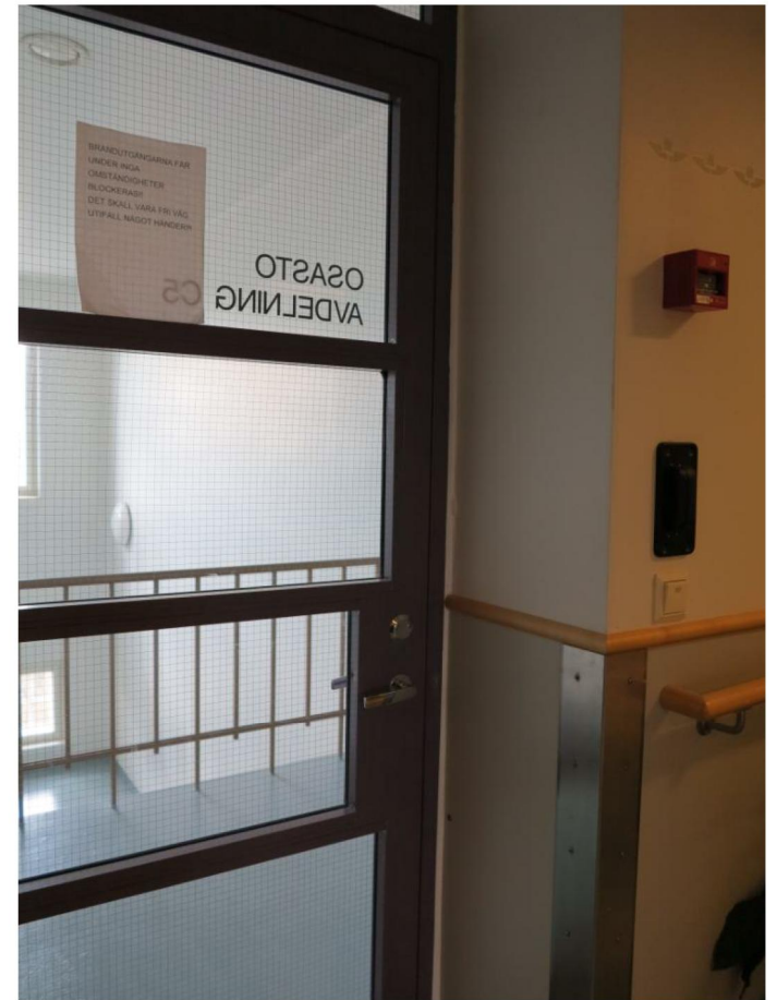
Portaan uusi teräs-rautalankasiovi, 5.kerros
