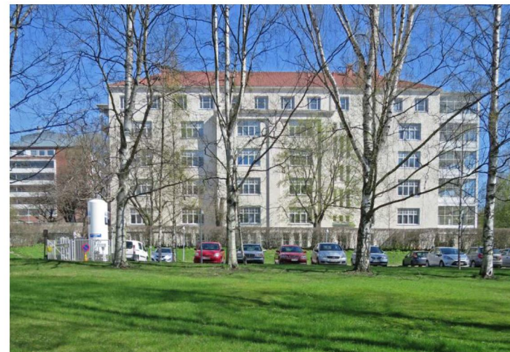
Uusitut ikkunat mukailevat alkuperäistä, 1.-4. kerroksen ikkunajakoa
