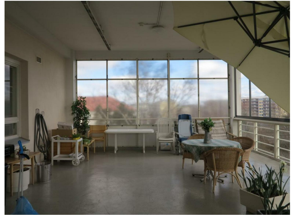
Lasitettu parveke kaakkoispäädyssä. Sivuseinillä kiinteät, vanhemmat rautalankalasetut seinät, pitkällä etuseinällä uusittu kirkas kaidelasi, yläpuolella avattava liukulasitus .
