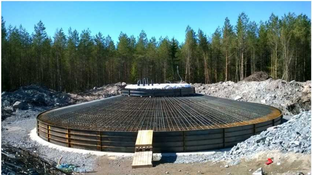
Kuva 2-3. Maanvaraisen perustuksen raudoitus ennen betonin valamista. (Kuva: Mira Hulkkonen / Pöyry)
